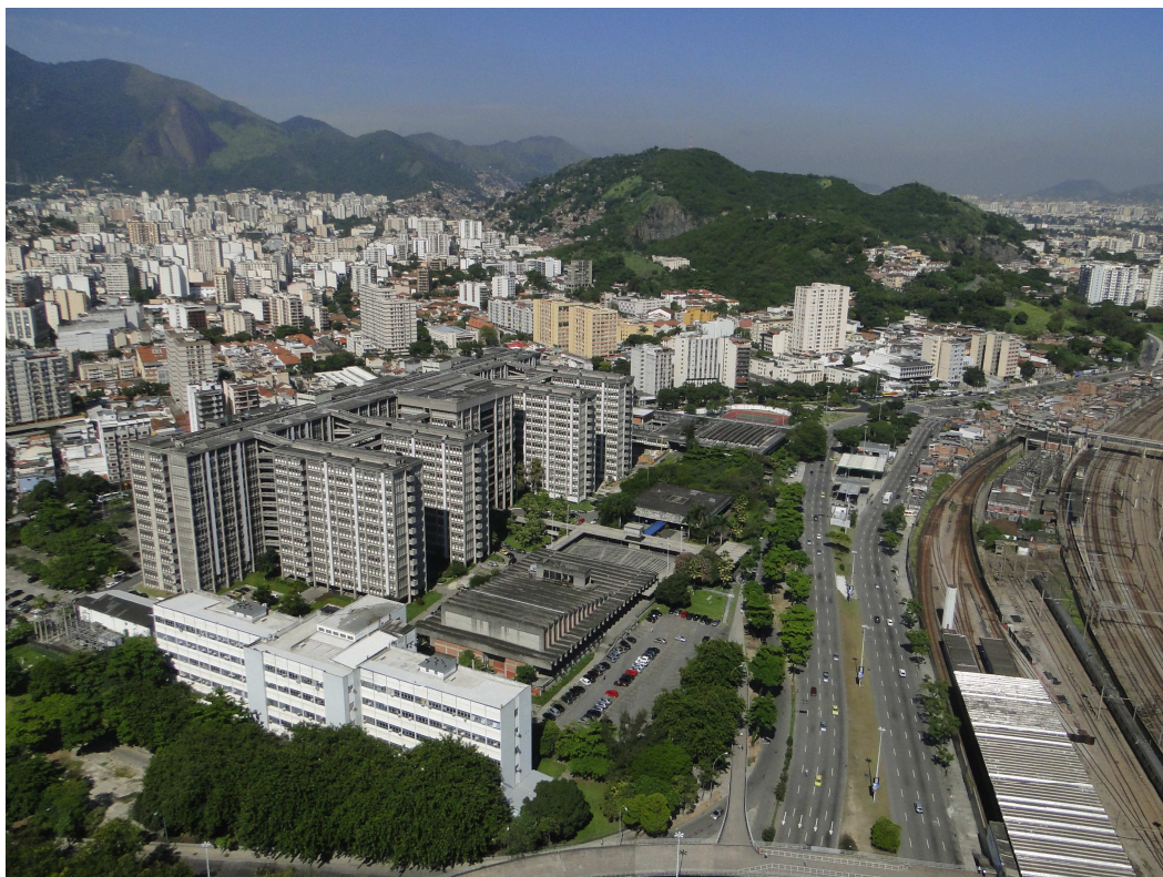
Figura 34 – Vista aérea do Campus da UERJ, com a linha férrea à direita. Fonte: Foto da autora, 2010.
