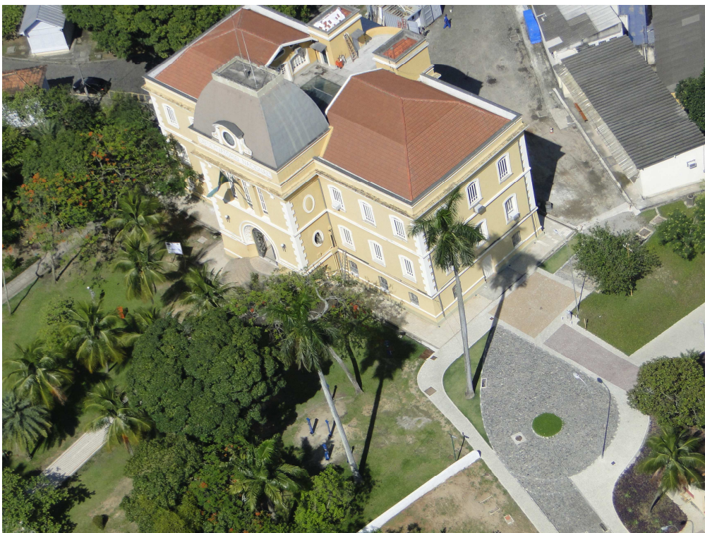
Figura 29 - Vista aérea do edifício da sede do MAST. Fonte: Foto da autora, 2010.
