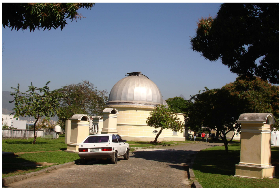
Figura 54 – Área das cúpulas. Fonte: Foto da autora, 2010.
