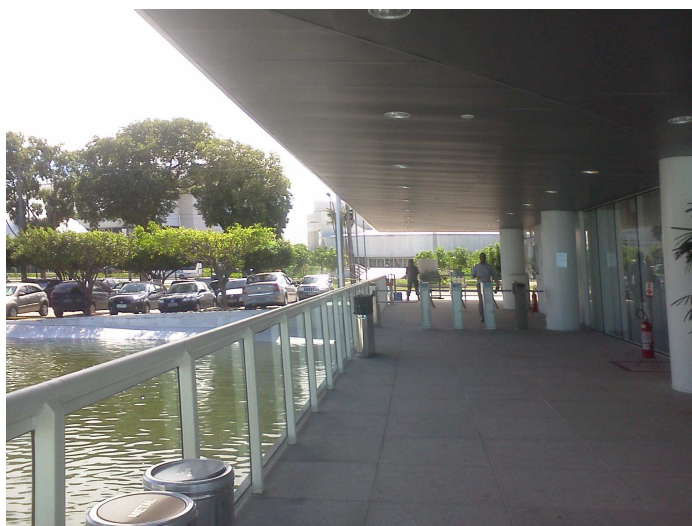
Figura 67 – Corredor de acesso. Fonte: Foto da autora, 2011.
