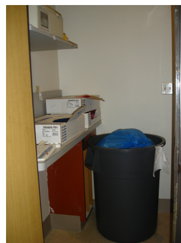
Figura 95 – Foto da sala de utilidades Fonte: o autor, 2009.
