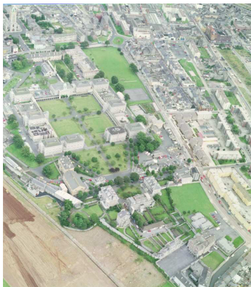
Figura 1 – Vista aérea do Royal Naval Hospital
