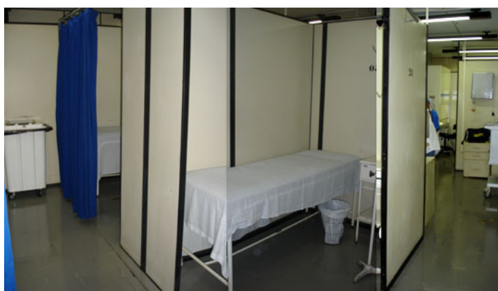
Figura 33 – Unidade de Hospital-Dia de Infectologia com boxes privados executados com divisórias de Eucatex Fonte: o autor, 2008.
