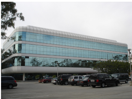
Figura 76 – Foto da fachada posterior do edifício, junto a qual se encontra o estacionamento e o acesso principal
