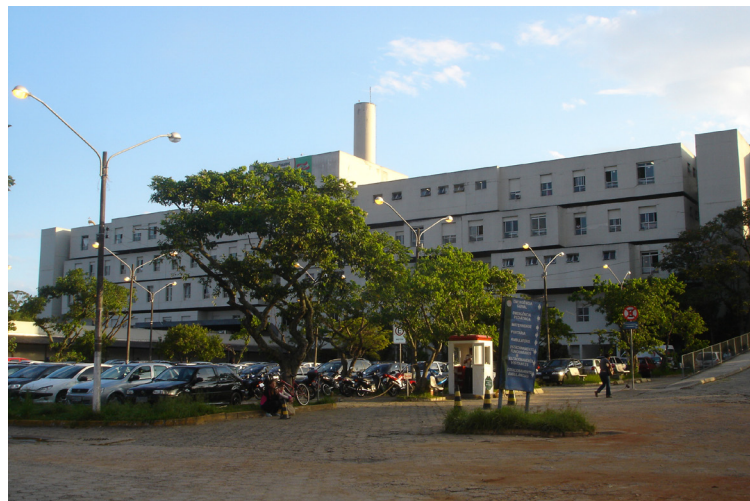
Figura 63 – Foto da fachada externa do Hospital Regional de São José Fonte: o autor, 2009.
