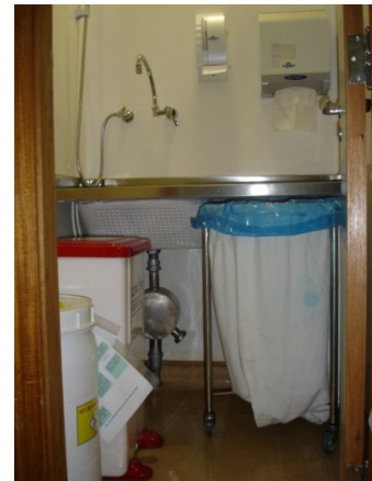
Figura 152 – Sala de utilidades com tanque e recipientes de lixo Fonte: o autor, 2008.
