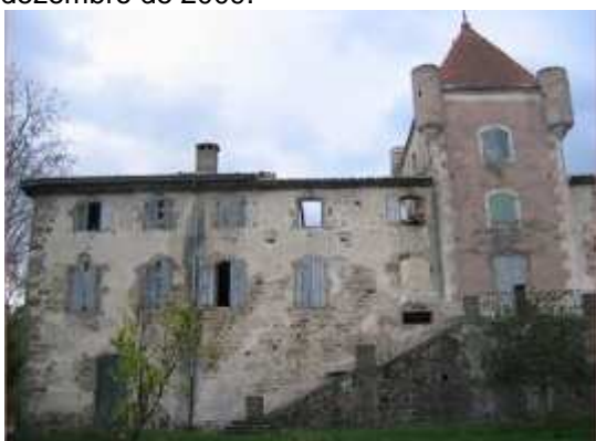
Figura 59: Fachada principal do Château de Rochemure antes da intervenção, em 2007. Fonte: http://www.viviers-facades.com . Acesso em 15 de dezembro de 2009.
