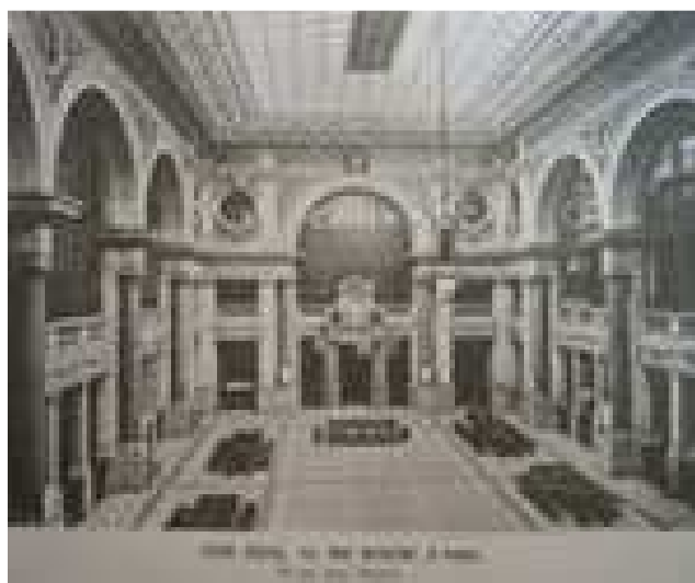
Figura 31: Hall de entrada, com pavimentação de vidro. Fonte: BNP Paribas. Disponível em: http://bank.bnpparibas.com/en/pid643/1851-1913-cnep.html . Acesso em 14 de dezembro de 2009.
