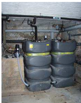
Figura 45: Cisternas de recuperação das águas de chuva. Fonte: Agence de Développement et d'Urbanisme de Lille Métropole, 2006, p. 61.
