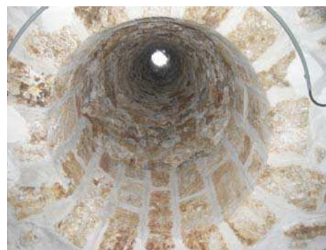
Figura 65: Interior do Fort du Haut-Buc . Fonte: GROUPEMENT ASSOCIATION APACH – AR ARCHITECTES, 2009, p.8.
