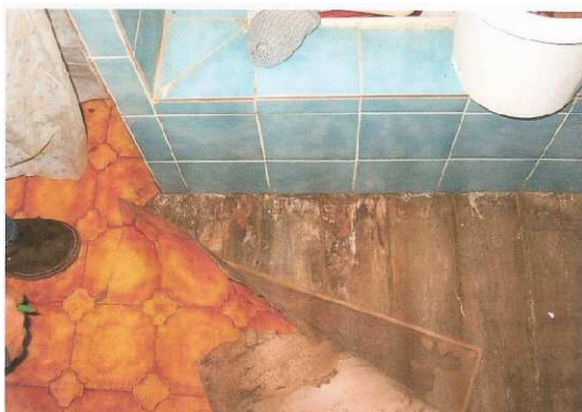
Figura 22: exemplo de dano identificado nos edifícios de Brest. Fonte: HENNO, Olivier, 2005.
