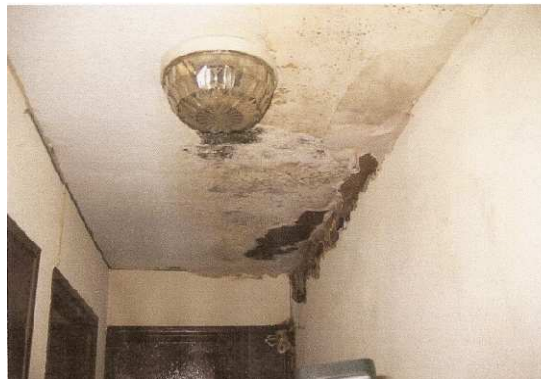
Figura 23: exemplo de dano identificado nos edifícios de Brest. Fonte: HENNO, Olivier, 2005
