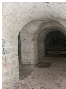
Figura 64: Interior do Fort du Haut-Buc . Fonte: GROUPEMENT ASSOCIATION APACH – AR ARCHITECTES, 2009, p.8.
