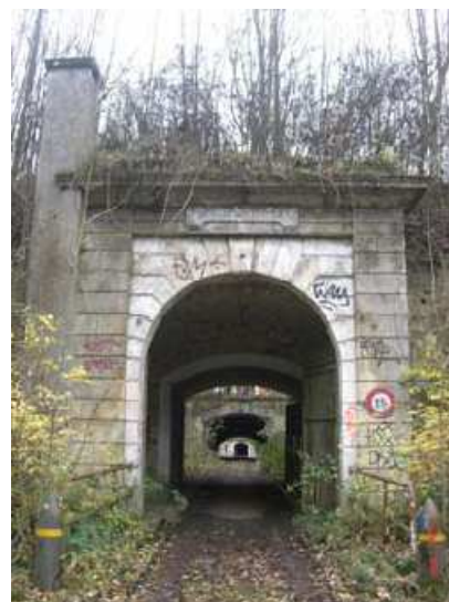
Figura 62: Entrada do Fort du Haut-Buc. Fonte: GROUPEMENT ASSOCIATION APACH – AR ARCHITECTES, 2009, p.6.
