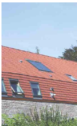
Figura 46: Painéis solares instalados na cobertura e orientados para sudeste. Fonte: Agence de Développement et d'Urbanisme de Lille Métropole, 2006, p. 62.
