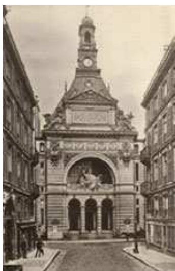
Figura 30: BNP Paribas, na Rue Bergère , nº 14. Fonte: BNP Paribas. Disponível em: http://bank.bnpparibas.com/en/pid643/1851-1913-cnep.html . Acesso em 14 de dezembro de 2009.
