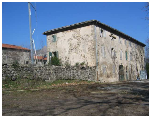
Figura 58: Fachada leste do Château de Rochemure em obras. Fonte: http://www.maison.parc-monts-ardeche.fr . Acesso em 15 de dezembro de 2009.
