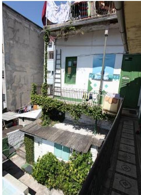
Fig. 57 e 58: Fachada dos fundos da casa com o acréscimo lateral à direita. Em destaque, a varanda que foi fechada, restando apenas um pequeno corredor e o gradil. O terraço acima permanece.
