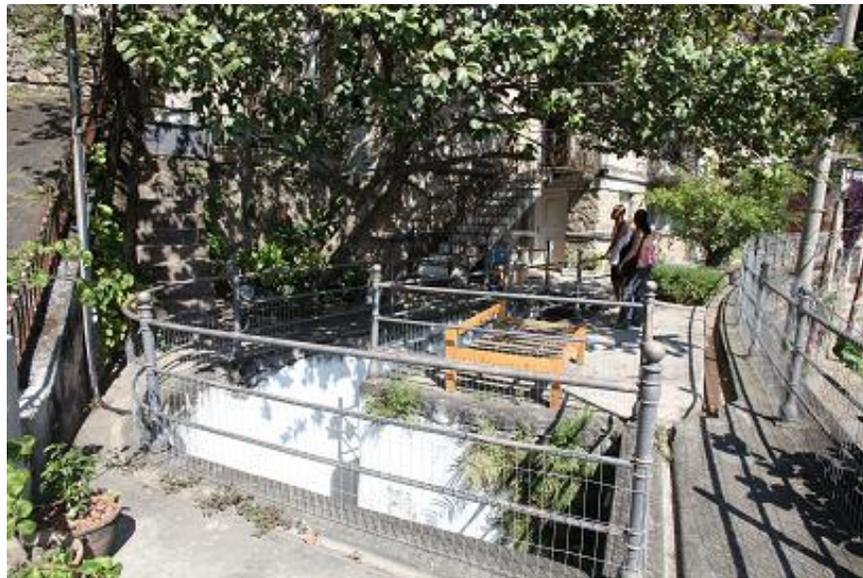
Fig. 212: Terraço frontal situado sobre o embasamento revestido com pedra rústica.
