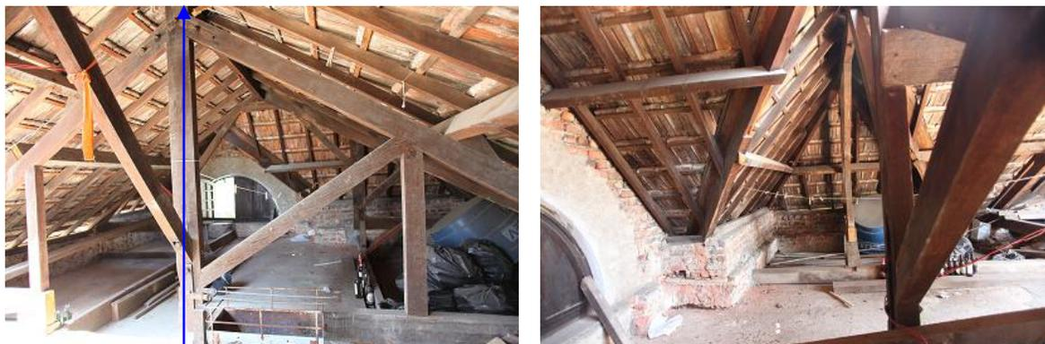
Fig. 139: Fotos da complexa estrutura do telhado com a altura elevada dos pontaletes
