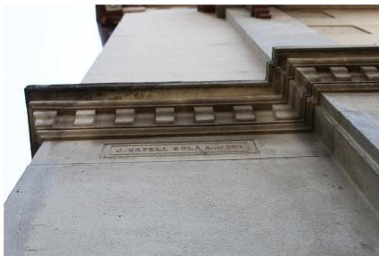
Fig. 91: A solução em denticulo que assinala a separação entre os pavimentos
