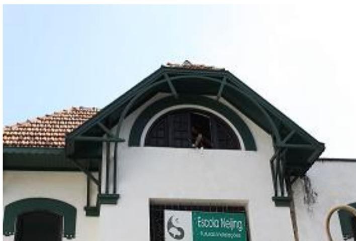
Fig. 131: A estrutura em madeira ainda intacta do frontão do telhado
