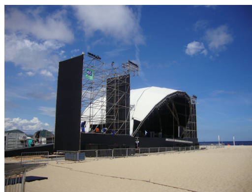
Figura 10: Palco sendo construído para a realização do Réveillon 2010
