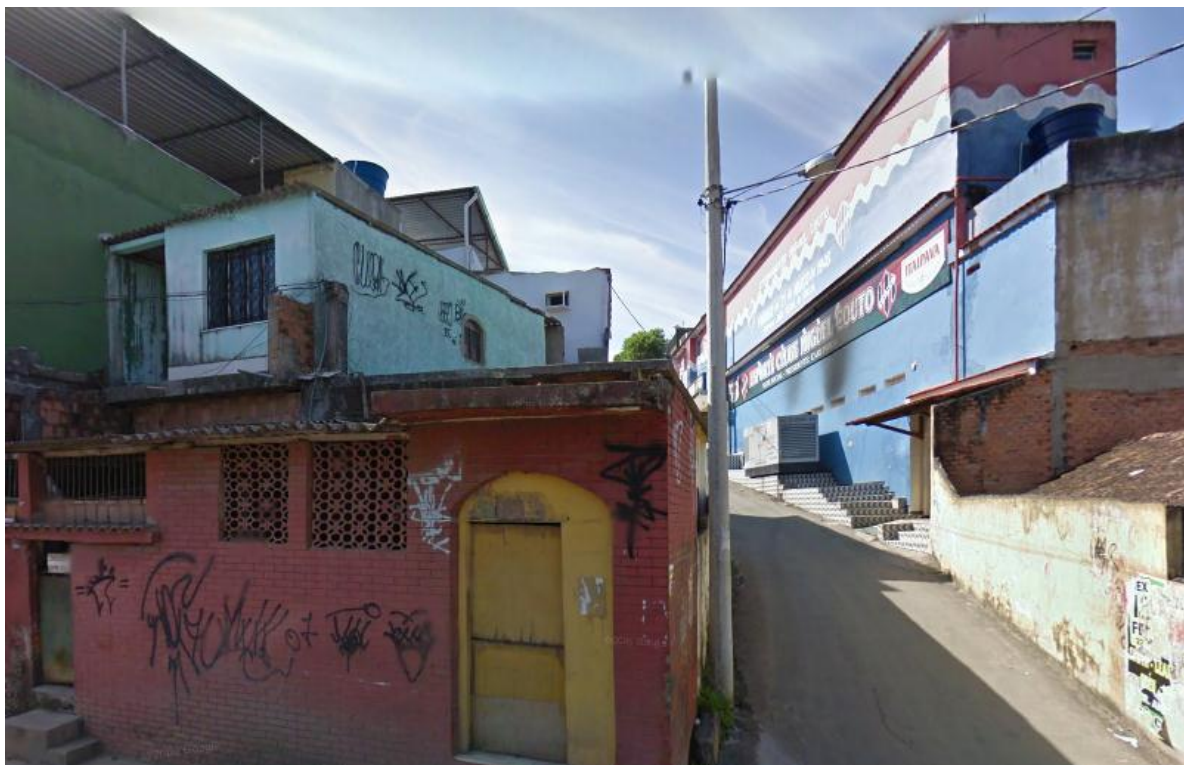
Imagem 45 – Clube Miguel Couto visto a partir da Rua Cameron Fonte: Google Maps. Acesso em 09/02/2011.
