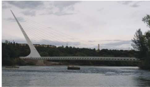
Turtle Bay Sundial Bridge, California, EUA, 2004. Projeto: Santiago Calatrava Fonte: www.structurae.com.br
