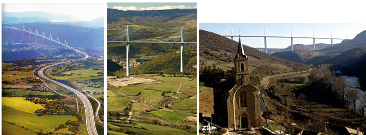
Figuras 406, 407 e 408 – o Viadut Millau inserido na paisagem. Fonte: “Le Viadut de Millau”. Midi Libre Centre Press, Hors Série Special, nº1 e nº2, janeiro de 2005, Paris, França.
