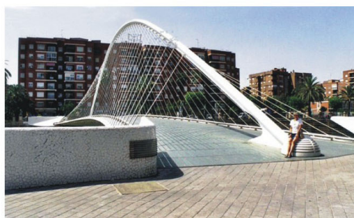
Passarela Jorge Manrique, Murcia, Espanha Foto: Robert Cortright - www.structurae.com
