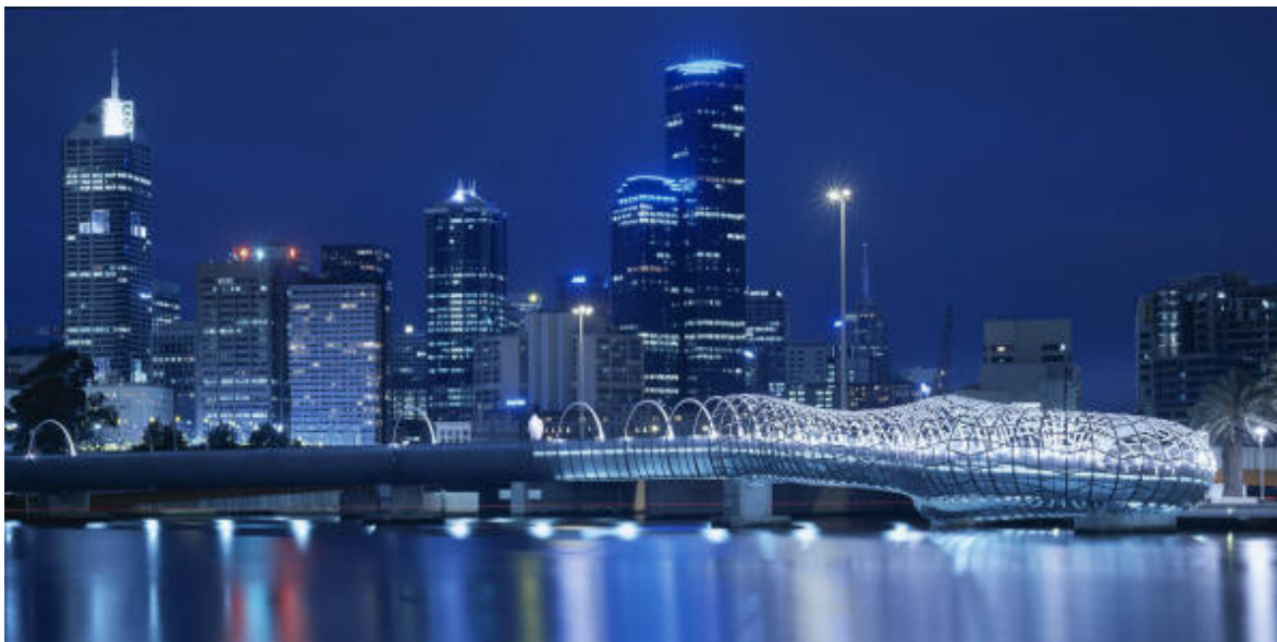
Figura 398 - A forma exuberante e autônoma da Webb bridge em Melbourne, projeto de Denton Corker Marshall. Imagem: http://www.xenian.com.au/photogallery/Webb%20Bridge.htm
