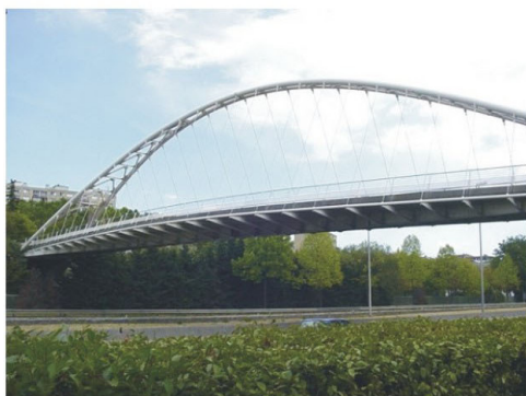
Passerelle de Créteil, França Foto: Gérard Métron - www.structurae.com
