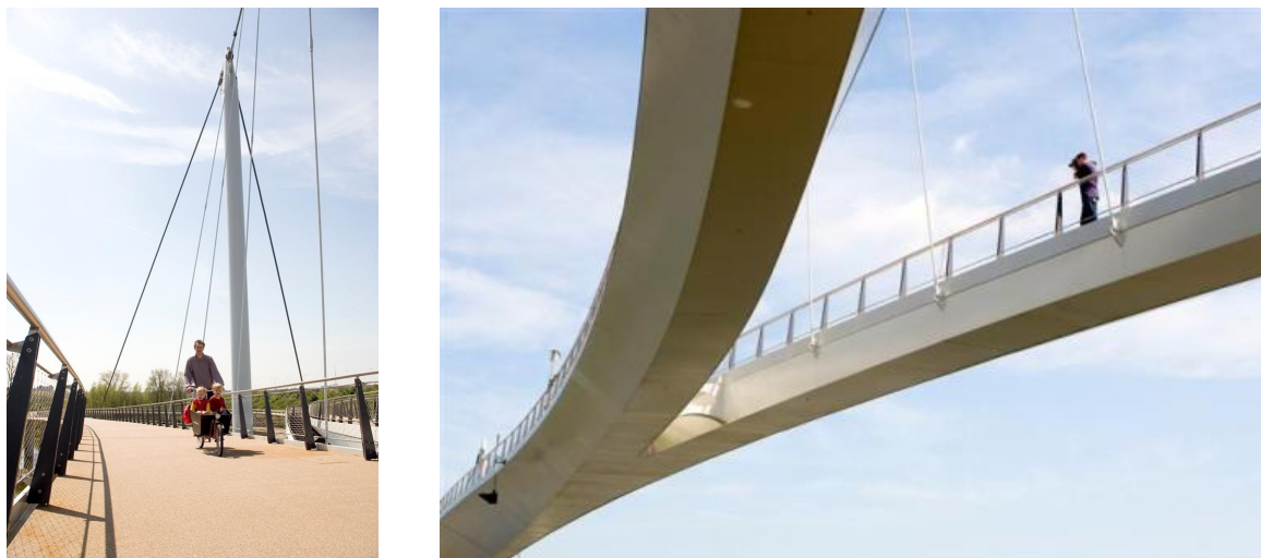
Figura 491 e Figura 492 - Fotos: Michael van Oosten. Fonte: http://www.archello.com/en/project/nescio-bridge/8568
