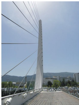
Katehaki Bridge, Atenas, Grécia Projeto: Santiago Calatrava Foto: Inge Kanakaris-Wirtl www.structurae.com
