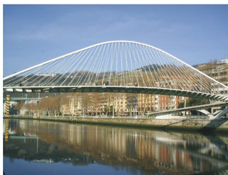
Passarela Campo Volantim ou Zubi-Zuri, Bilbao, Espanha. Foto: Vera Hazan
