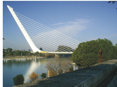
Ponte Alamillo, Sevilha, Espanha, 1992. Projeto: Santiago Calatrava Foto: Vera Hazan, 2008.
