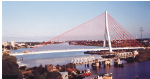
Third Millennium John Paul II Bridge, Gdansk, Polônia . Projeto: Biuro Projektów Budownictwa Komunalnego S. A. Foto: Demathieu et Bard / Mosty Lodz www.structurae.com
