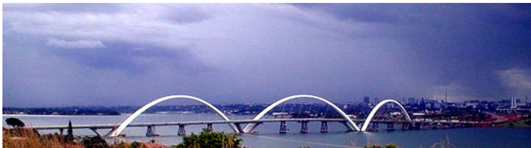
Figura 380 - Imagem da Ponte JK ao entardecer. Fonte: www.metalica.com.br/ponte-jk
