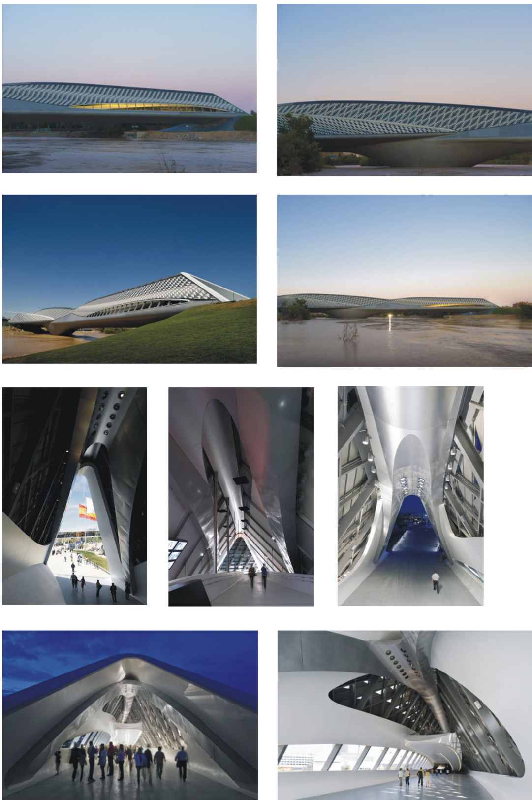
Figuras 548, 549, 550, 551, 552, 553, 554, 555 e 556 – imagens internas e externas no pavilhão ponte.
