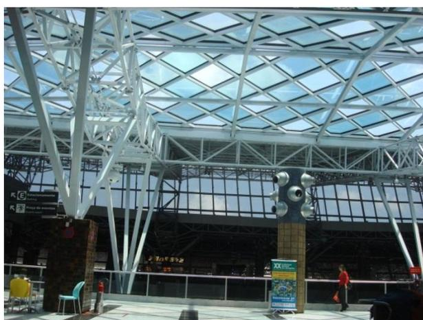
Figura 82: A cobertura, os pilares e o totem com as saídas de ar.
