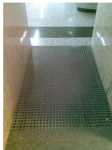
Figura 178: Troca de piso do emborrachado tipo Plurigoma para um granito polido.
