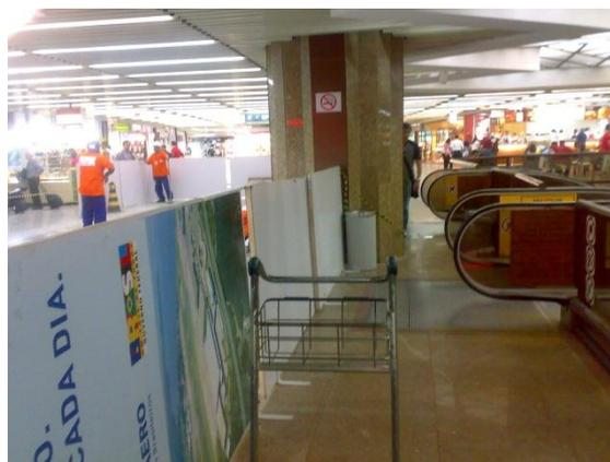
Figura 177: Tapumes para isolamento para a obra do piso.
