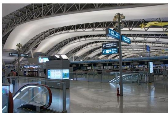
Figura 99: Canaleta de distribuição de ar do Terminal de Kansai, Japão.
