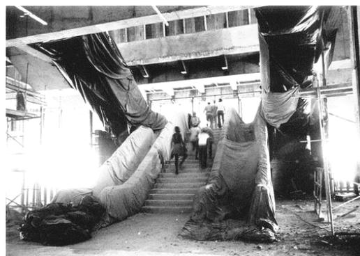
Figura 152: Instalação de escadas rolantes
