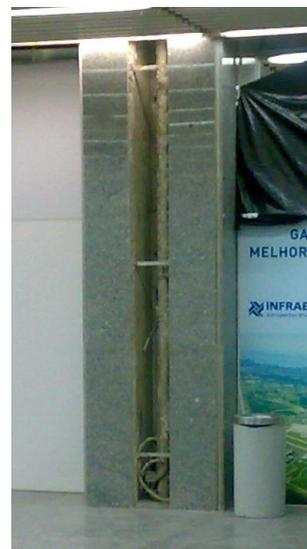
Figura 98: Pilar com rebaixo para a passagem de instalações.
