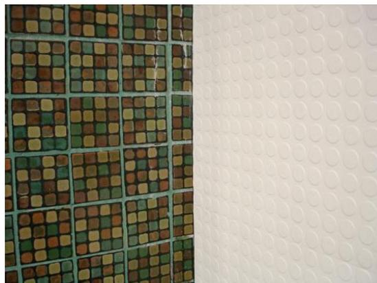
Figura 179: Dois revestimentos de paredes: cerâmica à esquerda e placas emborrachadas do tipo Plurigoma branca à direita.
