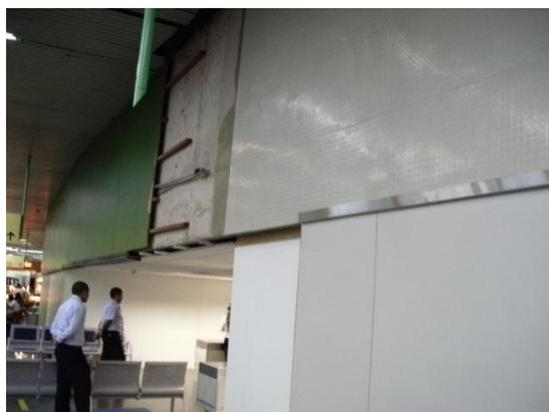
Figura 162: Substituição das reguas metálicas por placas emborrachadas.
