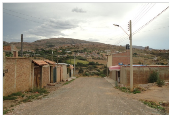
Vista sul - Rua Inominada
