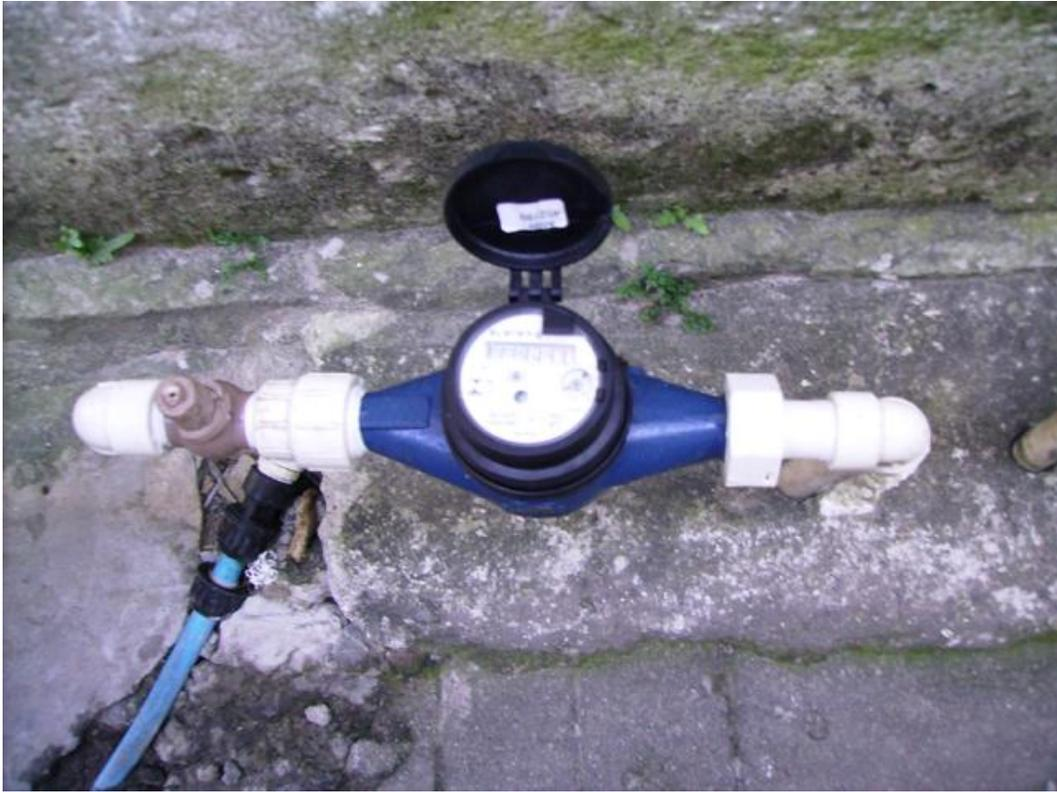
**FOTO 9: Imagem de um dos hidrômetros instalados**
