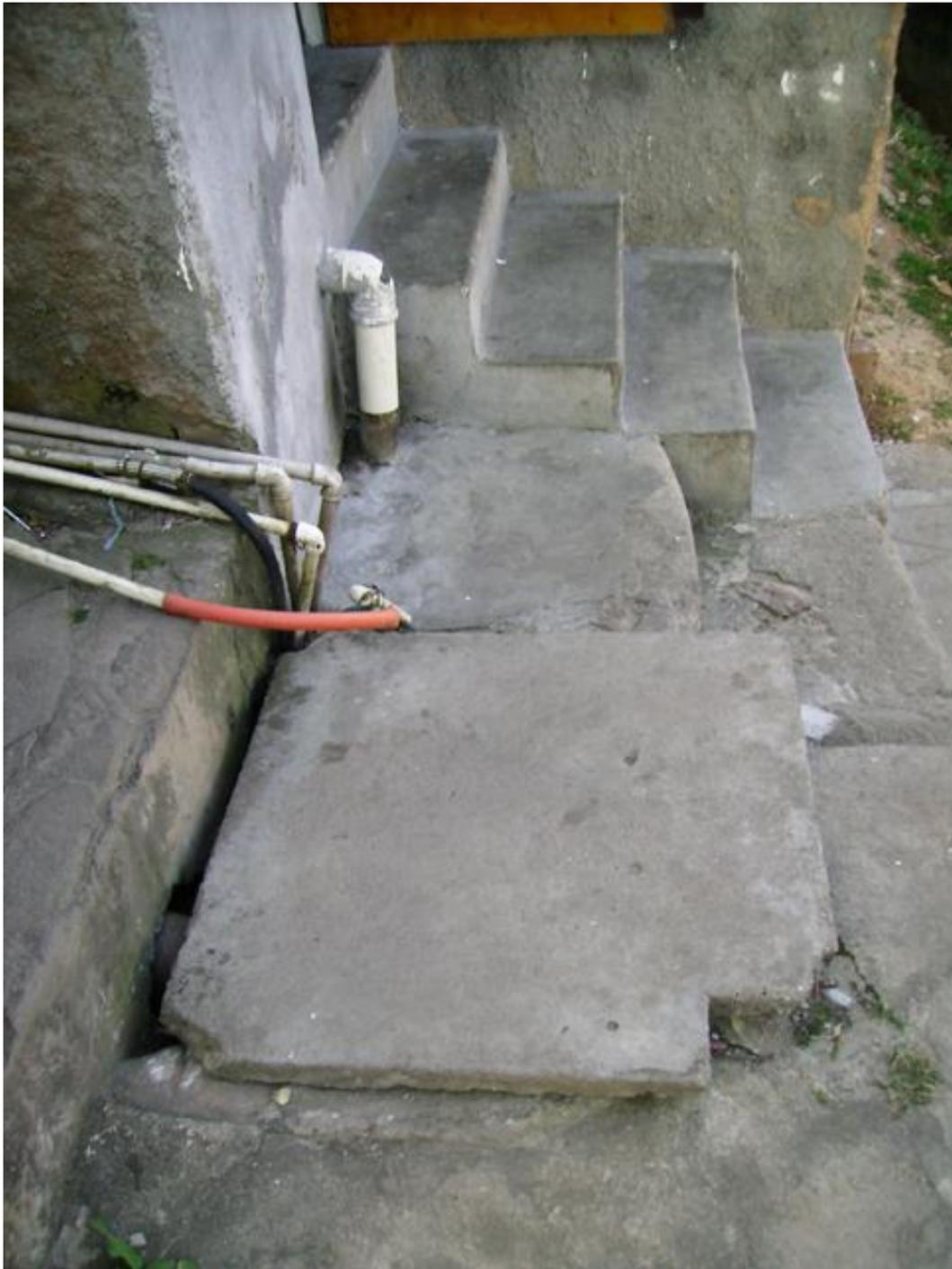
**FOTO 17: A imagem mostra a caixa de passagem de esgoto construída pela municipalidade. Os canos que entram nela são os antigos canos de abastecimento de água instalados pela comunidade para obter a água da CEDAE da base do morro.**
