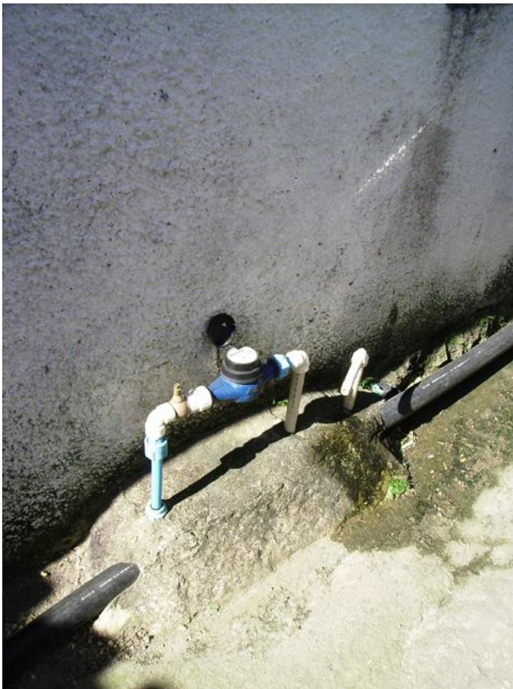
**FOTO 15: As imagens mostram a perda da água na passagem do cano para a mangueira**
