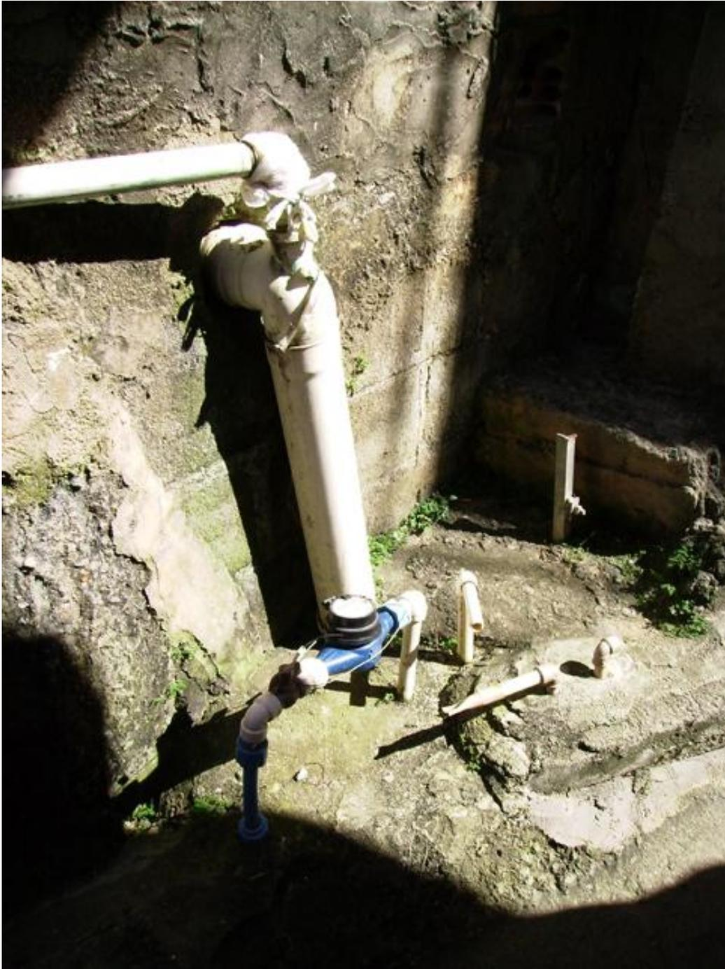
**FOTO 18:** A imagem mostra o hidrômetro comunitário instalado na base de um tubo de esgoto. Repare que o tubo de esgoto foi “espetado” no joelho por outra tubulação de esgoto de outra casa. A mesma também já apresenta problemas de vazamento na conexão, o qual foi solucionado com a amarração de um saco plástico.
