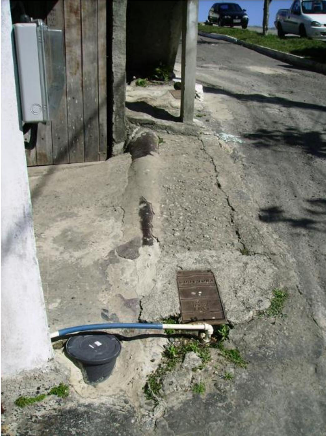
**FOTO 21: Hidrômetro individual instalado em uma das casas que circundam os limites do Morro da Boa Vista e que são acessíveis por carro. Repara-se que o mesmo é instalado no chão e o sistema de entrada de água para a residência é também feito por mangueiras.**
