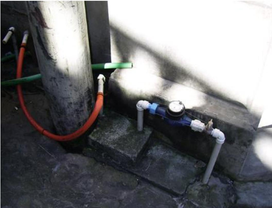
**FOTO 14: Mangueras conectadas nos hidrômetros**
