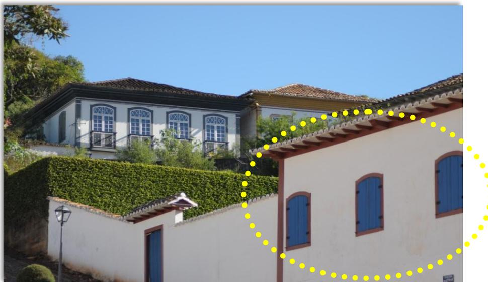
Figura 17. No casarão à direita, notam-se as folhas de vedação das janelas fechadas pela parte externa dos vãos.
