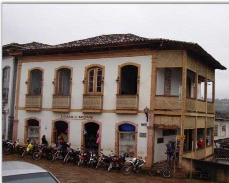
Figura 114. Sobrado no núcleo histórico com estrutura autônoma de madeira e esquadrias em pintura imitando mármore.
