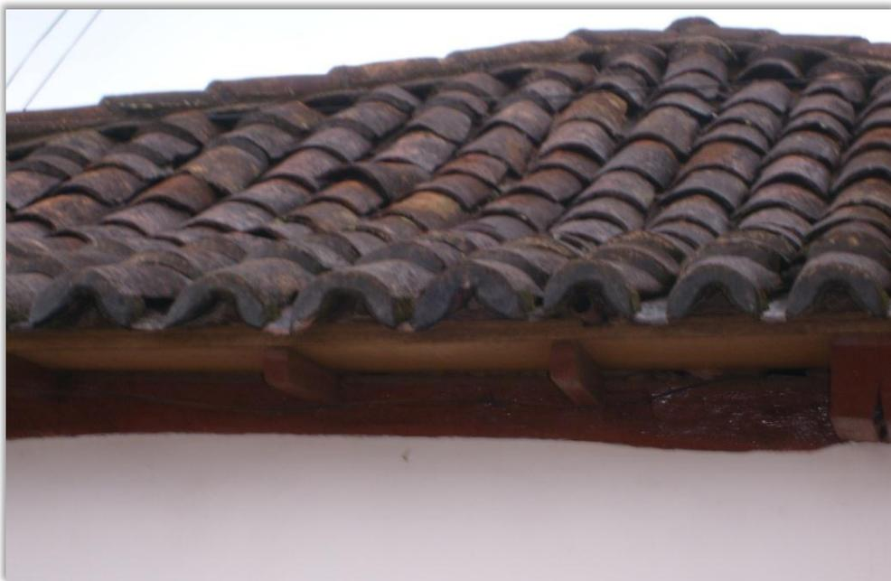
Figura 16 Detalhe de telhado no centro histórico onde se nota a mudança de inclinação em sua extremidade (contrafeito).
