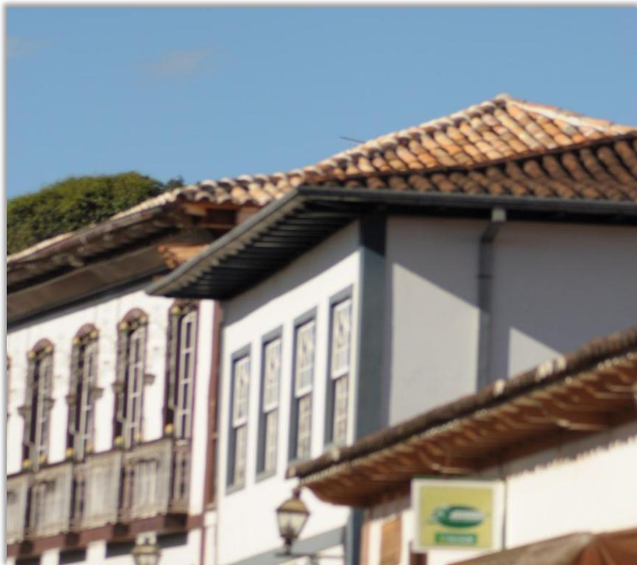
Figura 14. Detalhe de dois casarões do centro histórico onde é possível notar os amplos beirais dos telhados, bem como a presença de contrafeitos em suas extremidades.
