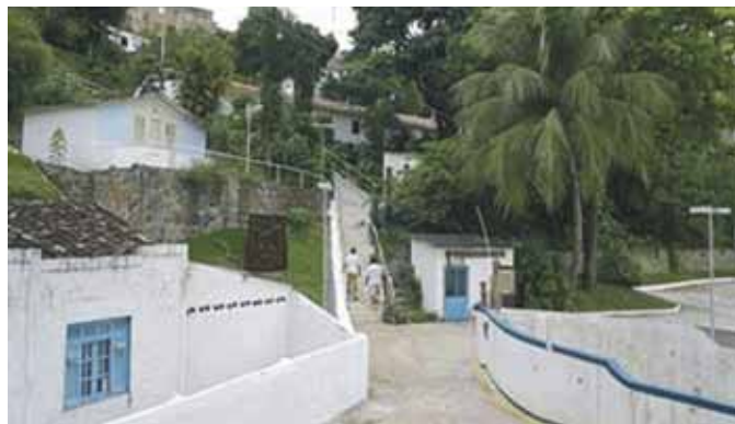
Figura 41 - Conjunto de construções e espaços livres Terreiro da Casa Branca - Bahia Fonte: http://mundoafro.atarde.com.br
