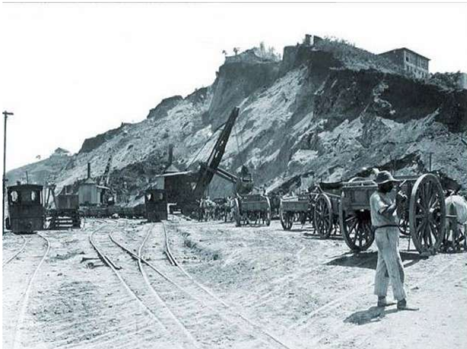
Figura 5: Trabalho de desmonte, década de 20.
