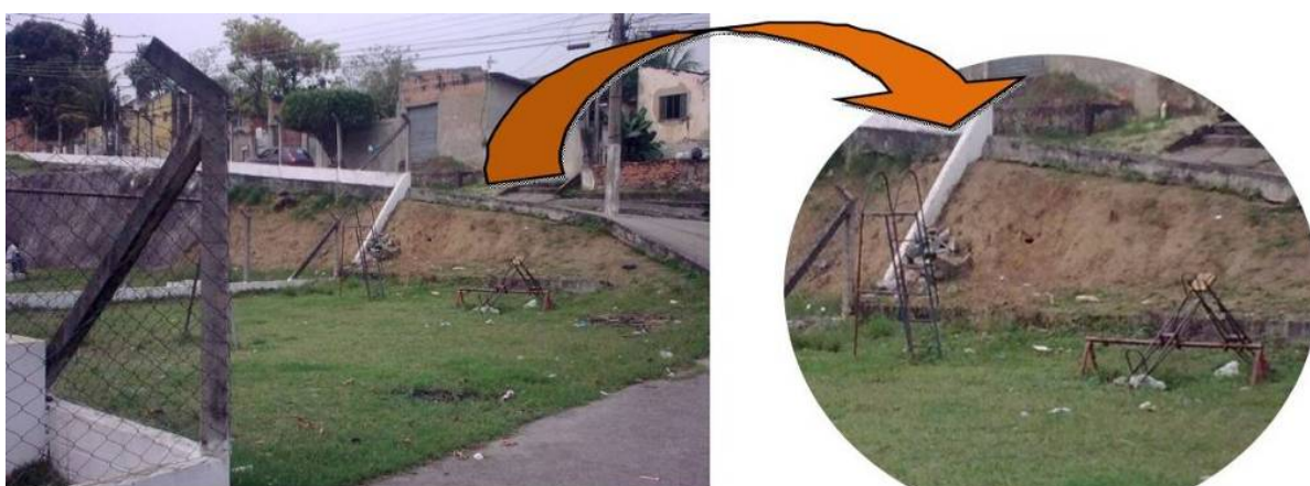
Figura 56: Playground localizado aos fundos da AACD de Nova Iguaçu (acervo pessoal, 2010)
