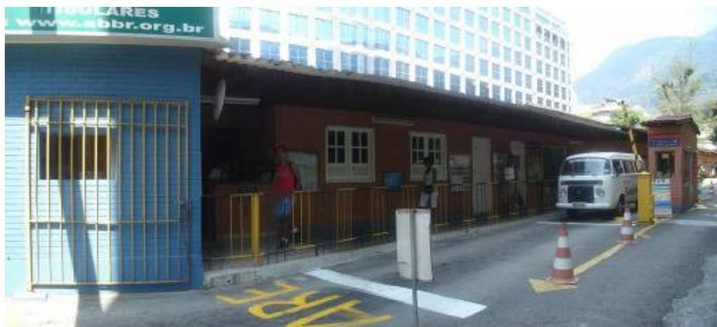
Figura 05: Entrada / guarita de controle para veículos (Autor, março/2009)
