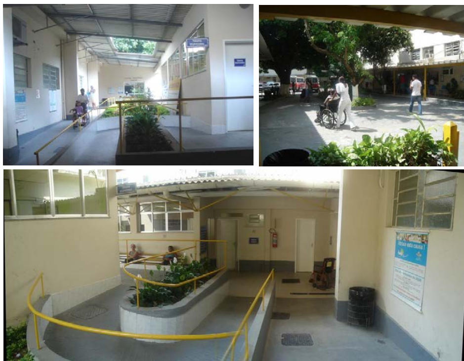
Figura 17: Acessos com vegetação, iluminação e ventilação natural, aos blocos (Autor, março/2009)
