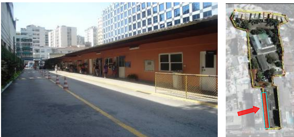
Figura 06: Acesso principal e salas diversas do primeiro bloco (Autor, março/2009) e sua localização no terreno
