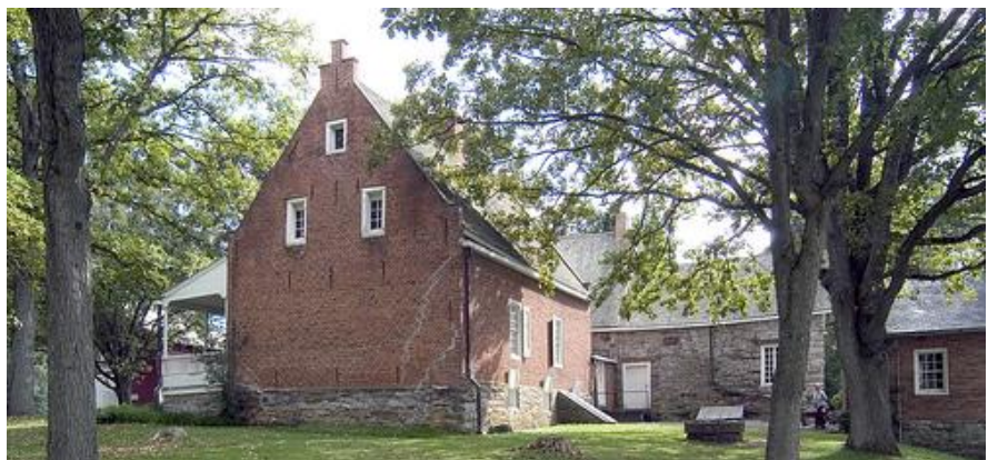
Fig. 35. Bronck House (1663) – Vista da parte posterior da casa onde se percebe a alta inclinação do telhado e o frontão tão característico das casas Holandesas
