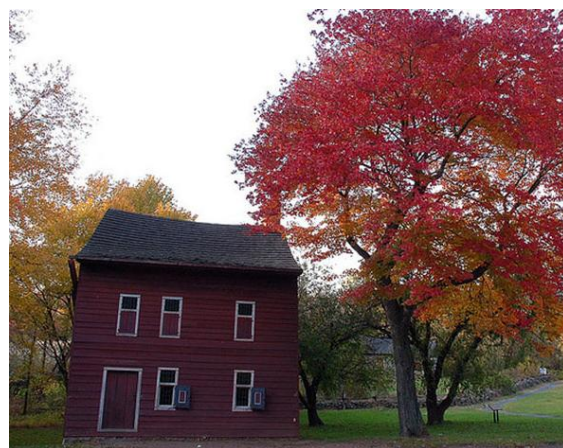
Fig. 25. Voorlezer School - Considerado o edifício escolar mais antigo conhecido na costa leste americana. Data provável de construção 1680.
