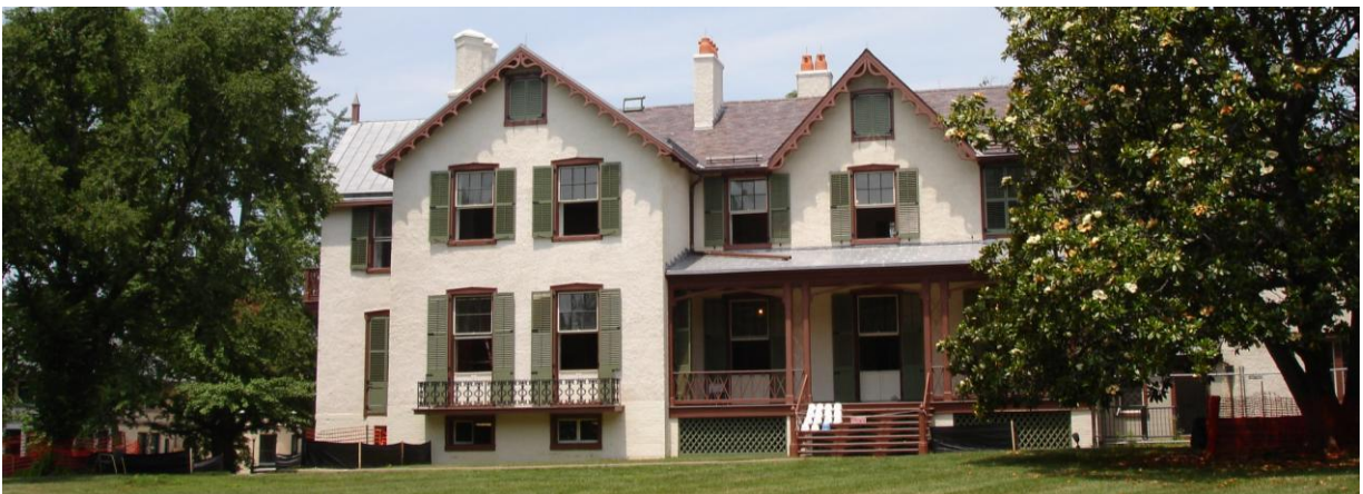
Fig. 12. Vista da Fachada sul do Lincoln Cottage durante restauração. Visita a obra feita em 07.06.2007 – foto da autora
