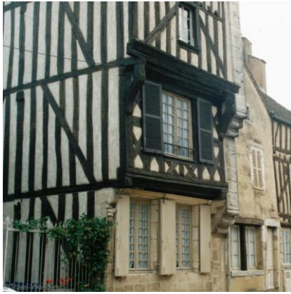
Fig. 31 Estrutura em enxaimel – França
