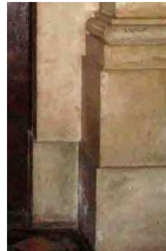
Figura 143: Rodapé em mármore, salão nobre. Palácio Itamaraty. Fonte: Foto de Marisa Hoirisch, 2012.
