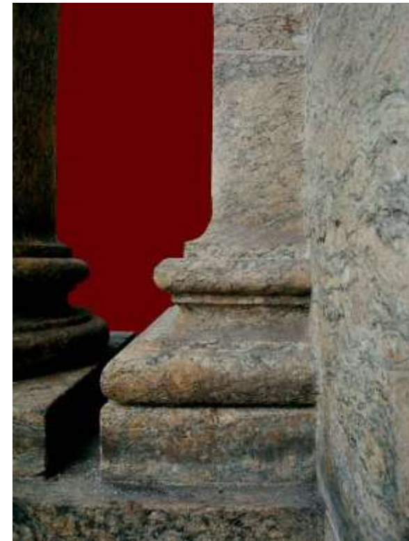
Figura 54: Base da coluna e pilar, Hospício de Pedro II. Fonte: Fotos de Marisa Hoirisch, 2012.
