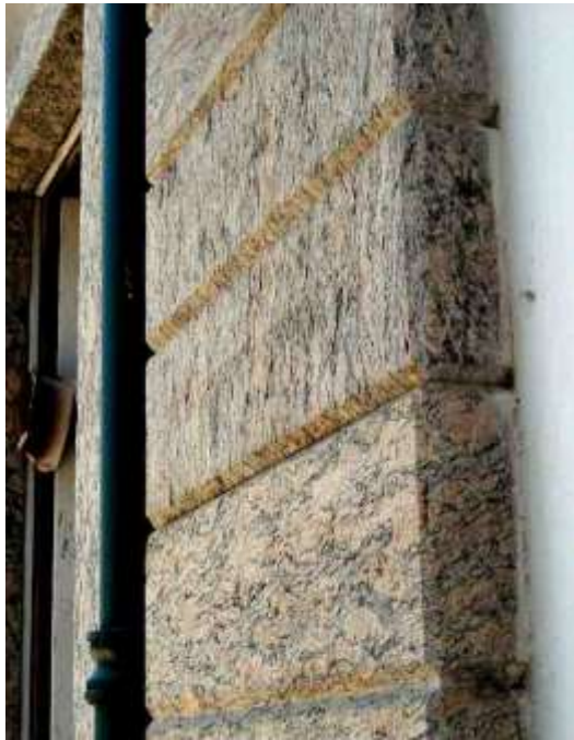
Figura 59: Pilastra, fachada junto à piscina, Hospício de Pedro II.
