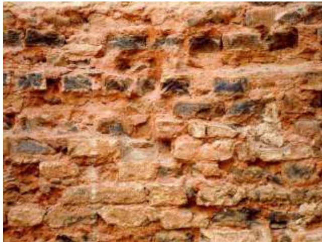
Figura 88: Parede de tijolos, SBBA, final do século XVIII.
