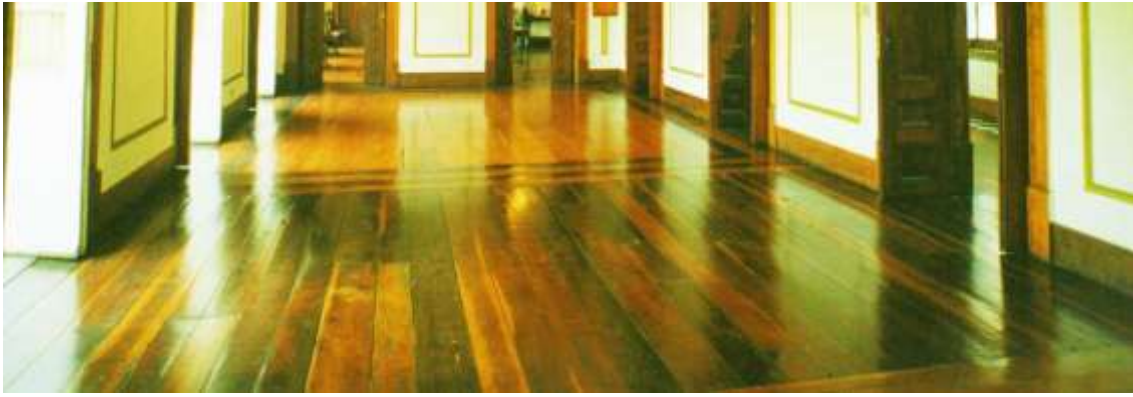
Figura 151: Piso com tabeira, Sala do Quarteto, Hospício de Pedro II.
