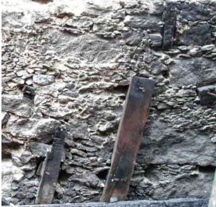
Figura 44: Alvenaria. Hospício de Pedro II. Fonte: Foto de Marisa Hoirisch, 2012.
