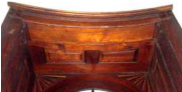
Figura 238: Ornamentação junto à esquadria, Solar da Marquesa de Santos. Fonte: Foto de Marisa Hoirisch, 2012.
