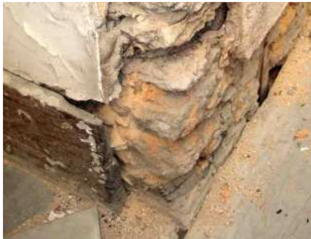
Figura 140: Local da fixação do rodapé, Hospício de Pedro II. Fonte: Foto de Marisa Hoirisch, 2012.
