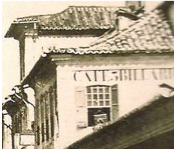
Figura 388: Acabamento em sianinha nos beirais.
