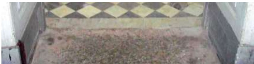
Figura 177: Soleira, Santa Casa de Misericórdia.
