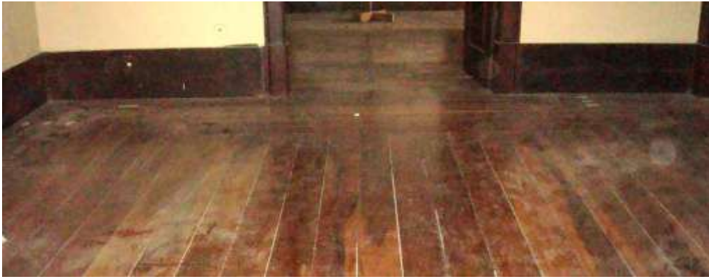
Figura 149: Piso em tábuas corridas e detalhe de tabeira. Marquesa de Santos.
