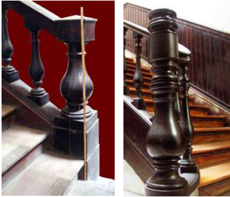
Figura 351: Pilar de corrimão, Hospício de Pedro II (esq.) e Santa Casa (dir.). Fonte: Foto de Marisa Hoirisch, 2012.
