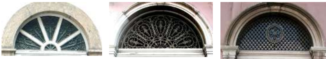
Figura 281: Grade e bandeira, Santa Casa (esq.), Palácio do Itamaraty (centro e direita).
