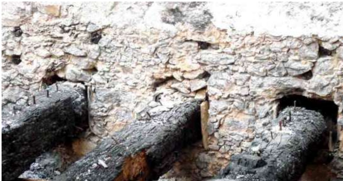
Figura 45: Barrotes em alvenaria de pedra. Hospício de Pedro II. Fonte: Foto de Marisa Hoirisch, 2012.
