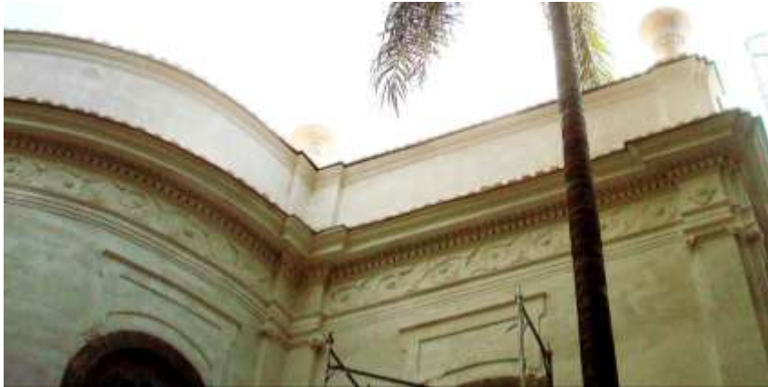
Figura 374: Platibanda, Solar da Marquesa de Santos.
