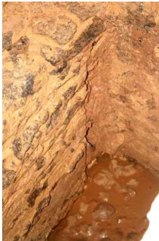
Figura 12: Baldrame de pedra argamassada, Museu Real, c. 1818.
