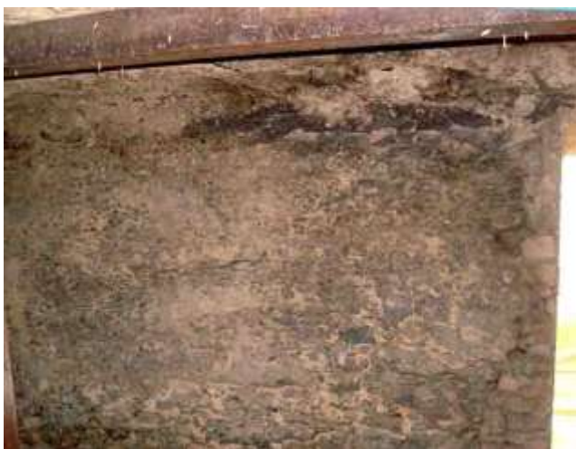
Figura 19: Muro de pedras argamassadas, Hospício de Pedro II, c. 1842.
