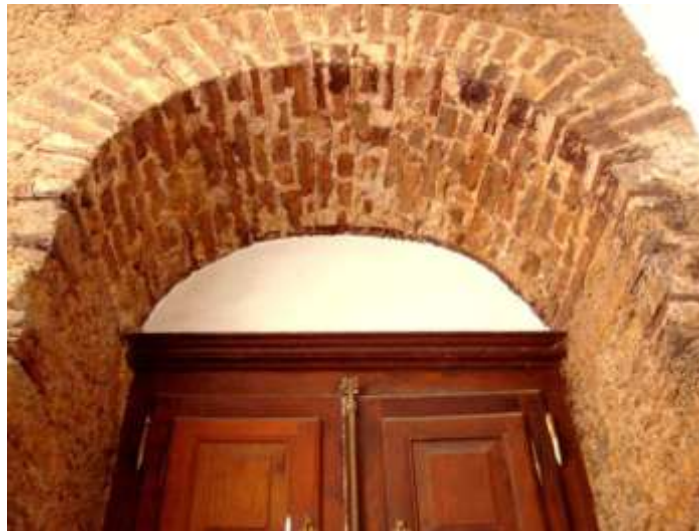
Figura 98: Paredes em alvenaria mista, Hospício de Pedro II.
