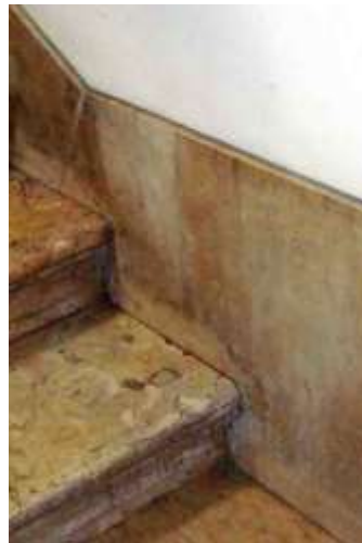
Figura 142: Rodapé, escada, Santa Casa. Fonte: Foto de Marisa Hoirisch, 2012.
