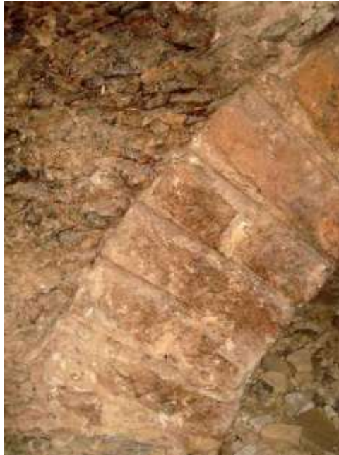
Figura 24: Juntas de assentamento côncavas, Hospício de Pedro II, c. 1842.
