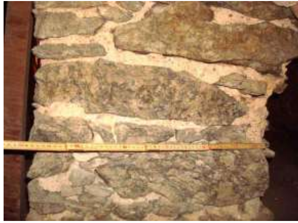
Figura 30: Pilar de pedra argamassada, det. Hospício. Fonte: Foto de Marisa Hoirisch, 2012.
