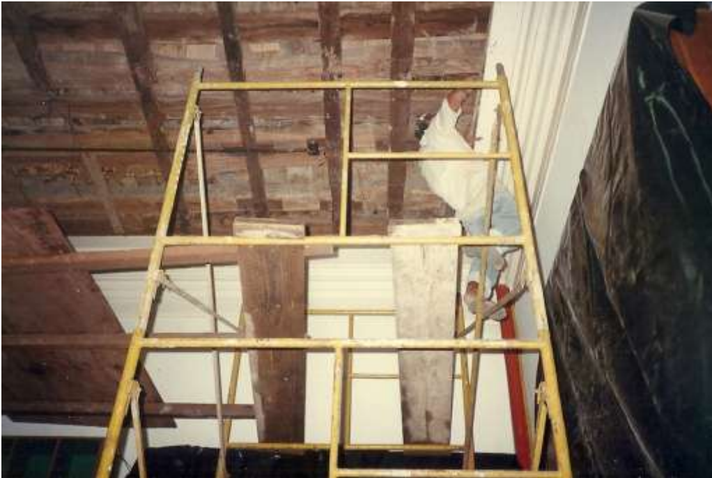
Figura 193: Estrutura de forro, Hospício de Pedro II.
