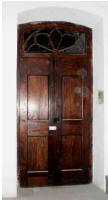
Figura 271: Esquadria interna, Solar da Marquesa de Santos. Fonte: Foto de Rosina Trevisan, 2012.
