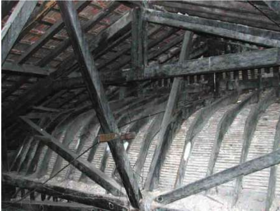
Figura 399: Estrutura de madeira, telhado, Hospício de Pedro II.
