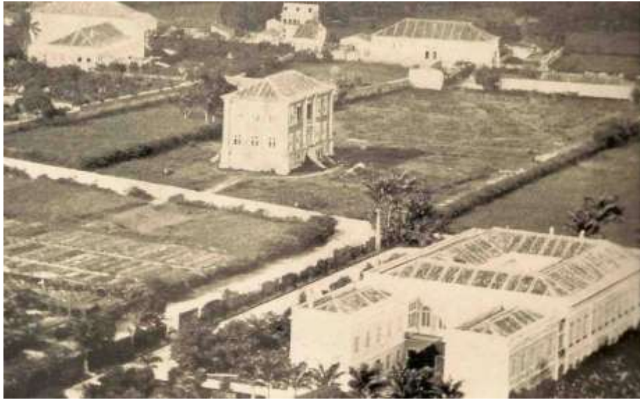
Figura 392: Telhas argamassadas em Laranjeiras, c. 1865. Foto R. H. Klumb, det. Fonte: Ermakoff, 2006, p. 148.
