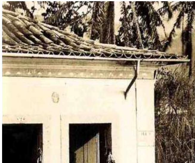
Figura 382: Calha com duto embutido, Catumbi, c. 1865. Foto de Stahl, det.
