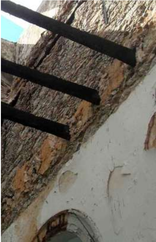
Figura 47: Alvenaria de pedra, Hospício. Fonte: Foto de Marisa Hoirisch, 2012.
