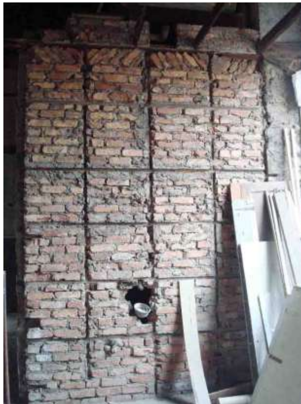
Figura 103: Paredes em tijolos, HESFA, 1879.
