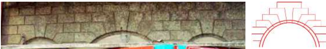
Figura 77: Fachada em cantaria, Rua da Quitanda, nº 61, 1872, e esquema do arco central. Fonte: Foto de Marisa Hoirisch, 2012.
