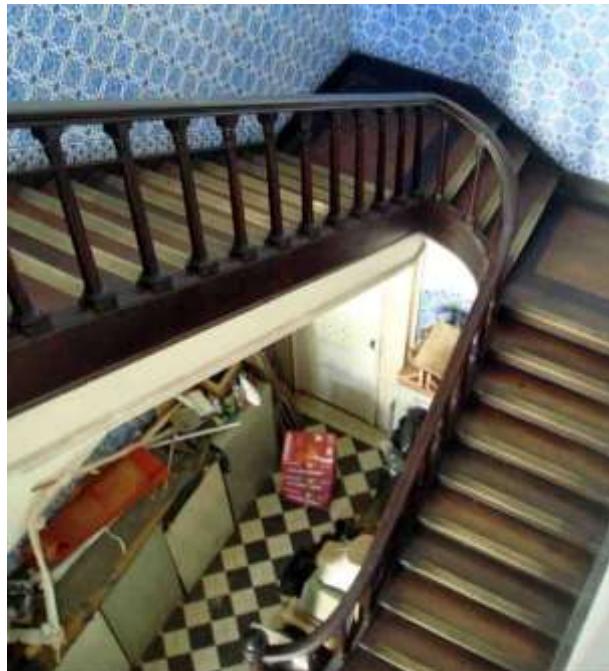
Figura 329: Escada em “U”. Hospício de Pedro II. Fonte: Foto de Marisa Hoirisch, 2012.
