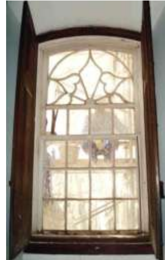
Figura 266: Guilhotina com bandeira, vista externa e interna, Marquesa de Santos. Fonte: Fotos de Rosina Trevisan e Marisa Hoirisch, 2012.
