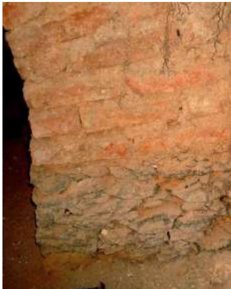
Figura 26: Arco de tijolos sobre mureta de pedra, Hospício, c. 1875.
