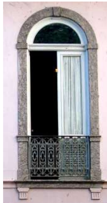
Figura 217: Janela com guarda-corpo entalado, Casa de Rui Barbosa. Fonte: Foto de Marisa Hoirisch, 2011.
