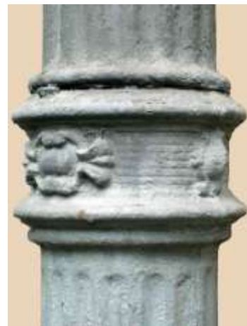
Figura 386: Conexão do tubo, Hospício de Pedro II
