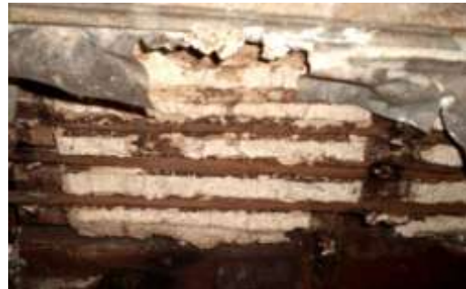
Figura 203: Estuque, ripado visto de frente.
