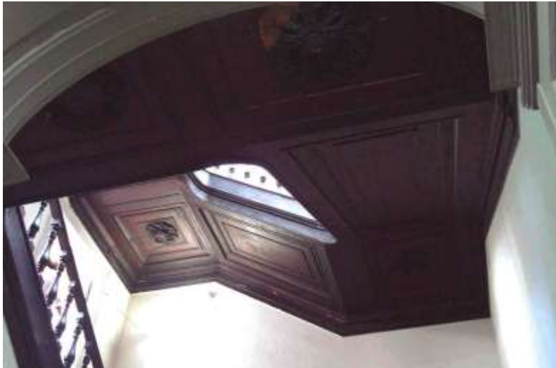
Figura 194: Forro da escada, Santa Casa. Fonte: Foto de Marisa Hoirisch, 2011.
