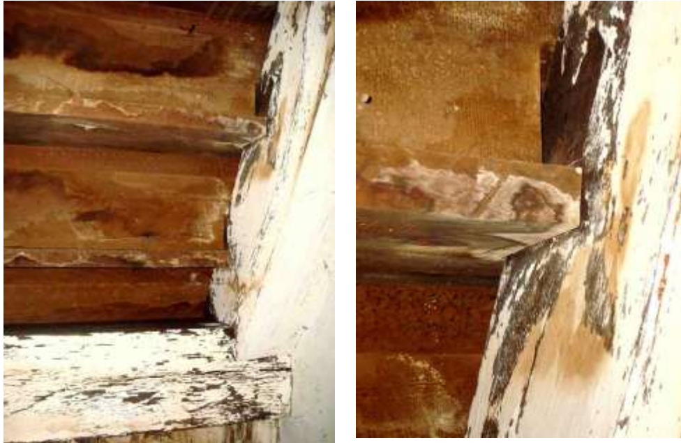
Figura 362: Escadas, entalhe nos degraus, det. à direita, Hospício de Pedro II. Fonte: Foto de Marisa Hoirisch, 2012.
