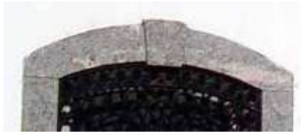
Figura 66: Verga, Solar da Marquesa de Santos.
