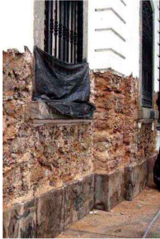
Figura 48: Alvenaria de pedra, Marquesa. Fonte: Foto de Marisa Hoirisch, 2012.
