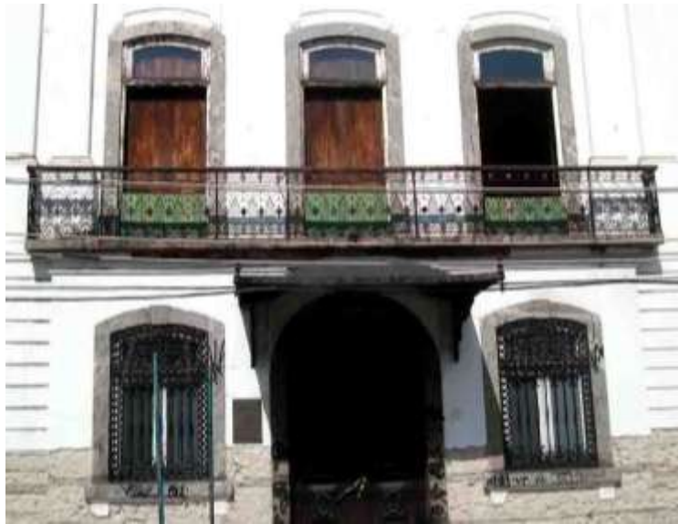
Figura 49: Elementos em cantaria, Marquesa de Santos.
