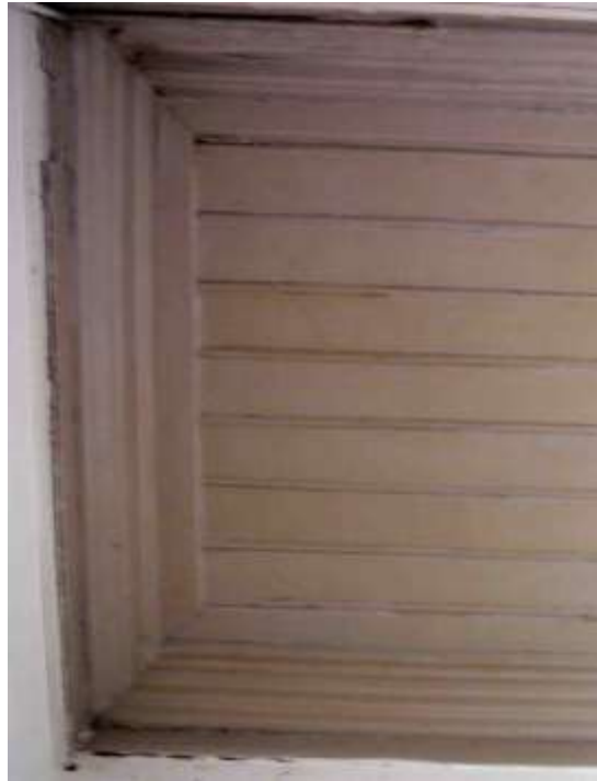
Figura 190: Forro de tábuas com mata junta, Hospício de Pedro II.
