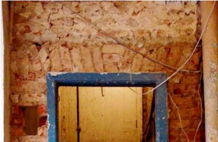
Figura 92: Verga em tijolos, SBBA.
