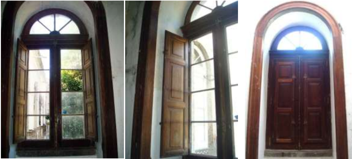
Figura 240: Fechamento com postigo, vistas internas, Hospício de Pedro II. Fonte: Fotos de Marisa Hoirisch, 2011.
