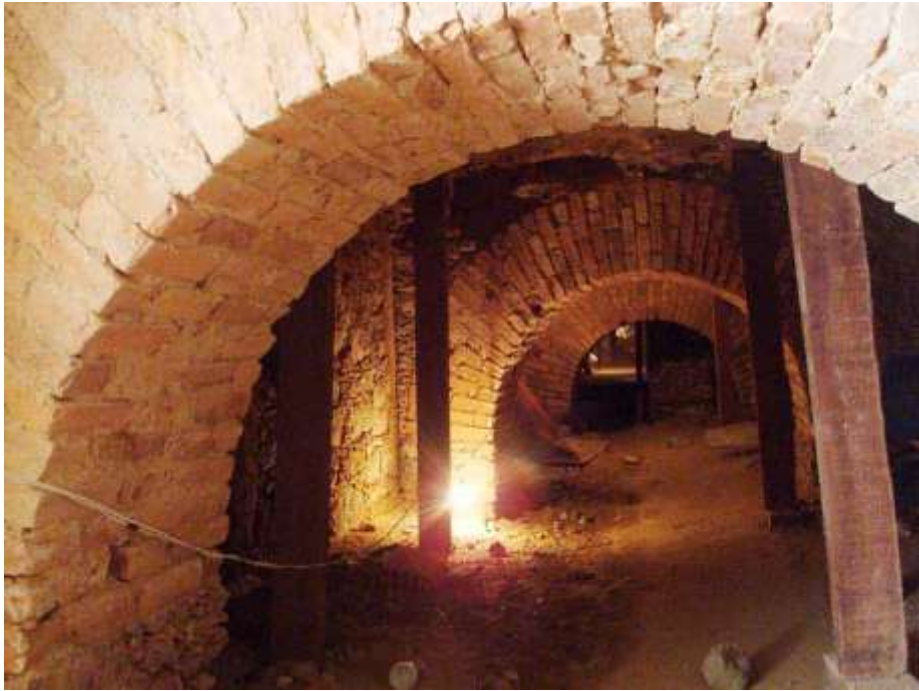
Figura 25: Arcos após a retirada do entulho, Hospício de Pedro II, c. 1875.
