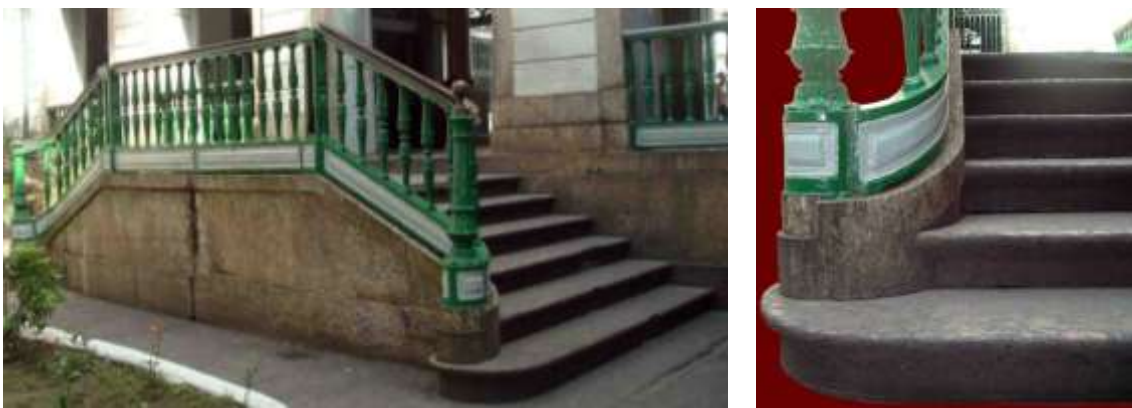
Figura 312: Escada paralela à fachada (esq.) e det. (dir.), Santa Casa de Misericórdia. Fonte: Fotos de Marisa Hoirisch, 2011.
