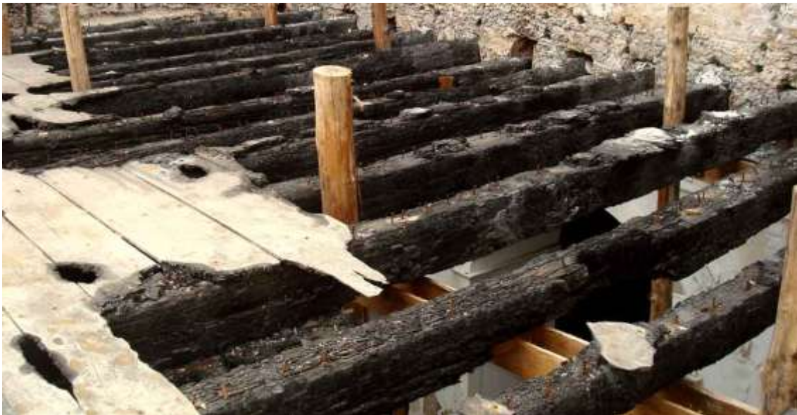
Figura 159: Barroteamento perpendicular às tábuas.
