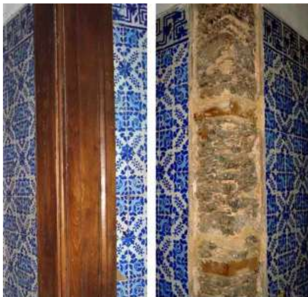
Figura 273: Alizar (esq.) e quina, mostrando local de fixação, Hospício de Pedro II.
