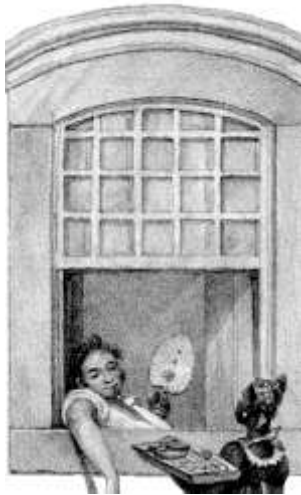
Figura 265: Guilhotina em verga de arco abatido, det. Fonte: Debret, 1835, II, pl. 12.
