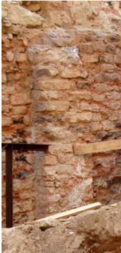
Figura 93: Pilar de tijolos, SBBA. Fonte: Foto de Marisa Hoirisch, 2012.
