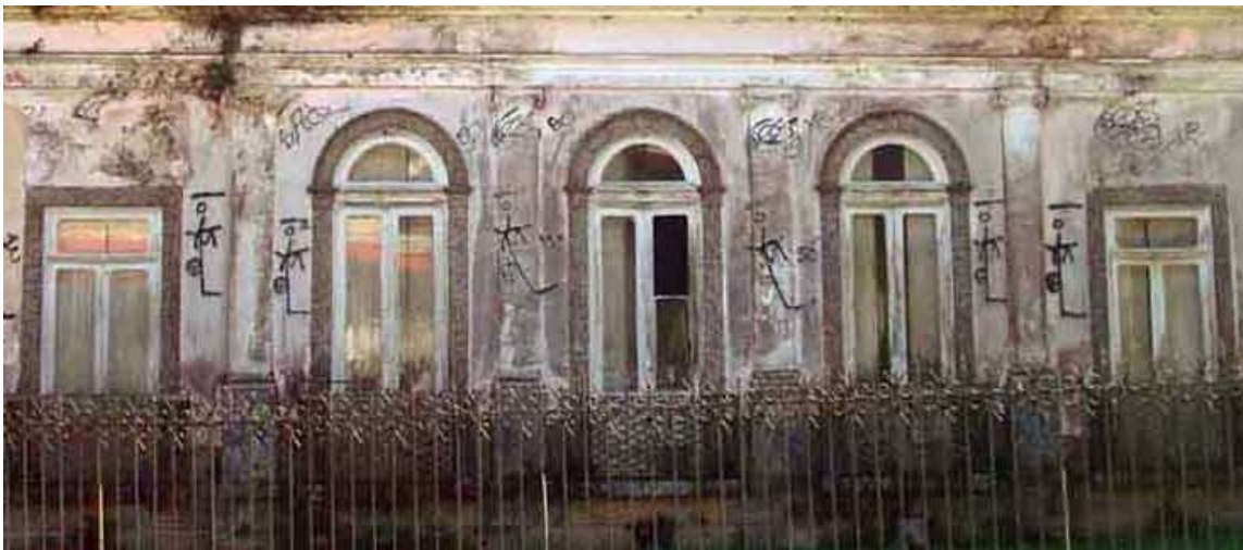
Figura 50: Elementos em cantaria, Palacete do Conde de Itamaraty.
