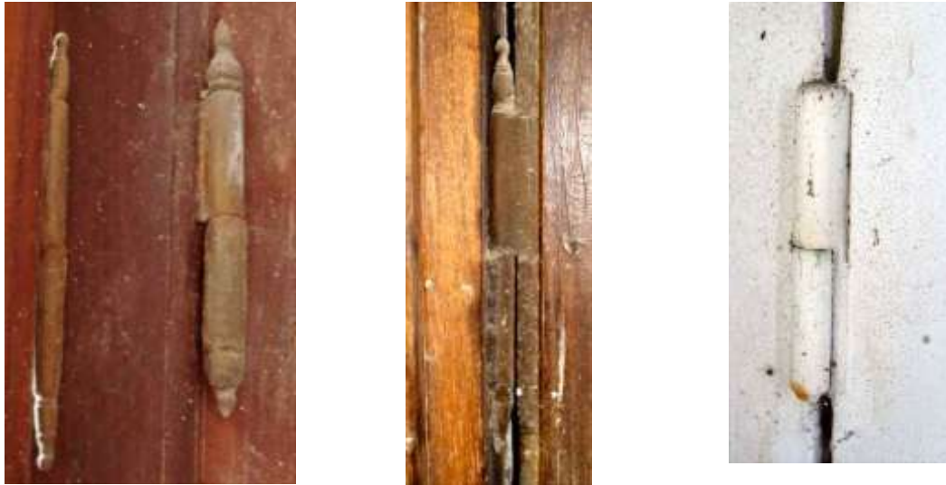
Figura 303: Dobradiça, Hospício de Pedro II (esq.), Marquesa (cent.) e Conde de Itamaraty (dir.). Fonte: Fotos de Marisa Hoirisch, 2011 e 2012.
