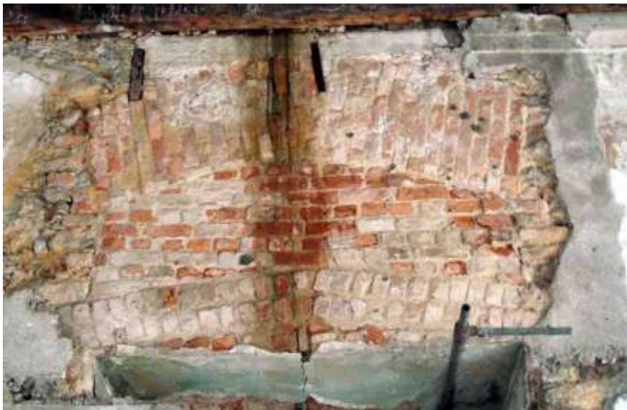
Figura 91: Dois arcos em tijolo, HESFA.
