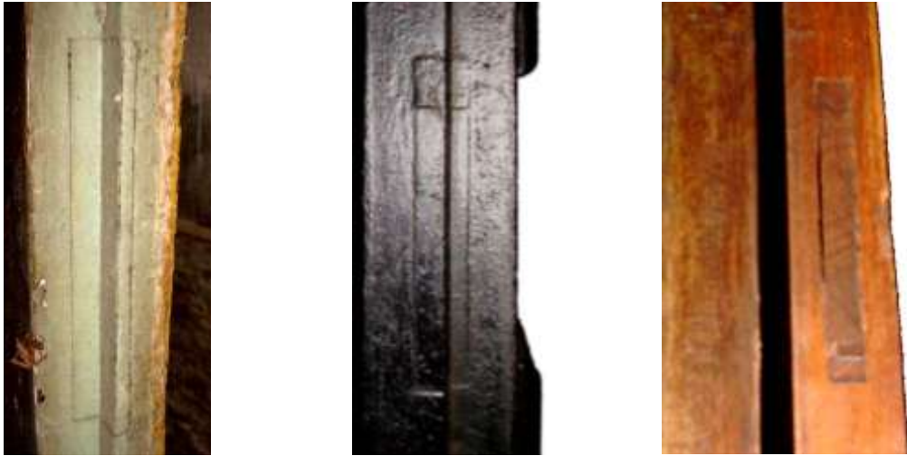
Figura 230: Taleira, Hospício de Pedro II (esq.), Santa Casa (cent.) e Marquês de Santos (dir.). Fonte: Fotos de Marisa Hoirisch, 2011.
