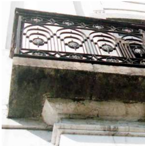
Figura 81: Cachorro sob a bacia, Solar da Marquesa de Santos, det. Fonte: Foto de Marisa Hoirisch, 2012.
