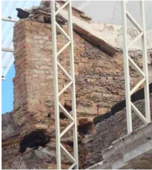
Figura 95: Estrutura de alvenaria de tijolos, Hospício de Pedro II. Fonte: Foto de Marisa Hoirisch, 2012.
