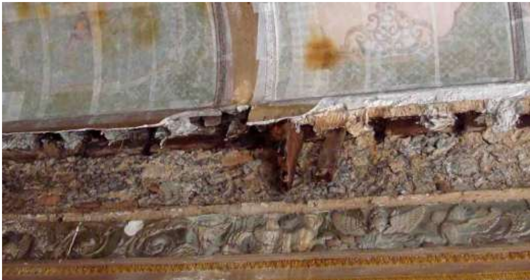
Figura 206: Forro de estuque, Solar da Marquesa de Santos. Fonte: Foto de Marisa Hoirisch, 2012.
