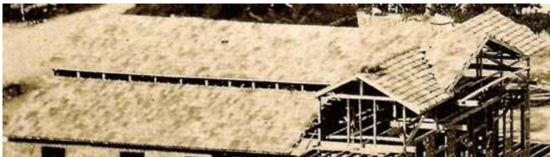
Figura 389: Obra com adoção de telha francesa, c. 1865, Foto de Leuzinger, det.
