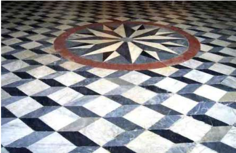
Figura 172: Piso em mármore, vestibulo, Hospício de Pedro II. Fonte: Foto de Marisa Hoirisch, 2012.
