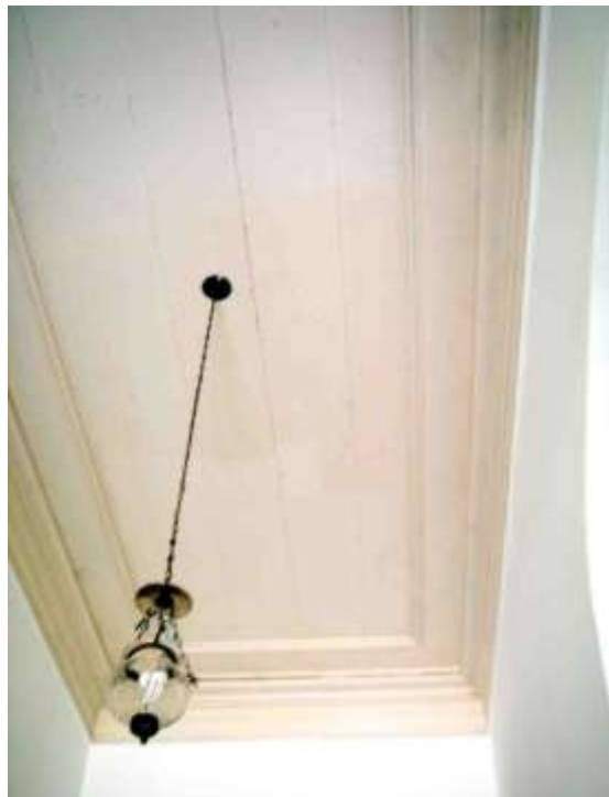
Figura 187: Forro de tábuas, Hospício de Pedro II.
