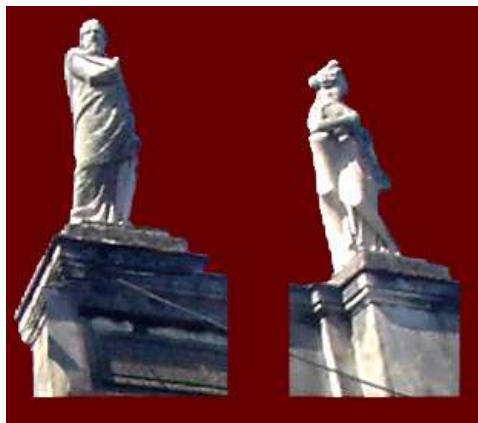
Figura 379: Estátuas, platibanda, Hospício de Pedro II (esq.) e Palácio do Itamaraty (dir.). Fonte: Fotos de Marisa Hoirisch, 2011.
