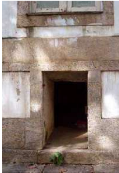
Figura 18: Acesso ao porão construído nos anos 1840, Hospício de Pedro II.
