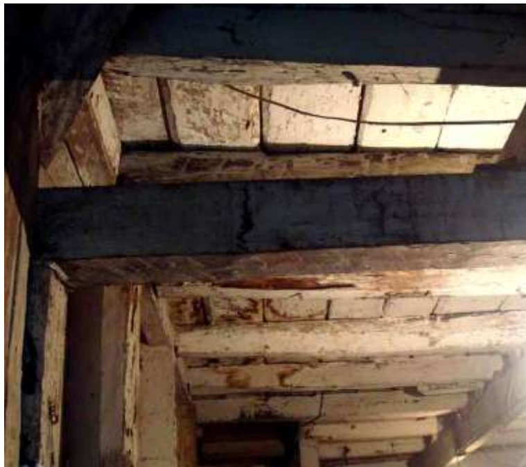
Figura 166: Estrutura de piso, Capela, Santa Casa de Misericórdia. Fonte: Foto de Marisa Hoirisch, 2011.
