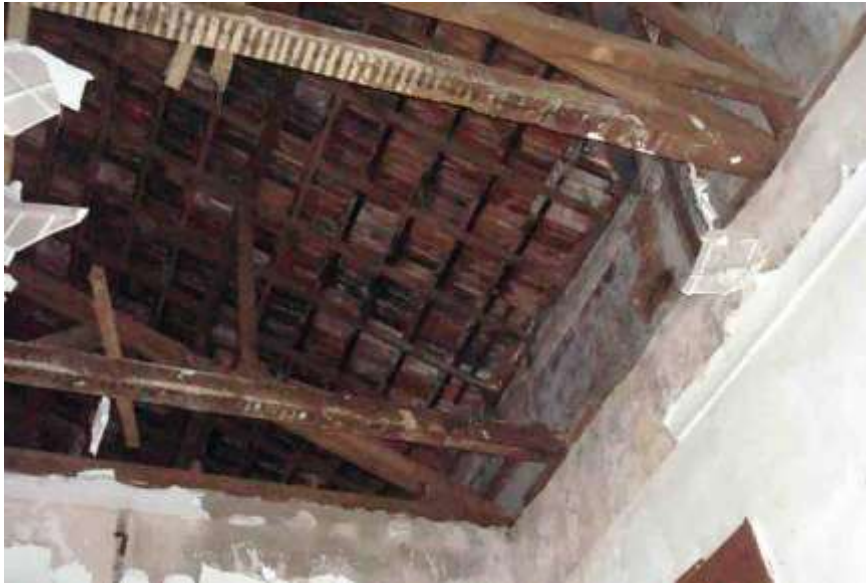
Figura 195: Estrutura de forro, Palacete do Conde de Itamaraty. Fonte: Marisa Hoirisch, 2012.
