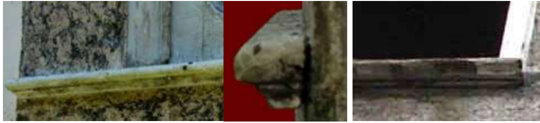
Figura 254: Pingadeira de peitoril (esq.) e em perfil, em detalhe (cent.), Palacete do Conde de Itamaraty e Marquesa de Santos (dir.).
