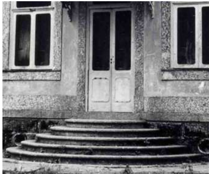
Figura 310: Escada externa, Palacete do Conde de Itamaraty.
