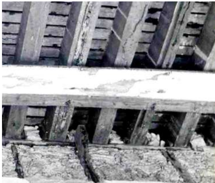
Figura 192: Barrotes de forro e piso, circulação, Hospício de Pedro II.
