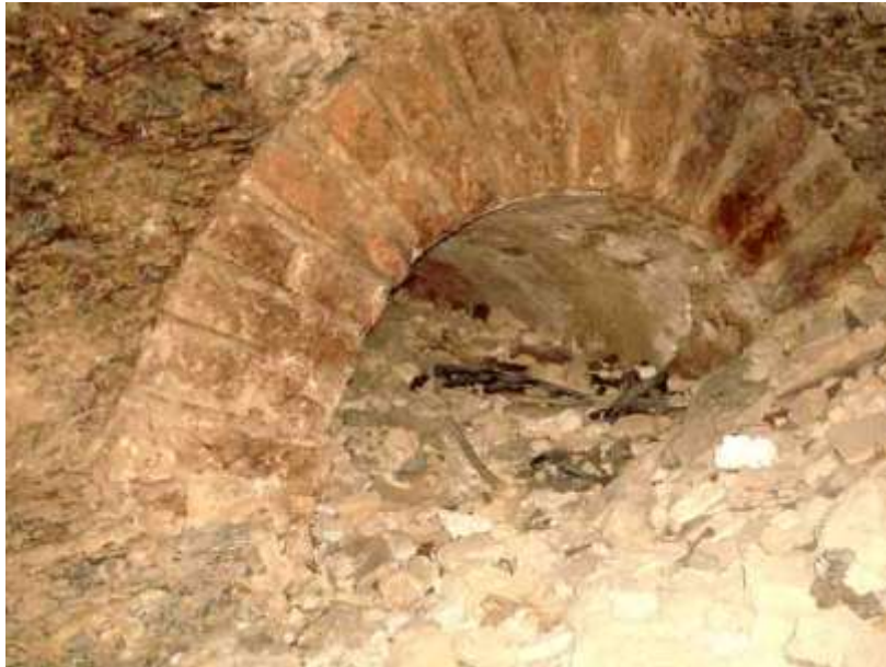
Figura 21: Arcos de descarga, alicerce do Hospício de Pedro II.
