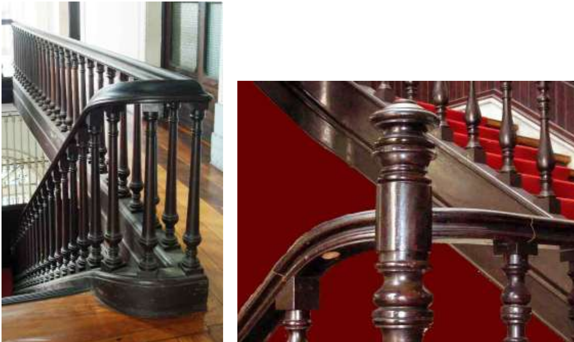
Figura 343: Balaústres, Santa Casa. Fonte: Foto de Marisa Hoirisch, 2011.
