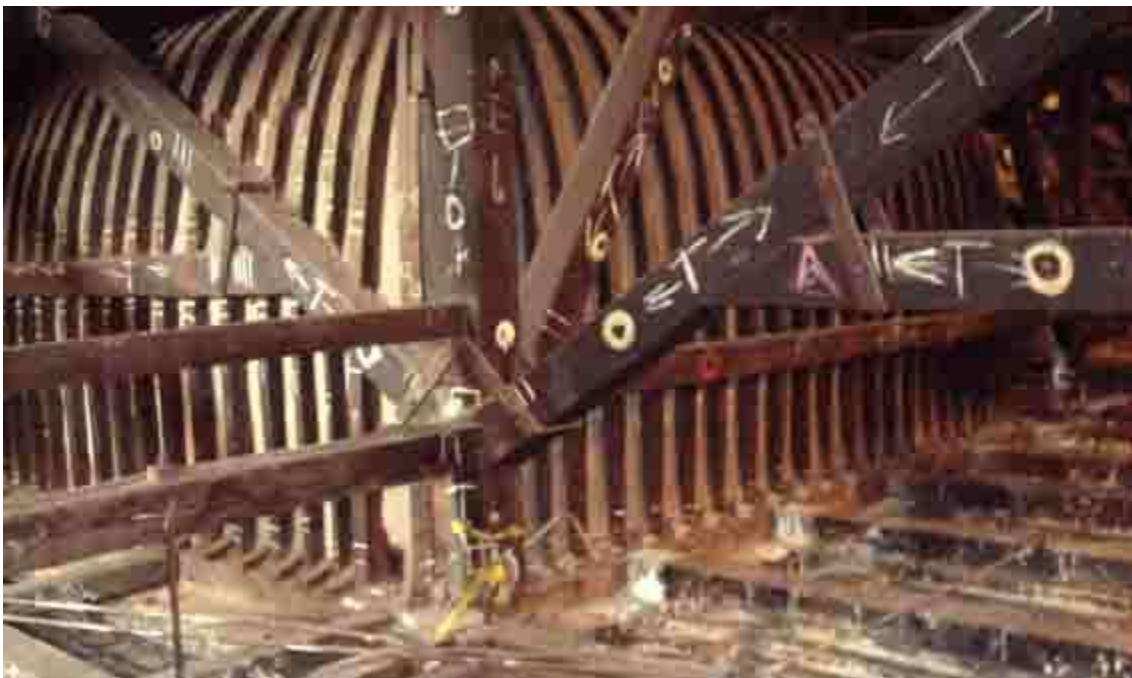
Figura 400: Tesoura com cambotas ao fundo, Solar da Marquesa de Santos.
