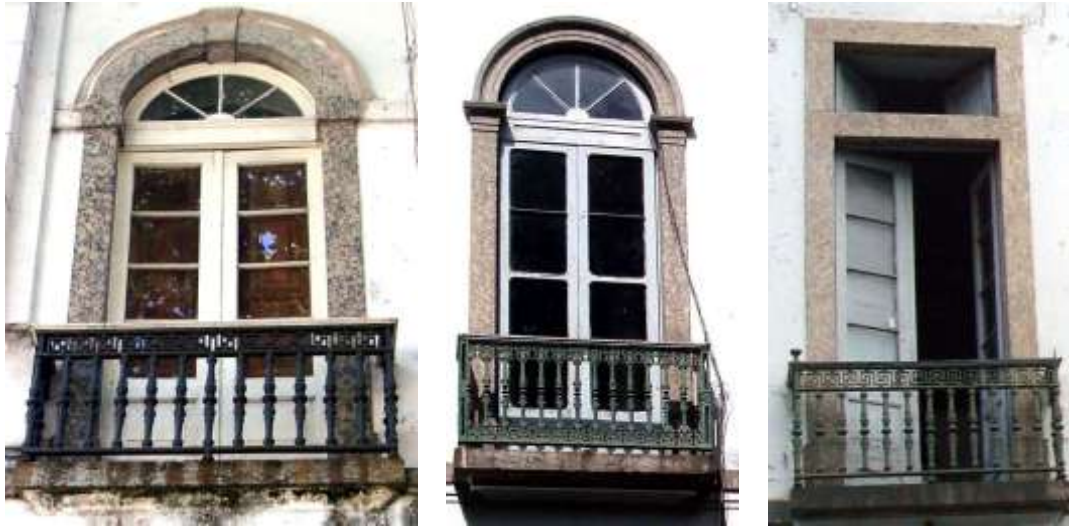
Figura 215: Janelas sacadas, Hospício de Pedro II (esq.) e Santa Casa (centro e dir.). Fonte: Fotos de Marisa Hoirisch, 2011.
