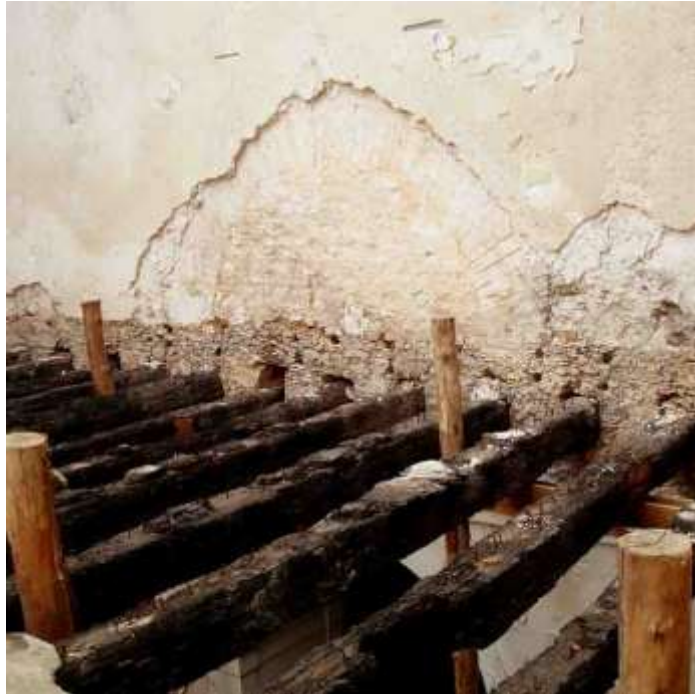
Figura 46: Arcos de descarga no segundo piso, Hospício de Pedro II.
