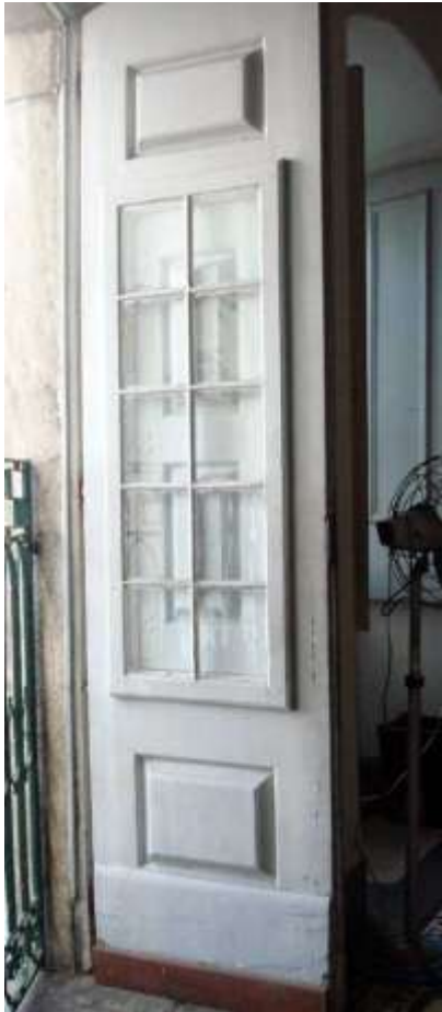
Figura 242: Caixilho e postigo, porta, Santa Casa. Fonte: Foto de Marisa Hoirisch, 2011.
