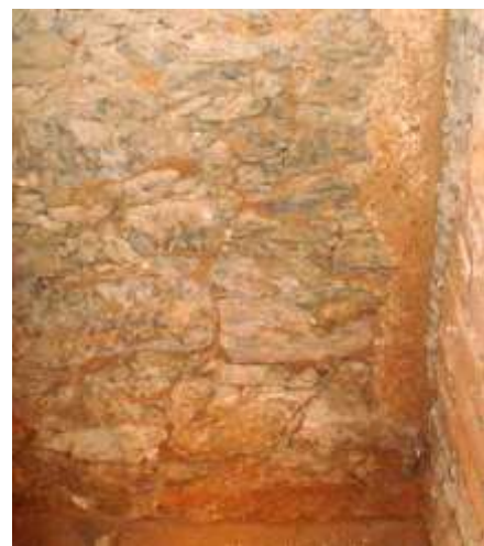
Figura 20: Muro de pedras argamassadas, Hospício, c. 1870.
