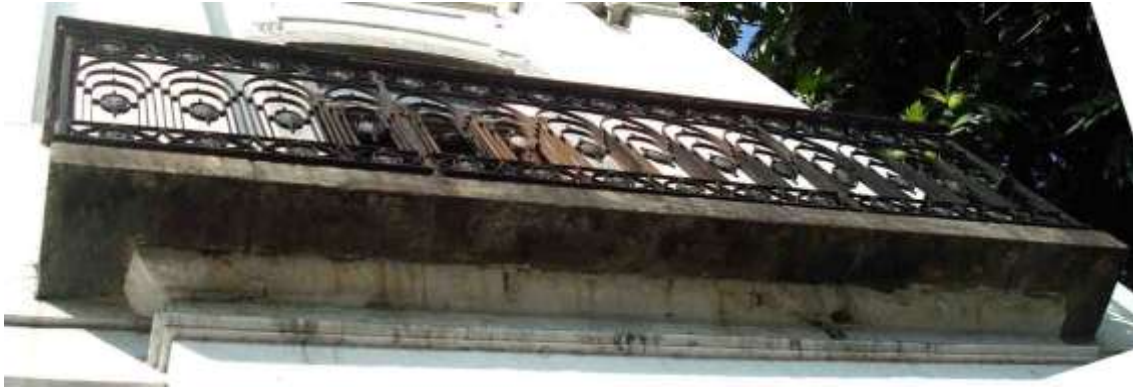
Figura 80: Cachorro sob a bacia, Solar da Marquesa de Santos. Fonte: Foto de Marisa Hoirisch, 2012.
