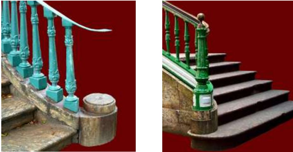
Figura 322: Guarda-corpo, Hospício de Pedro II (esq.) e Santa Casa (dir.). Fonte: Fotos de Marisa Hoirisch, 2012.
