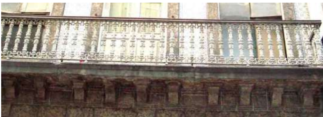
Figura 85: Sacada, Rua da Quitanda, nº 61.
