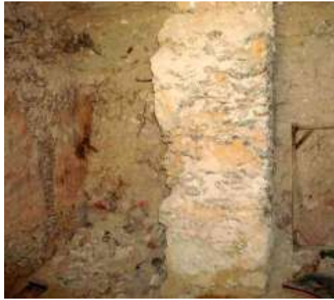
Figura 29: Pilar de pedra argamassada. Fonte: Foto de Marisa Hoirisch, 2012.
