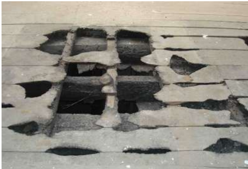
Figura 164: Estrutura de piso, Capela São Pedro de Alcântara, Hospício de Pedro II. Fonte: Foto de Marisa Hoirisch, 2012.
