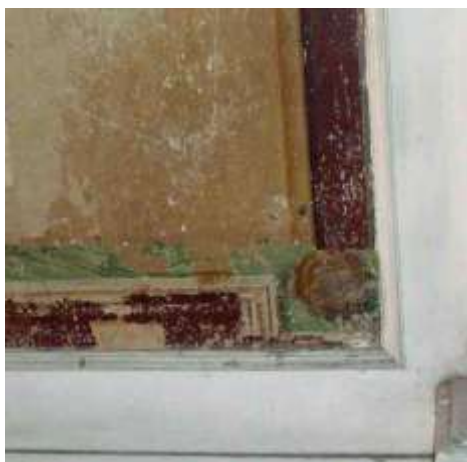
Figura 132: Pintura mural (janela de prospecção), Hospício de Pedro II. Fonte: Foto de Marisa Hoirisch, 2012.
