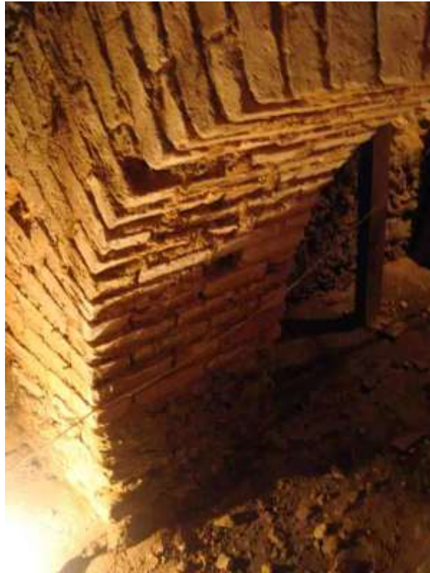
Figura 33: Arco em tijolos, aparelho flamenco, Hospício de Pedro II.
