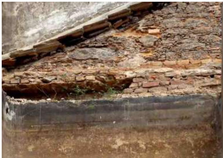
Figura 102: Paramento de alvenaria mista, forro da capela, Hospício de Pedro II. Fonte: Foto de Marisa Hoirisch, 2012.
