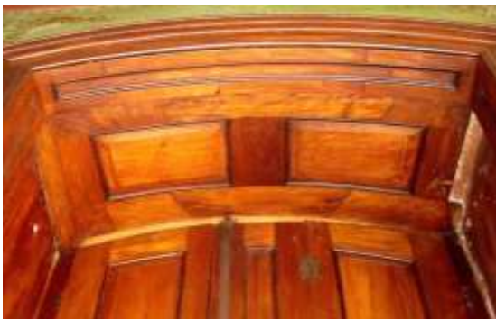
Figura 236: Ornamentação junto à esquadria, Solar da Marquesa de Santos. Fonte: Foto de Marisa Hoirisch, 2012.
