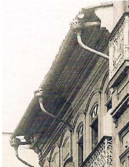
Figura 381: Calha e dutos de águas pluviais, Centro, RJ, c. 1890, Marc Ferrez, det.
