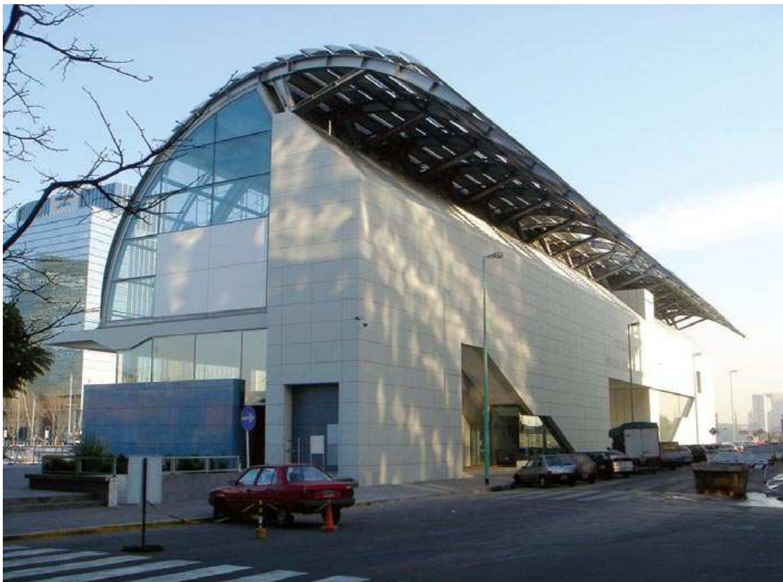
Figura 140 – Museu Fortabat – Fachada e cobertura em arco Cobertura em funcionamento permitindo a incidência direta da luz natural nas salas de exposição do segundo pavimento e mezanino
