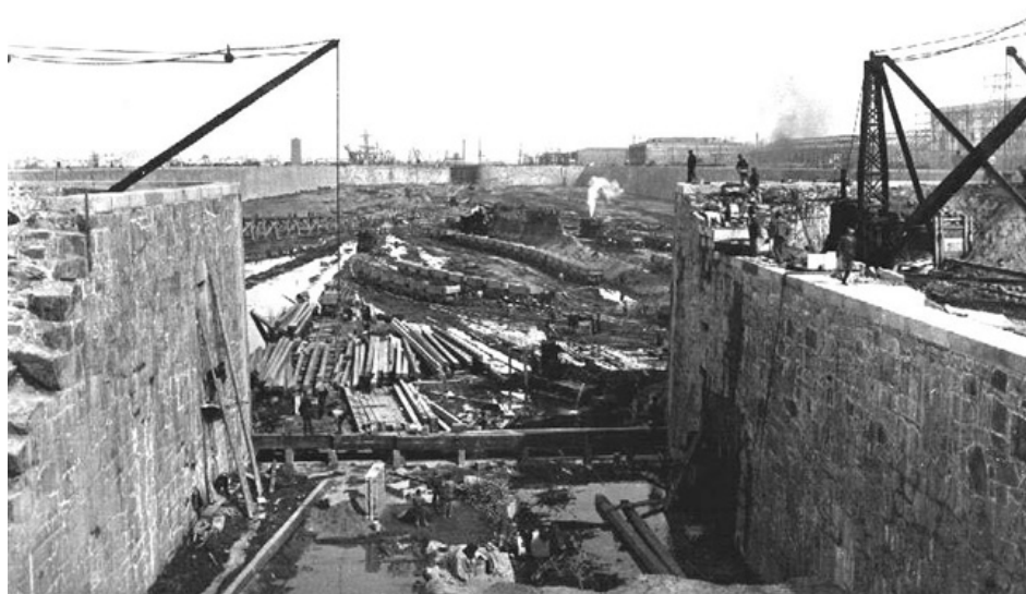
Figura 93– Puerto Madero – Obras iniciais do porto em 1884
