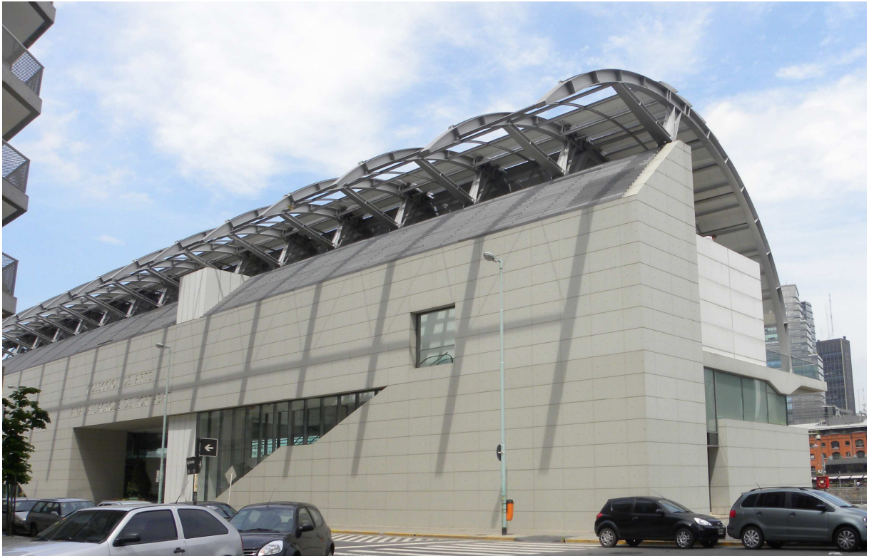
Figura 105 – Fachada Leste – Vista Leste/Norte – Sol às 13h.30min. Foto: Alvaro Costa, nov. 2012.
