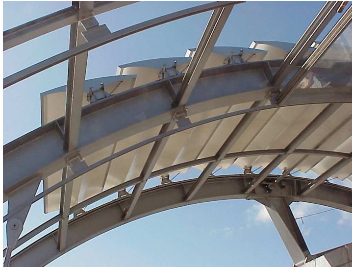
Figura 131 – Detalhe da execução da cobertura – Colocação dos painéis móveis (venezianas) Fonte: Sílvia Godoy Colombo.
