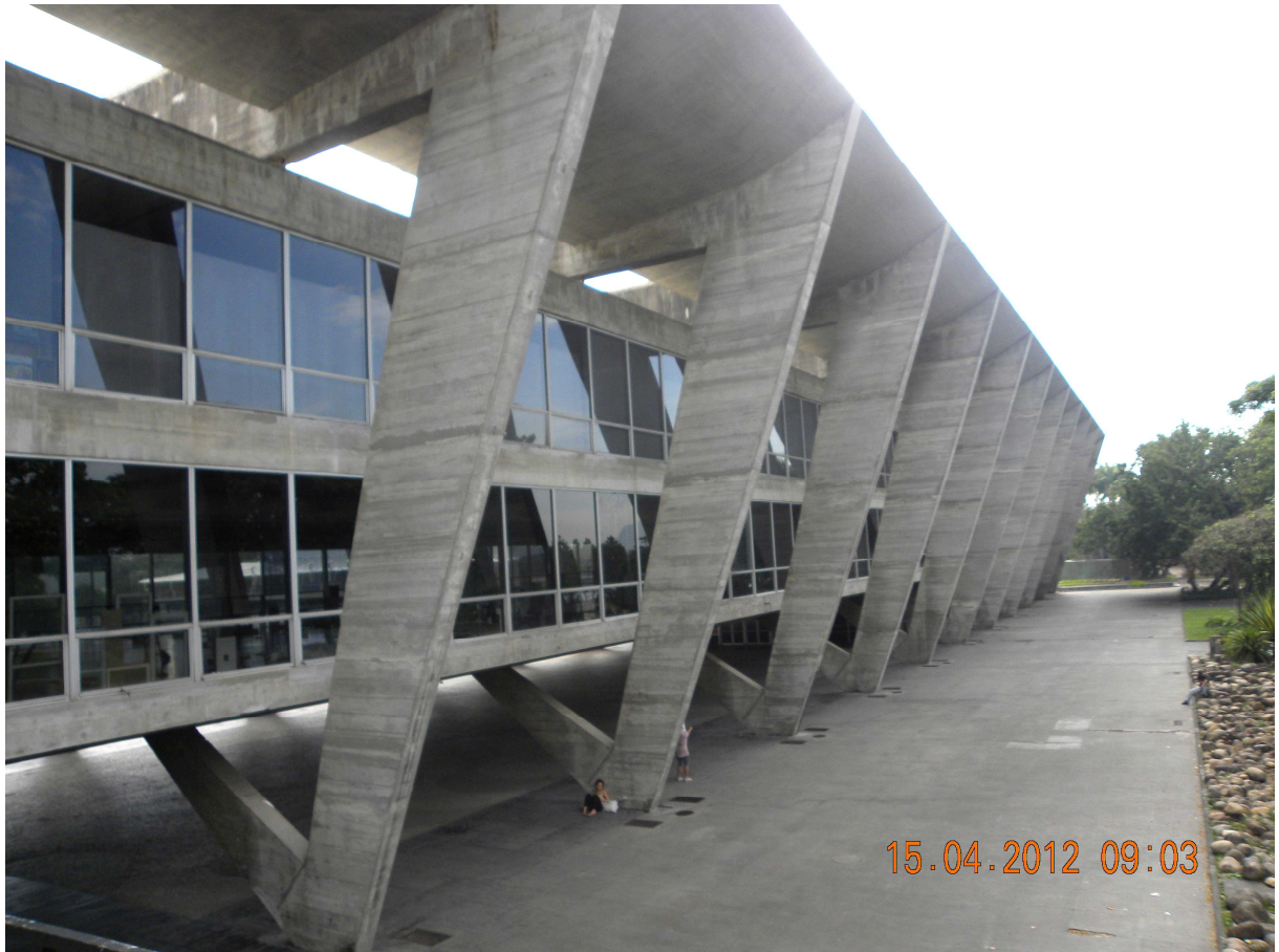
Figura 68 – MAM-Rio – Bloco de exposições e sua estrutura Foto: Alvaro Costa, abr. 2012.
