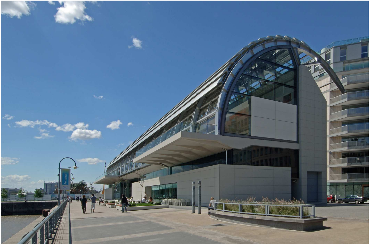
Figura 103 – Vista Oeste/Sul – Foto de out., 2008 - Sol às 12h.30min. Cobertura parcialmente aberta Fonte: Coleção de Arte Amália Lacroze Fortabat.
