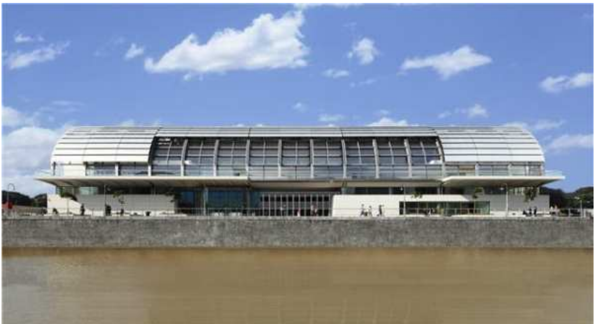
Figura 130 – Museu Fortabat – Cobertura em funcionamento Fonte: cortesia de Rafael Viñoly Architects. Crédito: Roman Viñoly (Copyright).
