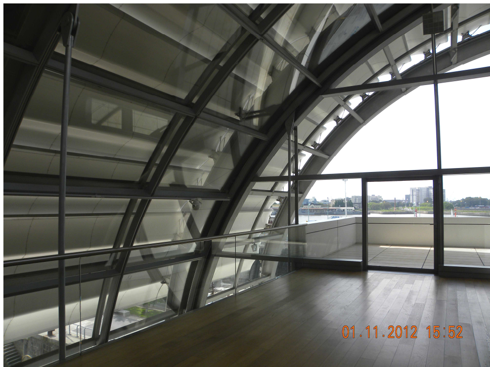
Figura 115 – Mezanino do segundo pavimento – Acesso ao terraço Foto: Alvaro Costa, nov. 2012.
