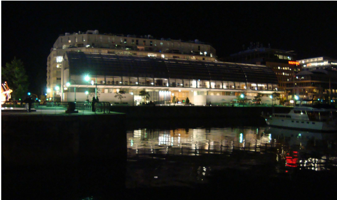
Figura 136 – Museu Fortabat à noite, com a cobertura fechada Foto: Alvaro Costa, nov. 2012.
