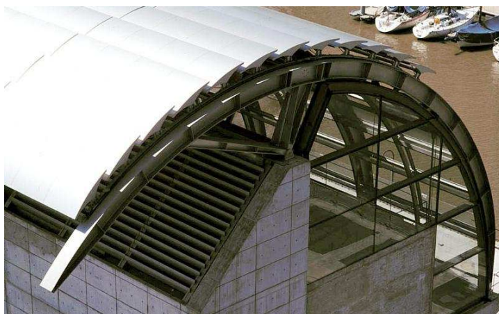
Figura 133 – Cobertura apoiada na parede estrutural Fonte: Sílvia Godoy Colombo.
