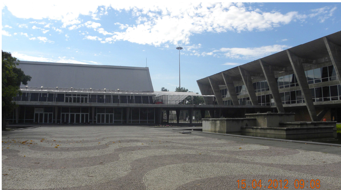
Figura 65 – MAM-Rio – Teatro e bloco de Exposições Projeto modificado e abandono na área externa Foto: Alvaro Costa, abr. 2012.
