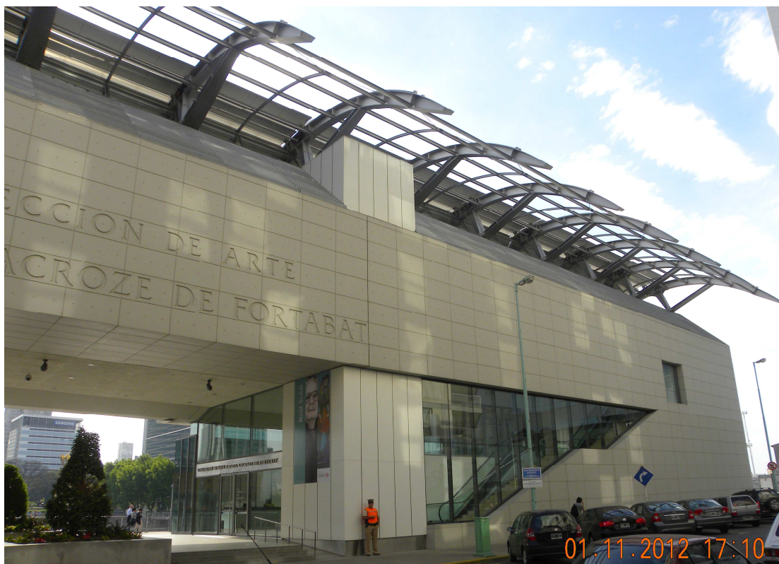
Figura 106 – Área de acesso – Fachada Leste Foto: Alvaro Costa, 2012.
