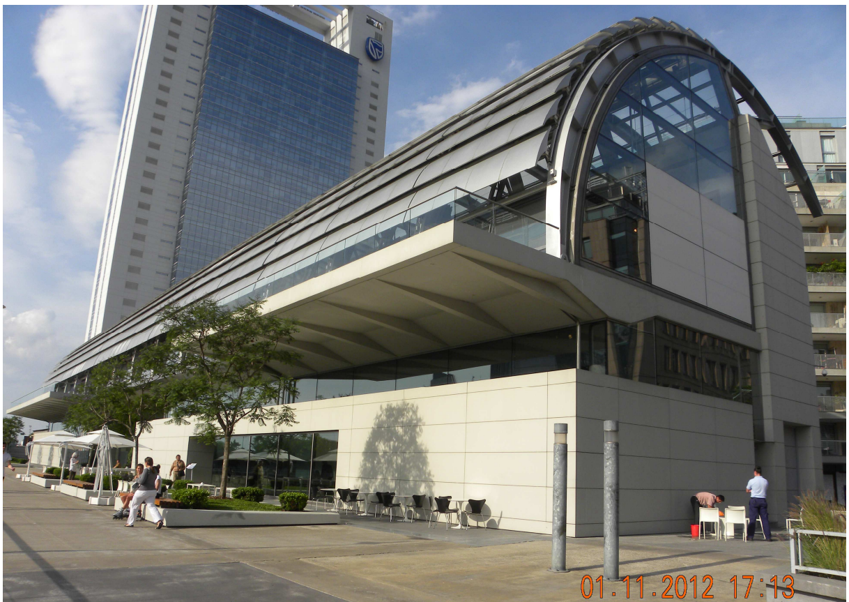
Figura 104 – Vista Oeste/Sul – Sol às 17h.10min. Cobertura fechada Foto: Alvaro Costa, nov. 2012.
