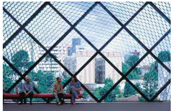
Figura 11 – Museu Oscar Niemeyer – Vista interna - Detalhe da caixilharia
