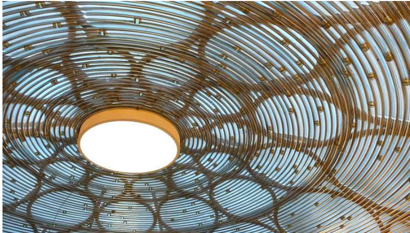
Figura 4 – Claraboia utilizando tubos de vidro Pyrex – Área da recepção Sede da Johnson Wax – Frank Lloyd Wright
