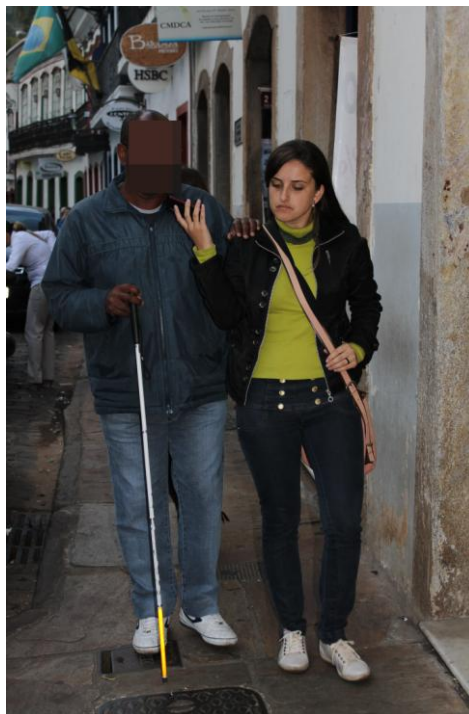
Figura 35 - Percurso J. C. – Detalhe para a tampa com uma abertura com a largura maior que a bengala do pesquisado.
