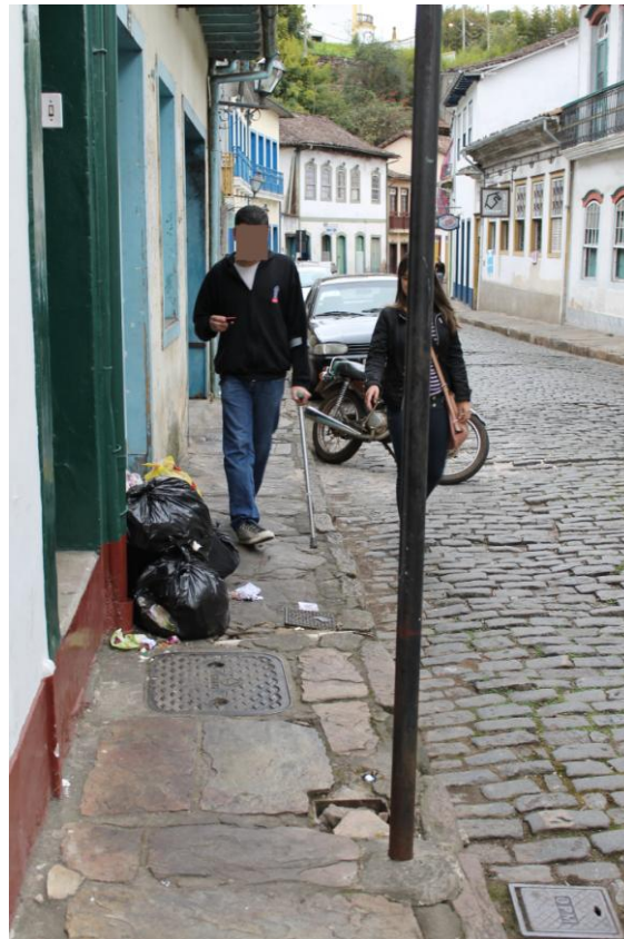
Figura 65 - Percurso F. A. – Lixos, buracos, placas, desníveis, tampas e calçada estreita na Rua Getúlio Vargas.
