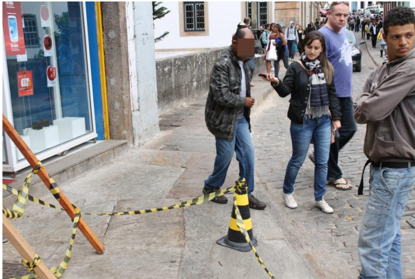
Figura 49 - Percurso J. B. – Detalhe para a obra na calçada da Rua São José
