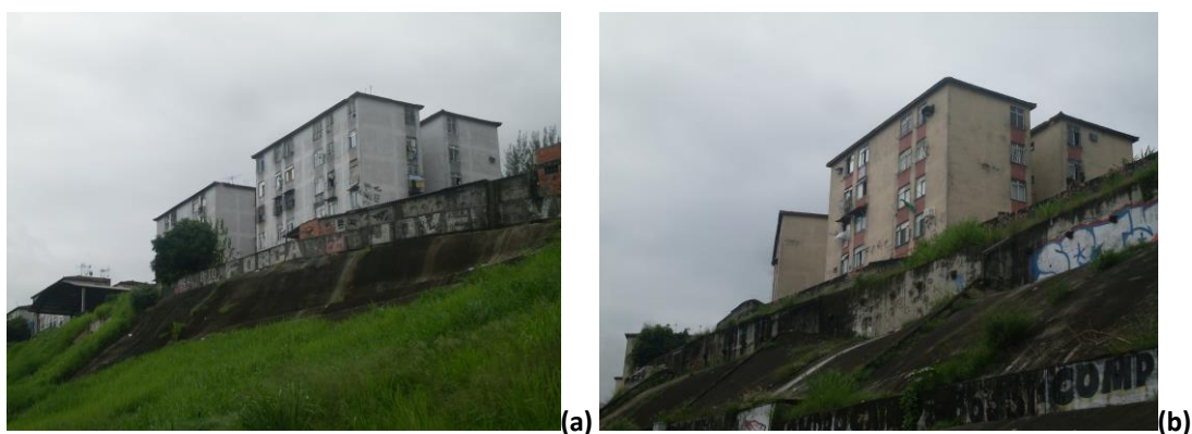
Figuras 62 (a-b). Blocos de apartamentos do Conjunto da Cidade Alta voltados para Avenida Brasil.
