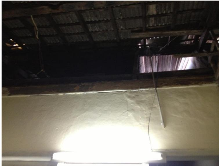
Imagem 38 - Telhado de amianto cobrindo o pátio interno. Fonte: Paula Peret. Data: 01/2013.
