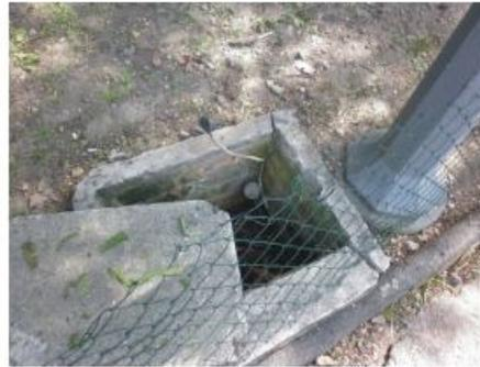
Fig. 64 – Caixa de passagem com fiação exposta. Foto C.Brack, 11jul2012
