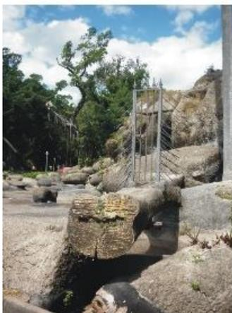
Fig. 45 – “Portão” preso à rocalha, sem apoio. Foto C.Brack, 24ago2012
