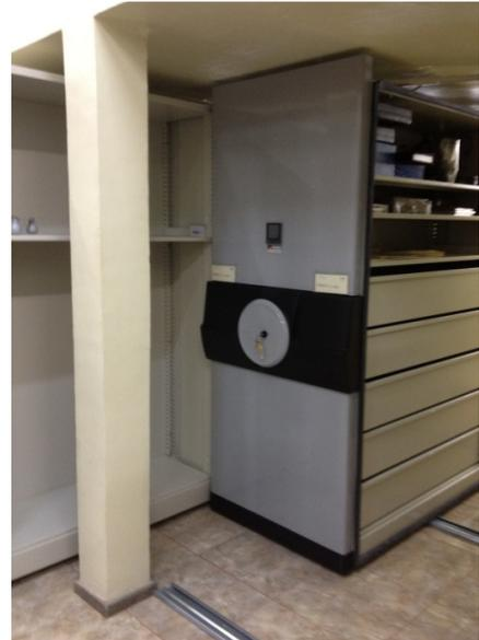
Figura 38 – Armários deslizantes na quase totalidade do espaço inferior ao jirau e também em parte deste.
