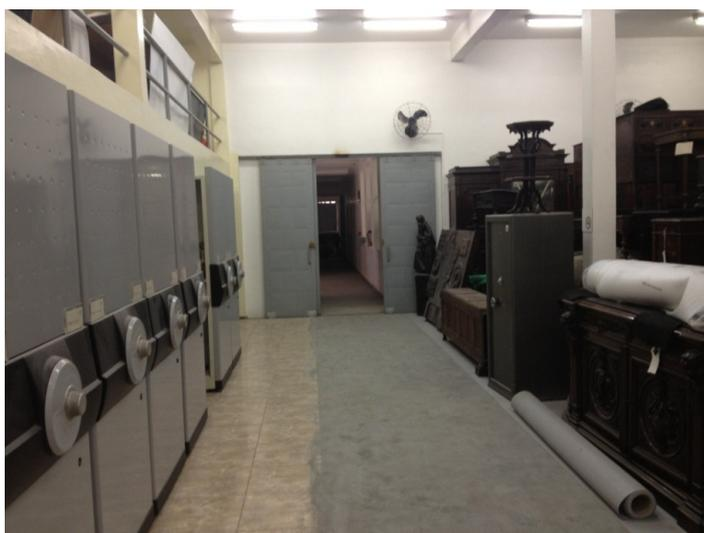
Figura 37: Corredor interno (eixo de circulação). Instalação do piso de Linóleo na Reserva Técnica. À esquerda piso cerâmico, no centro argamassa niveladora, à direita piso de Linóleo já instalado com o mobiliário em cima;
