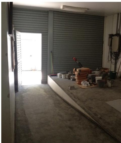
Figura 27 – Acessos (interno) à Reserva Técnica. O fechamento se dá através de portas de enrolar. Alarme de incêndio estrategicamente posicionado
