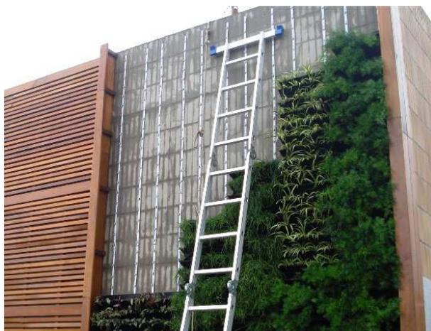
Figura 56 – Parede verde – Sistema do tipo separado
