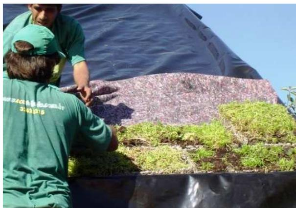
Figura 49 - Módulos pré-fabricados
