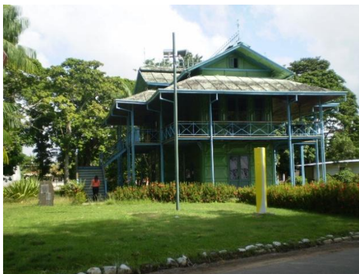
Figura 03: Exemplar de um Chalé de Ferro para uso residencial de origem Belga, com construção anterior à 1893. Está localizado atualmente no campus da Universidade Federal do Pará, em Belém.
