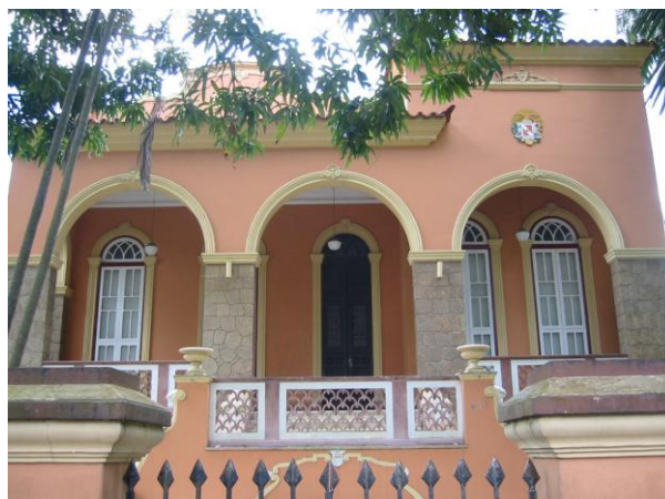
Figura 90: Fachada frontal da Residência José Chermont (04) em 2009.
