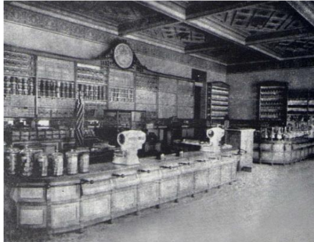
Figura 45: Salão interno da Fábrica Palmeira para vendas em atacado, reformado por José Sidrim em 1924, após o incêndio.
