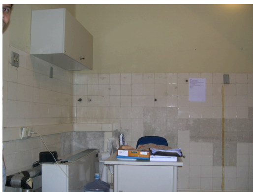
Figura 10- Sala interna do Pavilhão Mourisco Fonte: Acervo DPH/COC
