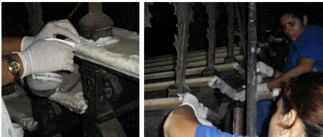
Figuras 29 e 30- Detalhe do procedimento de limpeza cuidadoso do mármore da escada principal do Pavilhão Mourisco.
