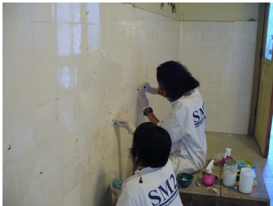
Figura 18- Sala 109 durante os serviços de reintegração dos painéis de azulejos. O trabalho é realizado por restauradoras, com acompanhamento do controle de qualidade e da fiscalização do DPH, sendo registrado e documentado segundo processo próprio da manutenção. Fonte: acervo DPH/COC
