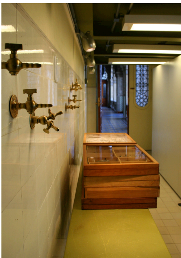
Figura 19- Sala interna do Pavilhão Mourisco após a conclusão do restauro de azulejos. Na imagem notamos que saídas de tubulação original do laboratório foram preservadas. Após o restauro a presença dos azulejos torna-se mais facilmente aceito pelos usuários.
