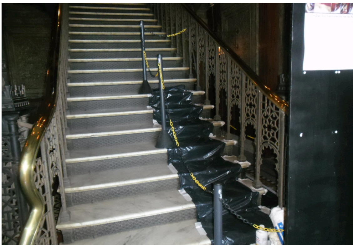
Figura 28- Limpeza profunda do mármore da escada executada em fases.
