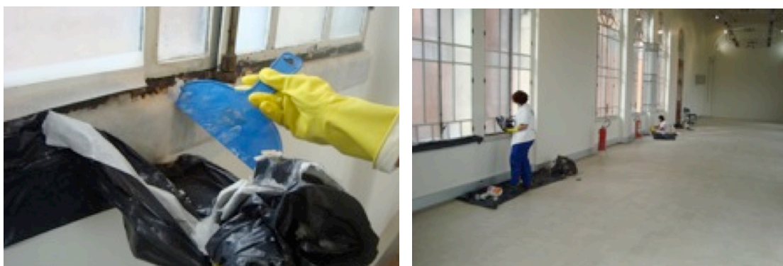
Figuras 26 e 27 - Limpeza seguida de aplicação de cera protetora sobre os mármore da sala de exposições do terceiro pavimento do pavilhão Mourisco.
