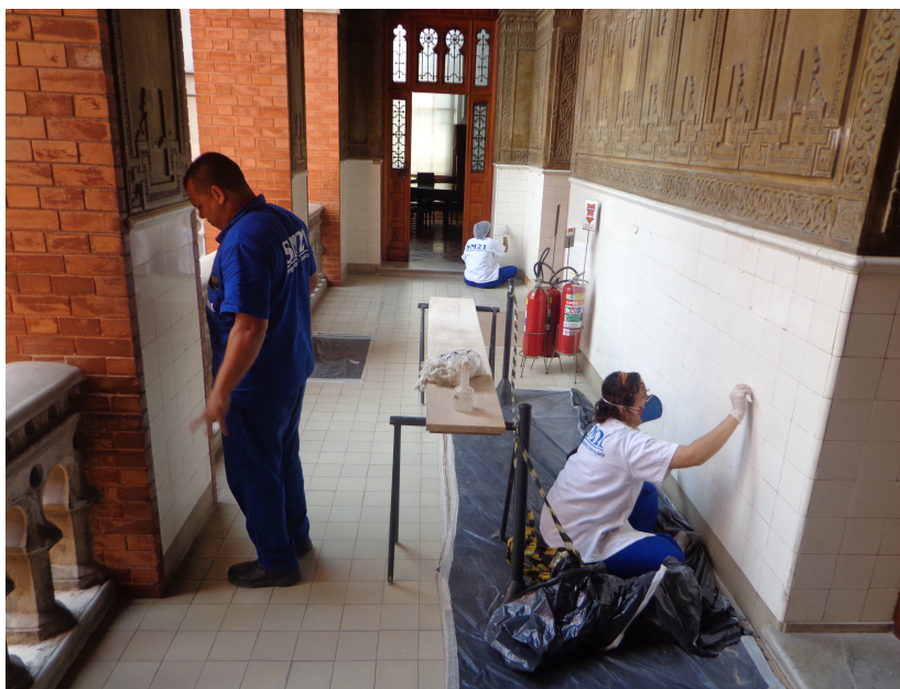
Figuras 37 - Exemplos de Prática de intervenção no painel de azulejos. Fonte: Acervo DPH/COC
