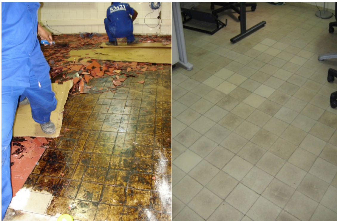
Figuras 16 e 17- Sala 104 durante os serviços preliminares de recuperação e aspecto do piso grés após a intervenção. Fonte: acervo DPH/COC
