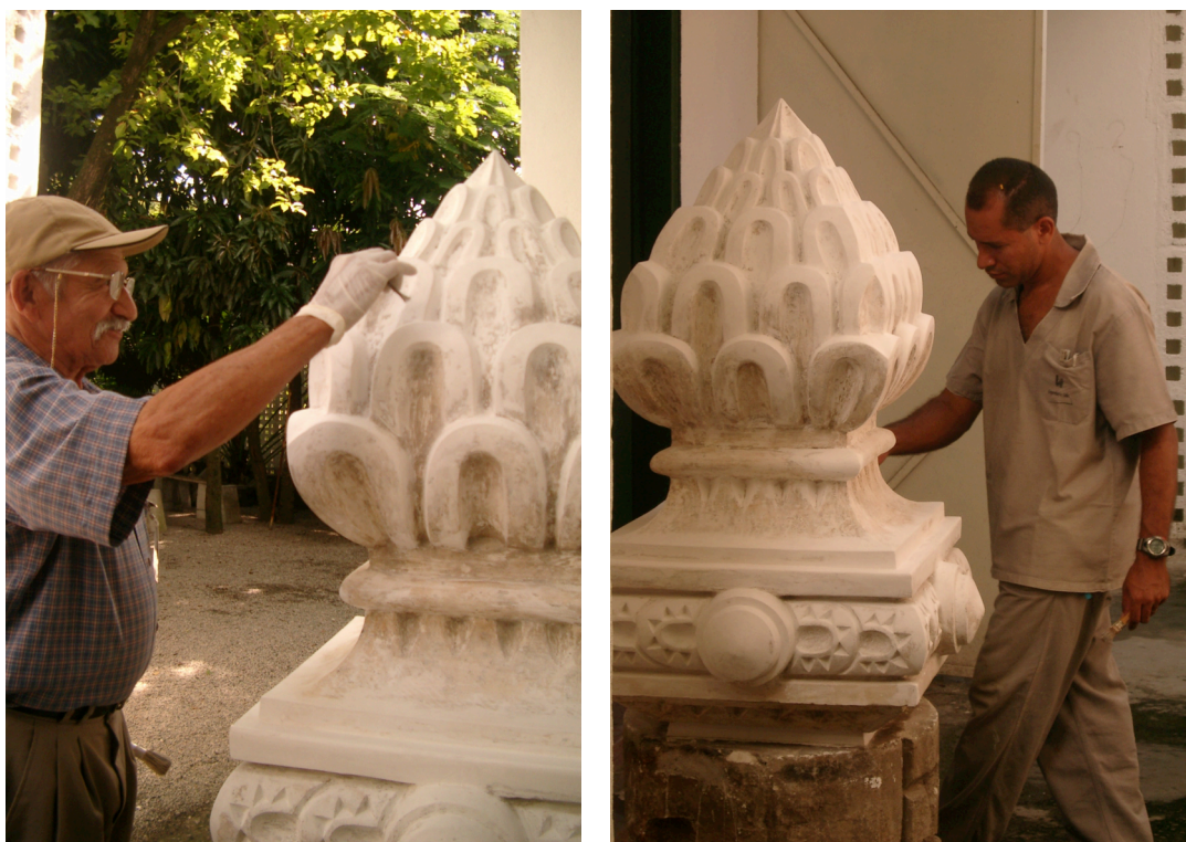
Figuras 15 e 16- Exemplo de atividade profissional especializada: confecção de forma para elementos ornamentais do coroamento do Pavilhão Mourisco, atividade coordenada por mestre artífice contratado pelo DPH e executada por pedreiro de fino acabamento da empresa terceirizada de conservação.
