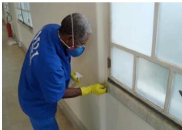
Figura 24 e 25- Mármore dos peitoris das janelas. Exemplo de conservação preventiva Fonte: Acervo DPH/COC
