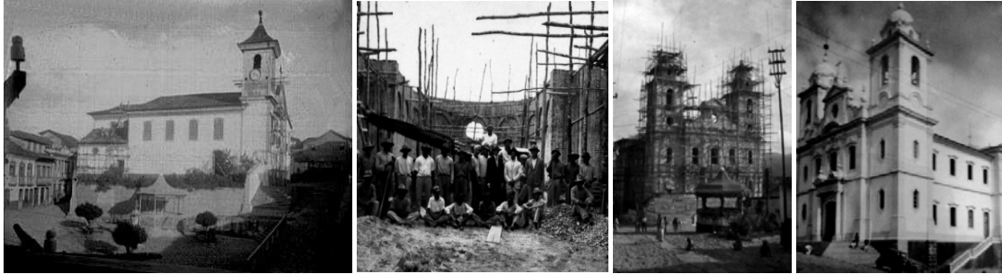
Imagens 52, 53, 54 e 55 – respectivamente: [52] Igreja de Santo Antônio (primeira metade do século 20). Fotografia: “Zé da Sé”. Fonte: Adevanilde F.P. Moraes. [53] Operários na construção do novo templo. Fonte: ACI/RJ-SI apud GONÇALVES: 2010 p. 58. [54] Sé em construção e [55] Sé inaugurada. Fotografias: “Zé da Sé”. Fonte: Adevanilde F.P. Moraes.
