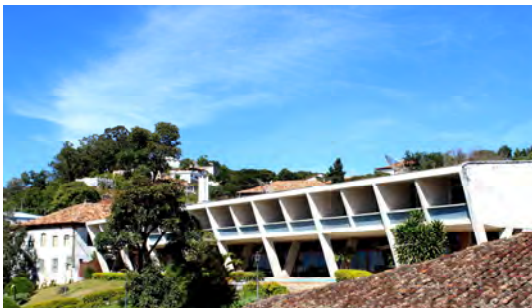
B.2 Vista parcial do Hotel Tijuco
