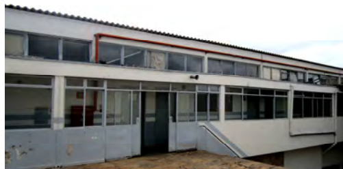
D.11 Vista parcial do Pátio Interno.
