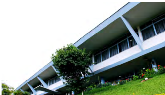
C.2 Vista parcial da Fachada Frontal.
