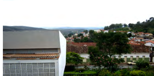
C.13 Fachada posterior da Escola e jardim.
