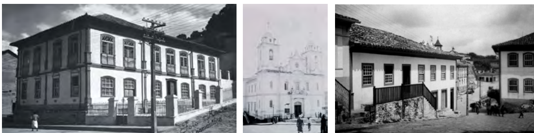
Imagens 109, 110 e 111 – respectivamente: [109] Vista parcial do Fórum. (s/d). Fotografia: Assis Horta. Fonte: Arquivo Público Mineiro. [110] Vista parcial da Catedral de Santo Antônio (década de 1940). Fotografia: Autor desconhecido. Fonte: Arquivo Público Mineiro. [111] Vista parcial da Casa do Padre Rolim. (1948). Fotografia: W.J. Craig. Fonte: IPHAN/Programa Monumenta (2010).
