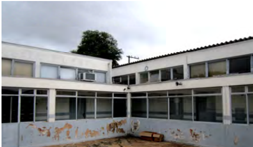
D.10 Vista parcial do Pátio Interno.
