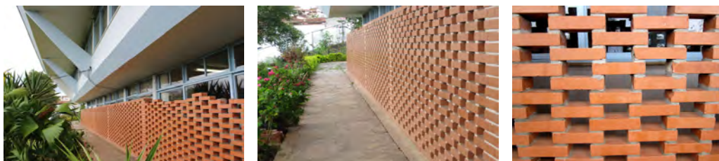
Imagem 166, 167 e 168 – respectivamente: Tijolos laminados com assentamento alternado presentes em uma das extremidades da fachada frontal. Fotografias: Ana Alice Rocha (2013).
