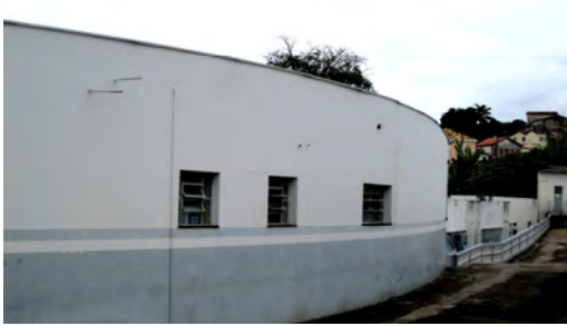
D.8 Vista parcial posterior da Faculdade.
