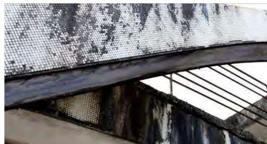
A.12 Detalhes da Estrutura
