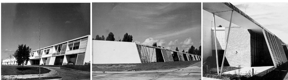
Imagens 121, 122 e 123 – respectivamente: Tipologias diversas do CTA (Centro Técnico da Aeronáutica). Fonte: www.niemeyer.org.br - Acessado em 15/06/2013.
