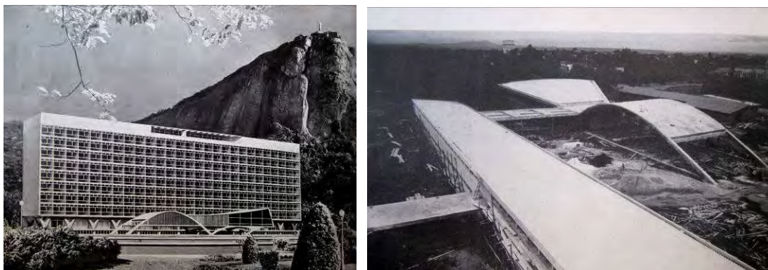
Imagens 88 e 89 – respectivamente: [88] Hospital Sul América / RJ (1952) http://ihm.nlm.nih.gov ; [89] Colégio Estadual Campo Grande (1953) http://niemeyer.org.br (Acessadas em 04/06/2013).
