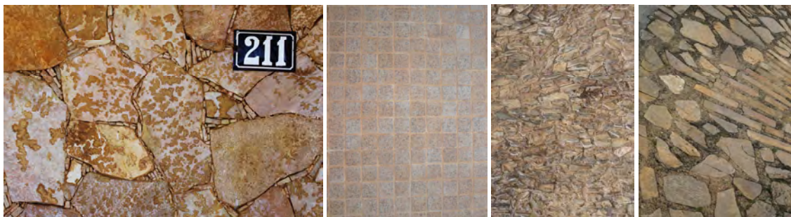
Imagens 140, 141, 142 e 143 - respectivamente: Principais materiais vistos no hotel : [140] quartzito em canjicado em um trecho da fachada frontal; [141] pastilhas cerâmicas dos pilares em “V”; [142] pavimentação tipo pé-de-moleque no pilotis e [143] quartzitos no porte cochère . Fotografias: Ana Alice Rocha (2013).
