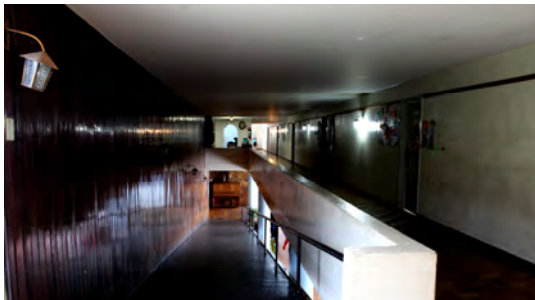
C.9 Rampa e Circulação do Pavimento Superior.
