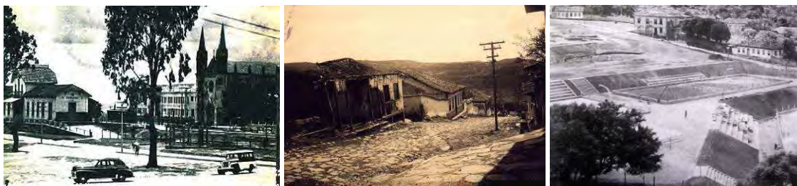
Imagens 66, 67 e 68 – respectivamente: [66] Vista parcial do Largo Dom João, com a presença da Basílica do Sagrado Coração de Jesus, do Seminário Episcopal do Sagrado Coração de Jesus e da Estação Ferroviária. Fotógrafo: “Zé da Sé”. [67] Vista parcial da Rua São Francisco. Imagens da primeira metade do século XX. Fotógrafo: “Zé da Sé”. Fonte: Adevanilde F.P. Moraes. [68] Vista parcial da “Praça de Esportes Minas Gerais” (Década de 1940) Fotógrafo desconhecido. Acervo: Secretaria de Cultura, Turismo e Patrimônio de Diamantina.
