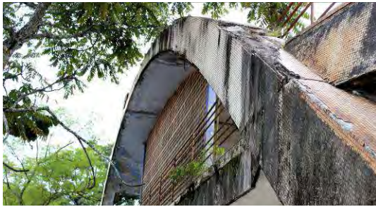
A.8 Detalhes da Estrutura
