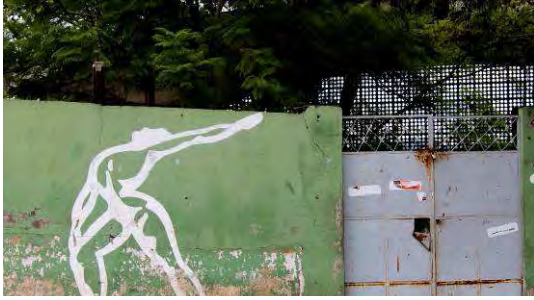
A.13 Presença de muro na Fachada Posterior
