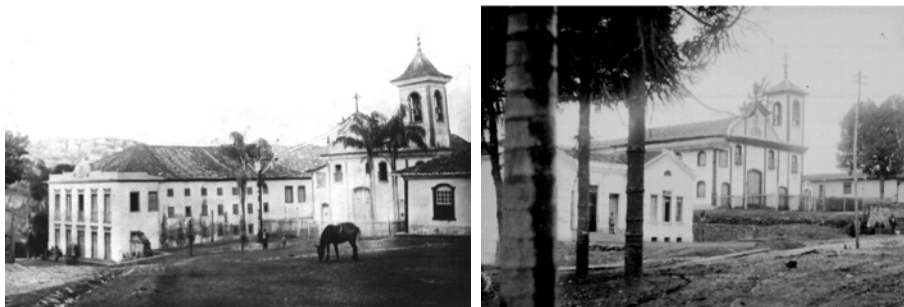
Imagens 47 e 48 – respectivamente: [47] Teatro Santa Isabel (demolido em 1914). Fotografia: “Zé da Sé”. Fonte: Adevanilde F.P. Moraes. [48] Cadeia Pública de Diamantina (construída em 1916 – no mesmo local do teatro destacado). Fonte: Acervo Chichico Alkimim - Centro de Memória Fevale/MG.
