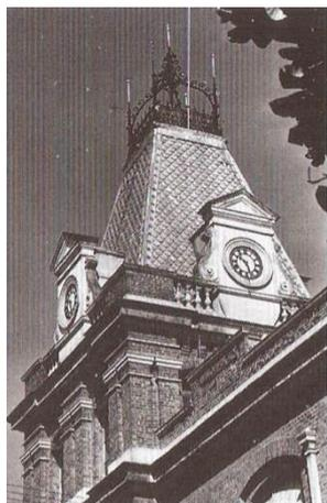
Figura 81 - Cobertura em escama metálica arrematada por rendilhado. Fonte: Czajkowski, 2000, p. 127.
