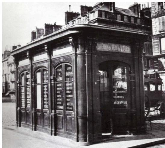
Figura 6 – Cabine em ferro fundido para a venda de passagens de ônibus. Place de la Bourse, Paris, 1866. Fonte: Loyer, 1988.
