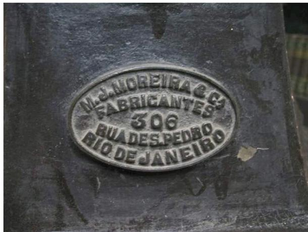
Figura 127 – Placa de identificação presente na base de todas as colunas . Fonte: foto da autora, 2013.
