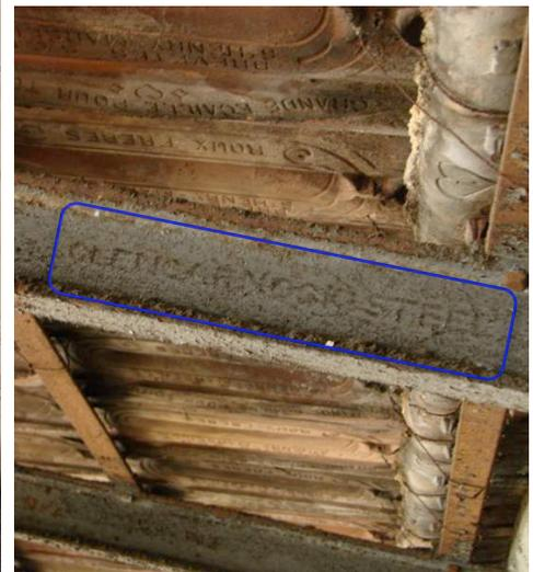
Figura 141 – Identificação do fabricante dos perfis em aço. Fonte: Foto da autora, 2007.
