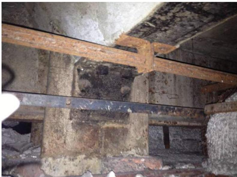
Figura 163 – Prospecção em um dos pilares da Ala A, com a chegada das vigas I 20” e I 12”. Fonte: Foto da autora, 2013.
