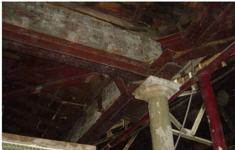
Figura 9 – Apoio de estrutura metálica em coluna revestida. Cobertura do Theatro Municipal do Rio de Janeiro de 1909. Fonte: Foto da autora, 2009.
