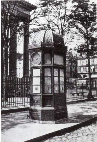
Figura 61 - Quiosque em ferro fundido. Um dos tantos modelos disponíveis em catálogo. Fonte: Loyer, 1988.
