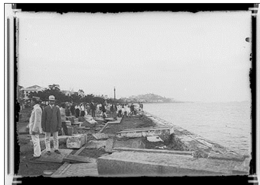
Figura 32: Destruição da murada do Flamengo por ressaca, em 1905 ( http://icaatom.coc.fiocruz.br , out,2013)
