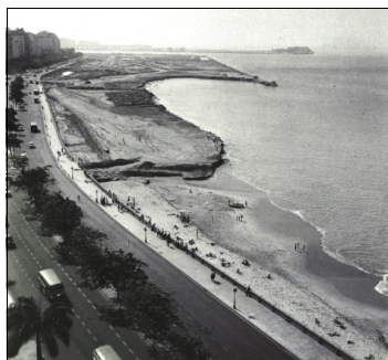
Figura 102: Praia do Flamengo - aterro em execução (Agência O Globo, 1952, (Infoglobo Comunicações e Participações S.A., 2012))
