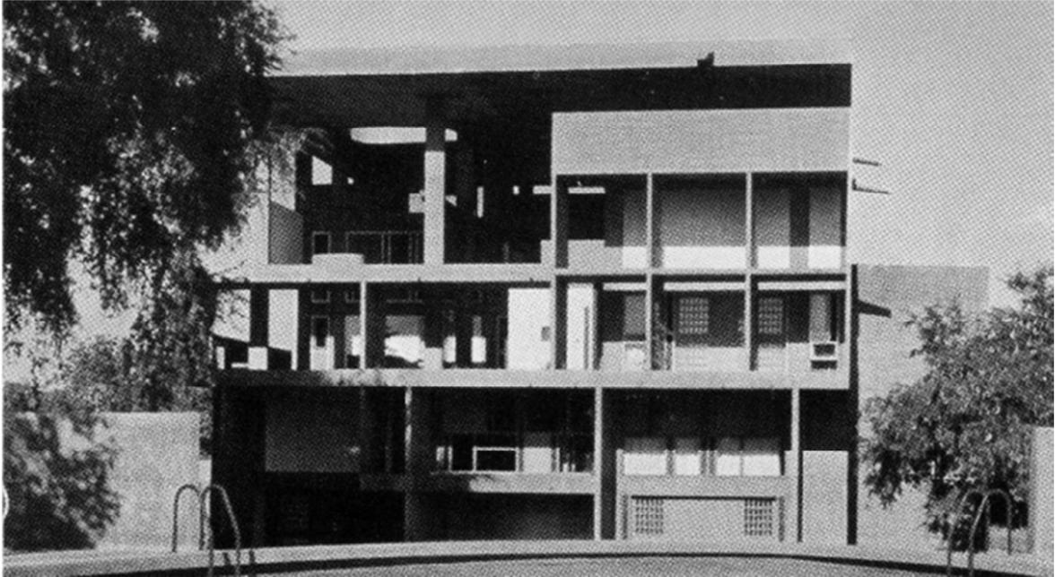
Figura 61 – Composição matemática na máscara dos brises e espaços de transição gerados pela sobrecobertura. Fachada sudoeste.
