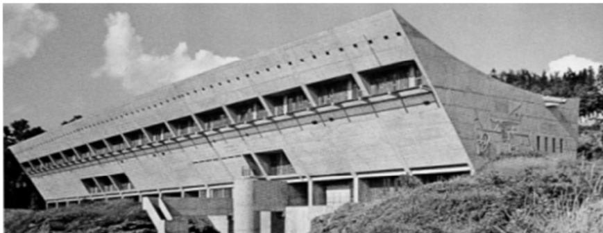
Figura 71 – A forma angular da fachada oeste redistribui a radiação por uma maior superfície.
