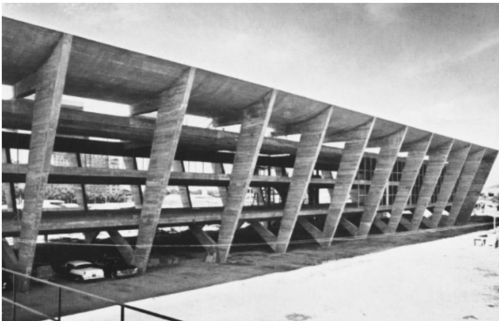
Figura 140 MAM (1953) Estrutura independente se transforma em “estrutura-brise”.
