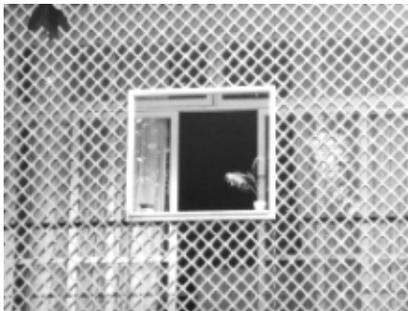
Figura 86 – Membrana em cobogós e fachada interna envidraçada – edifício Caledonia (1954)
