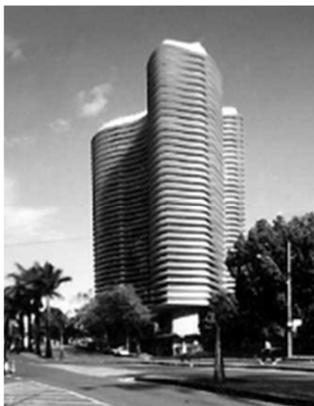
Figura 111 – Edifício Niemeyer (1954) – Planta fluida com solução de brises integrais.
