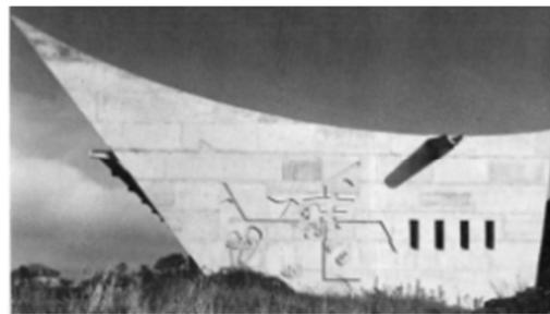
Figura 11 – A Casa da Juventude e da Cultura - Firminy (1956-1961). Forma como proteção solar. Inclinação para a fachada sul (equivalente solar à orientação norte no hemisfério sul).
