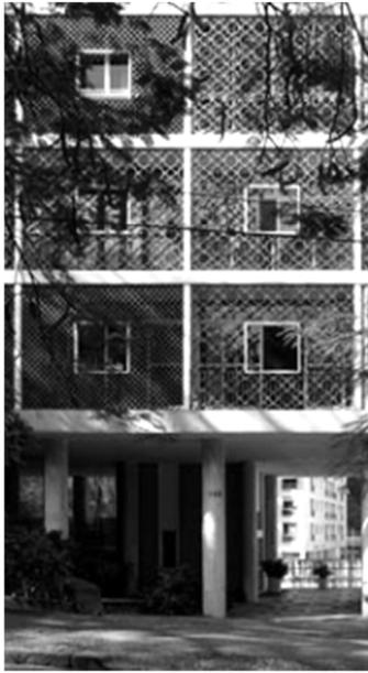
Figura 171 – Parque Guinle - Lucio Costa – elementos de controle ambiental (cobogós, brises e varandas) formam uma membrana de filtro.
