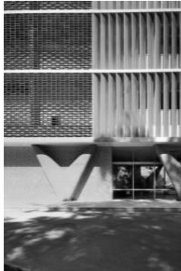
Figura 172 - Hospital da Lagoa Niemeyer (1952) – Membrana que alterna cobogós e brises.
