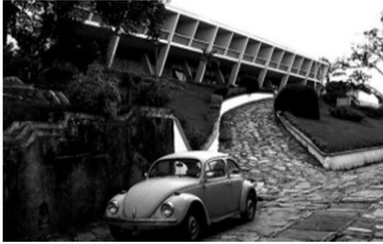
Figura 100 – Hotel Tijuco (1951). A torção vertical da estrutura permite o substancial avanço da cobertura e da varanda.
