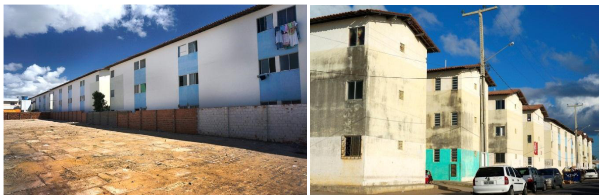
Figura 108: Edifícios multifamiliares do Programa de Arrendamento Residencial (PAR), em Maceió-AL . Fonte: Adolphe, 2013).
