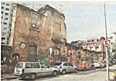
Na Av. Mem de Sá, no Centro, corredor de fachadas em ruínas que se equilibram sem telhado nem paredes internas e sobrados malconservados
