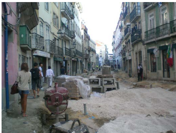
Figura 11 – Rua em obras no Bairro da Mouraria Fonte: foto do autor (2013)
