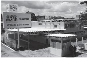
ou pequenos pilares, a uma altura mínima de 50cm do solo para permitir a manutenção das instalações localizadas na parte inferior do piso. Na parte interna, o piso é de compensado naval, coberto por manta vinílica específica para uso hospitalar. A unidade modular tem cobertura de telhas galvanizadas.
