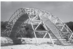
Ponte localizada sobre o rio Gardon no sul da França, construída a partir de 281 perfis de tubos de papelão, forte o suficiente para transportar 20 pessoas por vez.
