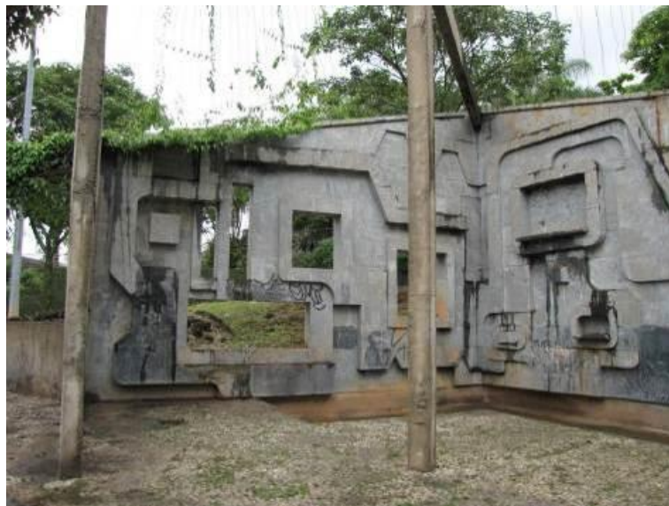
Fig. 136: Praça Alberto Dalva Simão, Belo Horizonte, MG. Painel de concreto. Fonte: Acervo particular. Autoria da foto Júlio Ono (dez. 2009).
