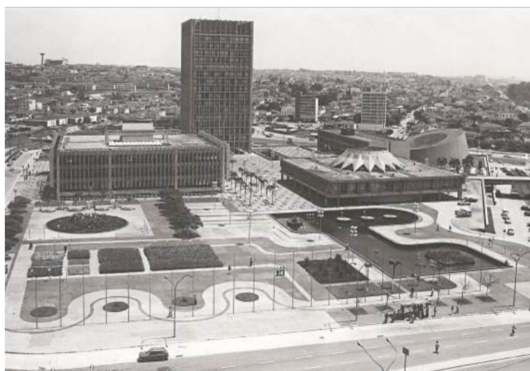
Fig. 35: Centro Cívico de Santo André, SP. Foto aérea. Fonte: Tabacow (2004, p. 29). Acervo Instituto Moreira Salles. Autoria da foto Marcel Gautherot.
