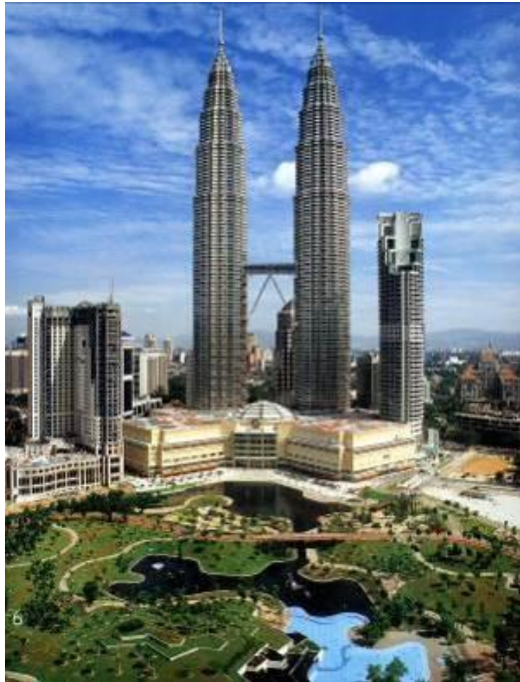
Fig. 63: KLCC Park e Petronas Twin Towers, Kuala Lumpur, Malásia. Fonte: Acervo Burle Marx & Cia. Ltda.
