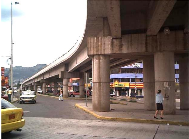
Fig.16-Viaduto - Av. Maldonado y Alonso de Angulo (Villa Flora) QUITO
