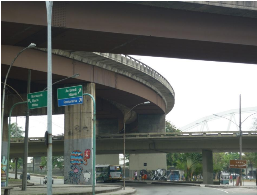
Fig.12-Projeto demolição do viaduto da Perimetral (Rio de Janeiro).
