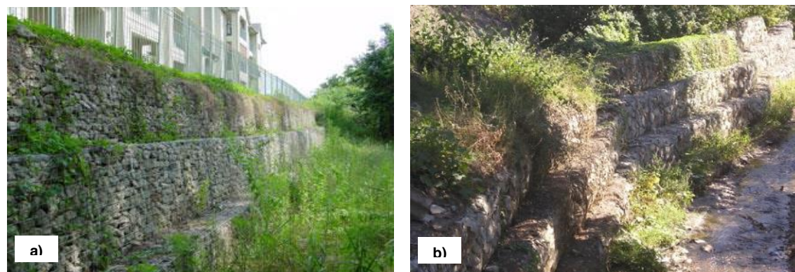
Figura 42 – Muro de gabião vegetado (F: a) http://www.gabionbasket.org/gabions/gravity-walls.html ; b) http://krim-proekt.com.ua/index.php?option=com_content&view=article&id=4&Itemid=4&lang=en , acesso em: 30 Jul. 2013).
