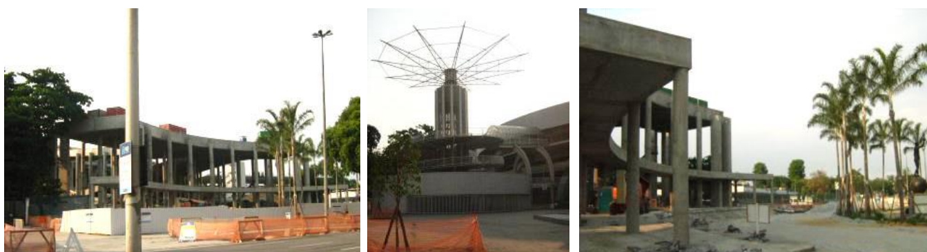
Figura 24 - Vistas do Complexo Esportivo Maracanã em obras (Autoria: Autora, 2012).
