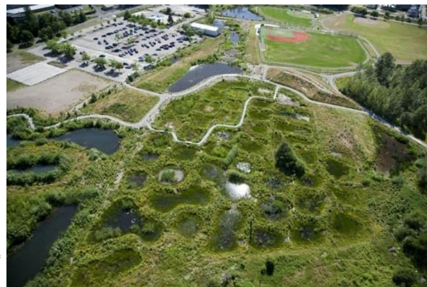
Fig. 177: Referência de Alagados Construídos: Magnusson Park Wetland, Washington. Fonte: www.lafoundation.org
