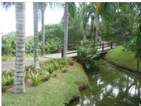
Fig. 13: Detalhe da ponte sobre o canal.
