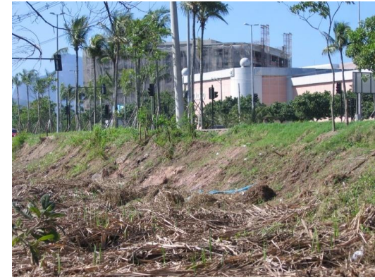
Fig. 94: Imagem antes da finalização do aterramento no limite do Centro Metropolitano com a Avenida Abelardo Bueno. Detalhe do desnível existente entre a área à ser aterrada com a via que já foi aterrada. Acervo da autora. Ano 2007.
