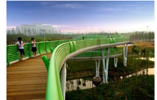
Fig. 144: Passarela sobre áreas alagadas
