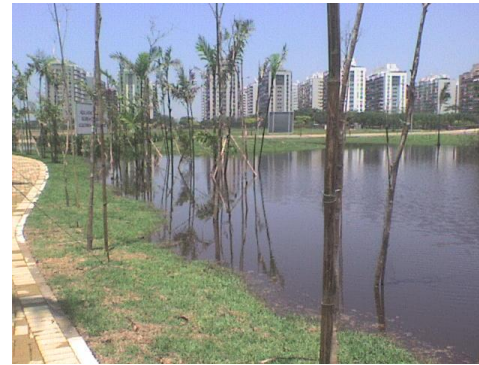
Fig. 90: Panorama parcial da ausência de drenagem no solo provocando alagamento nas áreas verdes do Condomínio Cidade Jardim, cuja implantação sobre área alagada. Detalhe da área alagada com espécies vegetais (palmeiras, arvores e grama) especificadas para o local que morreram após o excesso de água no solo. Ano: 2009. Acervo da autora
