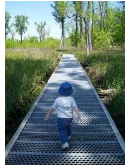
Fig. 142: Passarela de aço vazada
