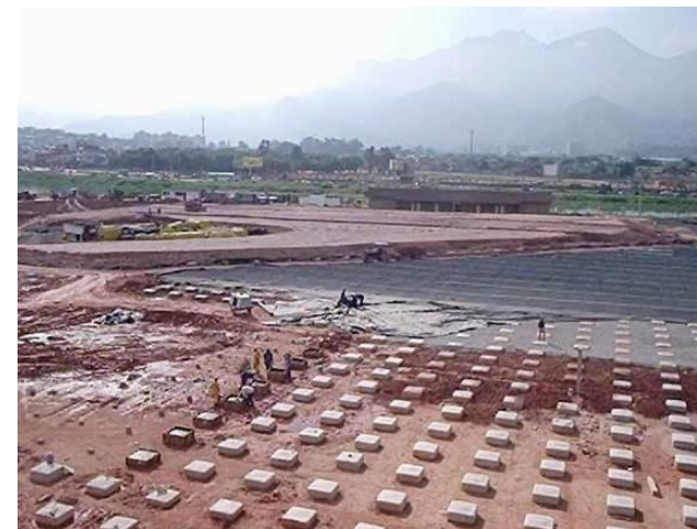
Fig. 84: Imagem inicial da implantação da escola. Detalhe das estacas implantadas e o aterro sendo realizado. Fonte: www.sescm.com.br .
