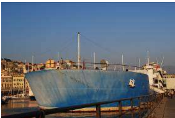
Fig. 52 Padiglione Italia , nos fundos do Acquario .
