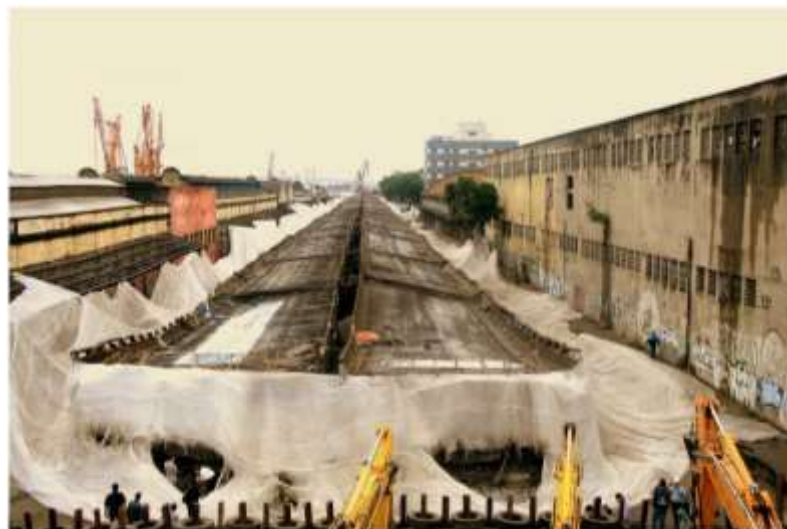
Fig. 94 Implosão do Viaduto da Perimetral
