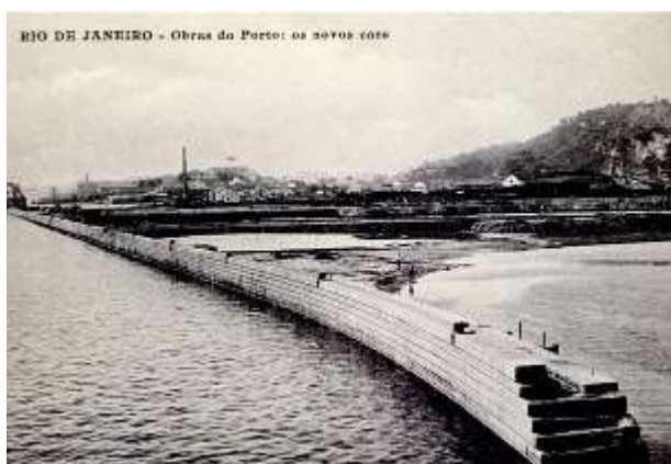
Fig. 69 Construção da Muralha do novo porto. Início do século 20.
