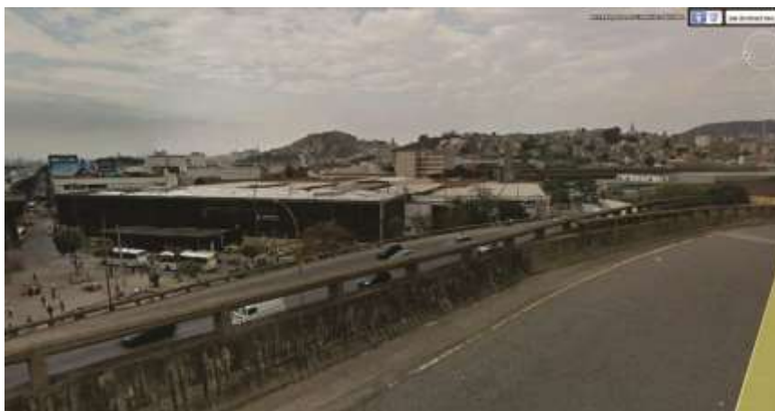
Fig. 127 Vista atual da estrada da Av. Francisco Bicalho.
