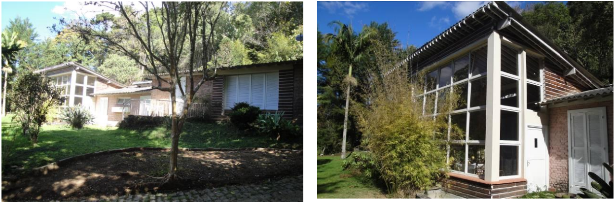
Figura 97 e 98: Fotografias da residência de David Xavier Azambuja. Com projeto de sua autoria e detalhe para utilização, originalmente, exclusiva do material cerâmico da Cerâmica Parque São Clemente. A exemplo, na foto ampliada, das manilhas para passagem água, utilizadas neste trecho como tijolinhos decorativos.
