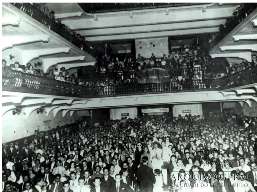
Figura 36- Interior do Cinema Íris após a reforma do projeto de 1920 (s/d). Fonte: AGCRJ.
