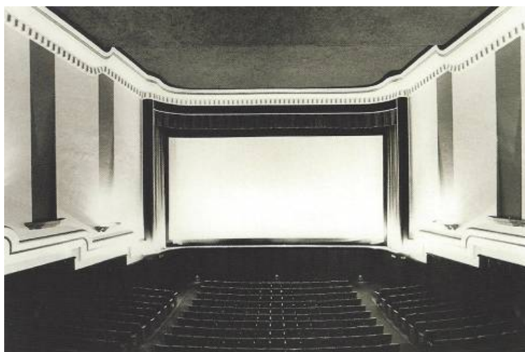
Figura 54– Interior do cinema e visibilidade da tela de projeção. Fonte: Cine Vitória Arquitetura e Cultura.
