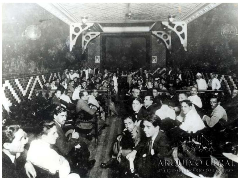
Figura 27– Interior do Cinema Íris antes das obras de ampliação (s/d). Fonte: AGCRJ.
