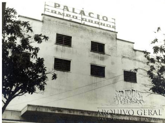
Figura 15- Fachada do Cine Palácio Campo Grande, construído em 1962 (s/d). Fonte: AGCRJ.
