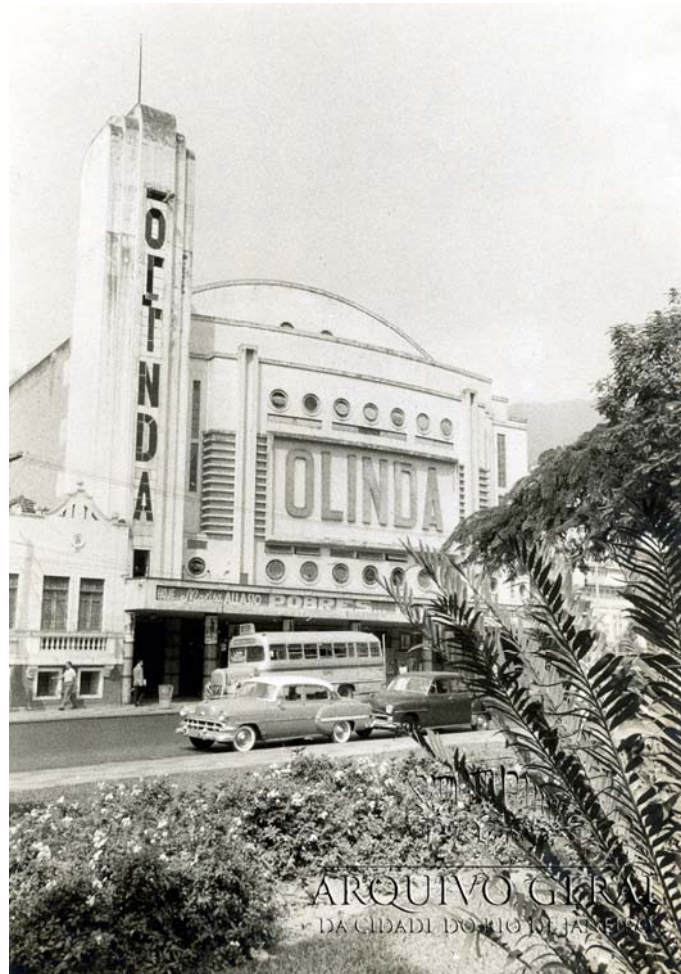
Figura 23– Cinema demolido na Praça Saenz Pena para ceder lugar a uma nova edificação (s/d). Fonte: AGCRJ.
