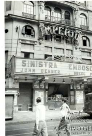
Figura 7- Fachada do Cinema Império (s/d). Fonte: AGCRJ.
