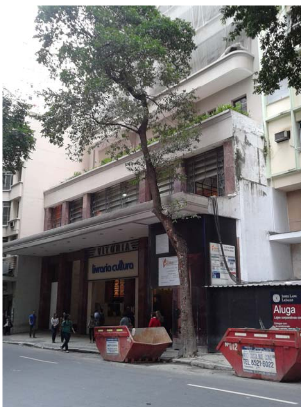
Figura 51– Livraria ocupando a antiga sala de exibição no embasamento do Edifício Rívoli (2013).
