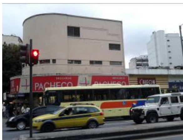
Figura 10- Fachada, modificada, do antigo Cineteatro América (2013). Foto: autor.
