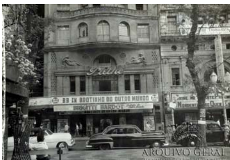
Figura 3- Fachada do Cinema Pathé- Palace (1958). Fonte: AGCRJ.
