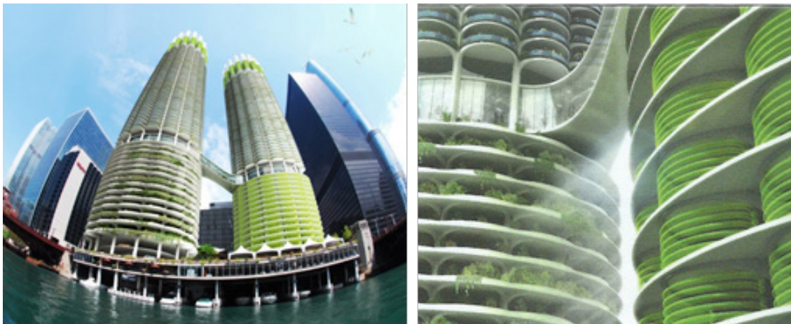
Figura 23. Aplicação de fotobiorreatores tipo serpentinas no estacionamento do projeto Green Loop. Fonte: HENRIKSON, R.; EDWARDS, M., 2012
