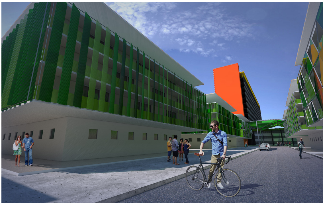
Figura 32. Fotobiorreatores verticais utilizados na fachada.
