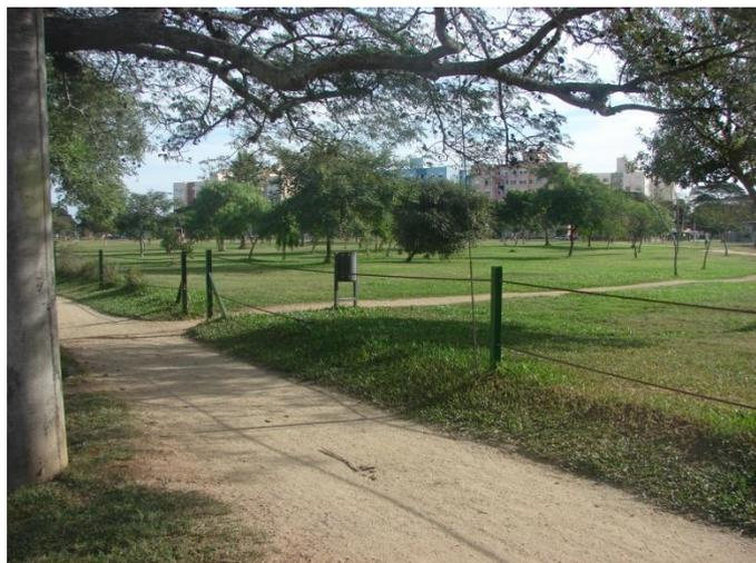
Figura MM33: cercamento em madeira e cabo de aço, altura média 90cm.
