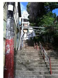
**Figura 76:** Escadaria construída no Programa Favela Bairro e bastante deteriorada alguns anos após a implantação do Programa. Foto: Hersen, 2012.
