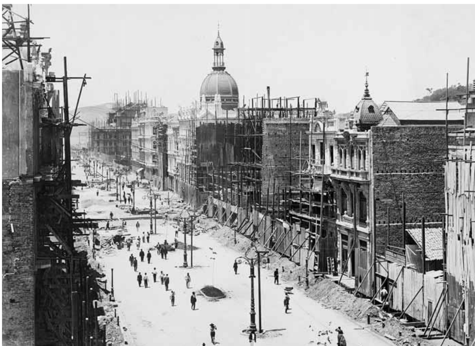
il. 56 Os novos edifícios da avenida Central em fase de construção, 1905.
