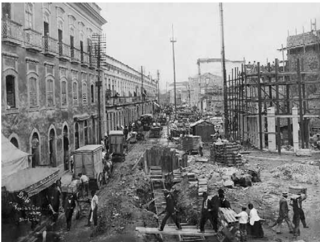
il. 31 Rua da Carioca - Remodelação do Rio de Janeiro. A construção de uma nova cidade. 31/01/1906.
