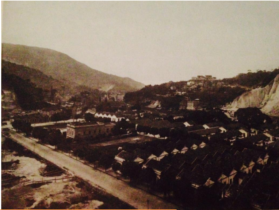
il. 30 Vila Operária da fábrica de Tecidos Alliança no início do século XX.
