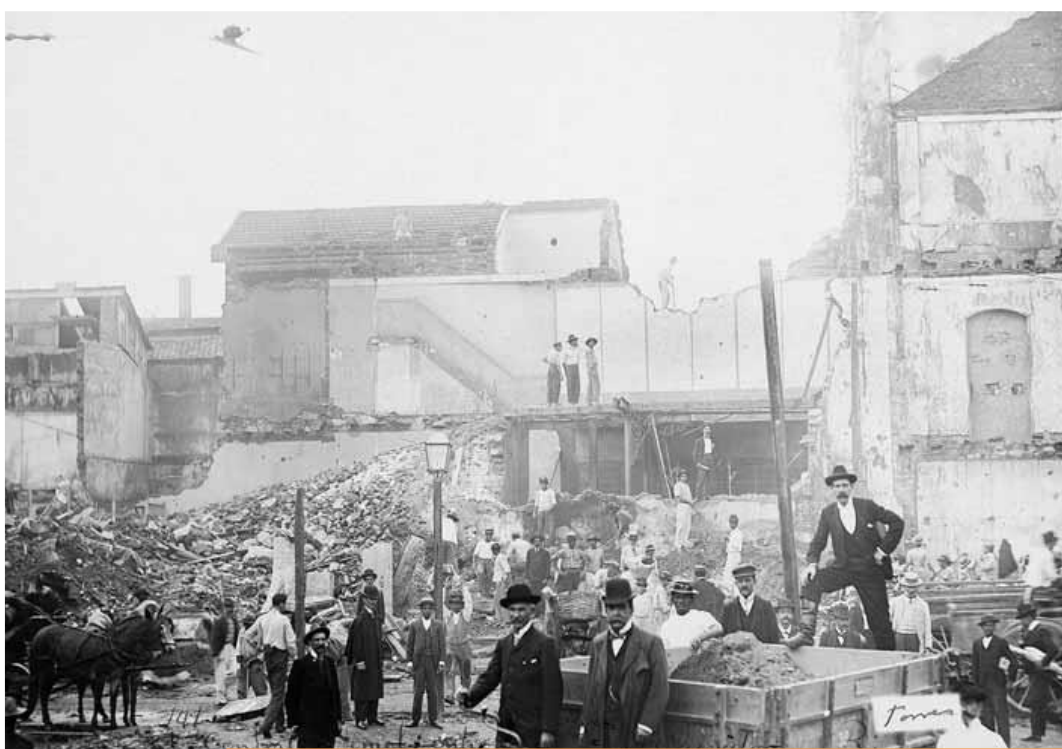
il. 34 Demolições para a construção da avenida Central, 1904-1905.
