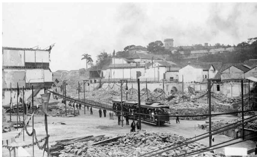
il. 35 Linha de bondes instalada no percurso das obras da avenida Central, c. 1904
