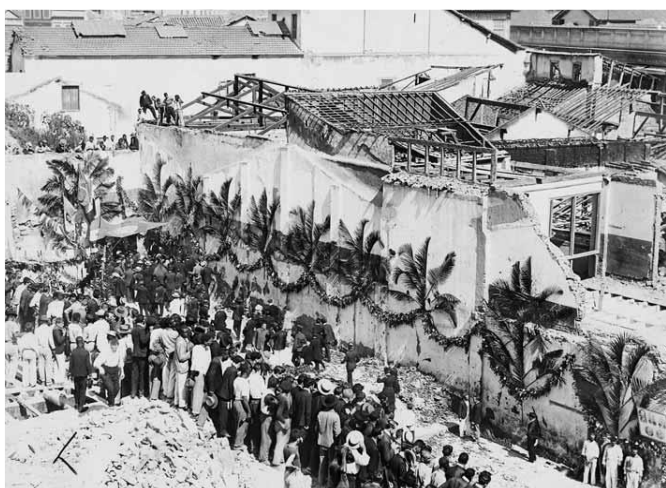
I. 13 início das obras de construção da avenida, 8 de março de 1904.
