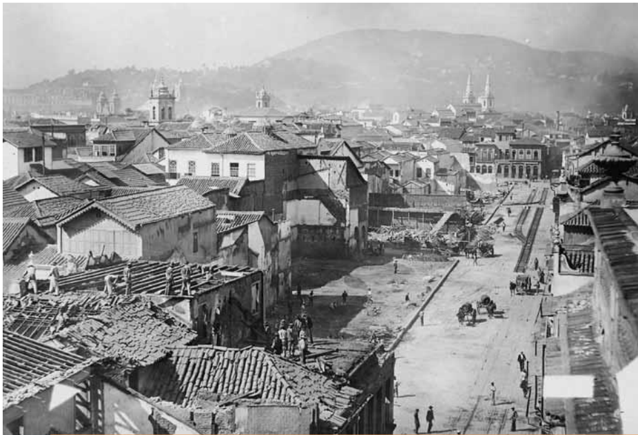
il. 55 O início dos trabalhos de abertura da Avenida Central (vista em direção à Prainha, atual Praça Mauá), 1904.
