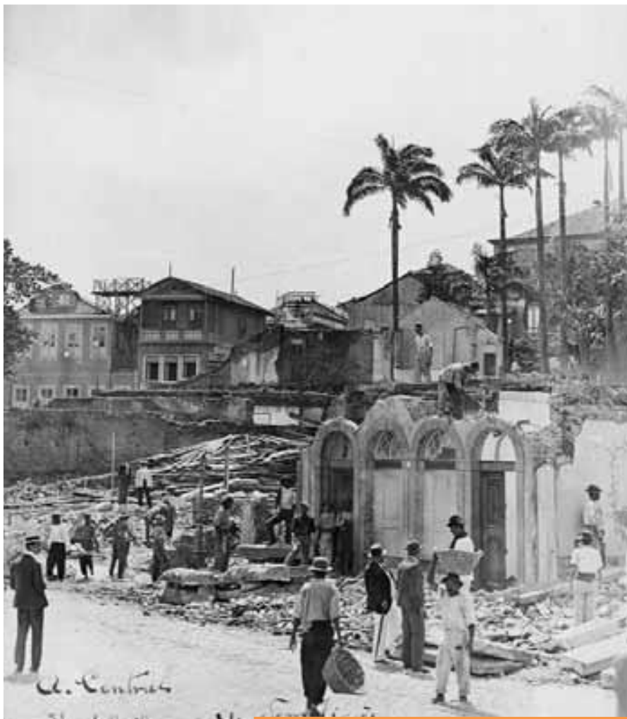
il. 42 Demolições na encosta do morro do Castelo, 1904.
