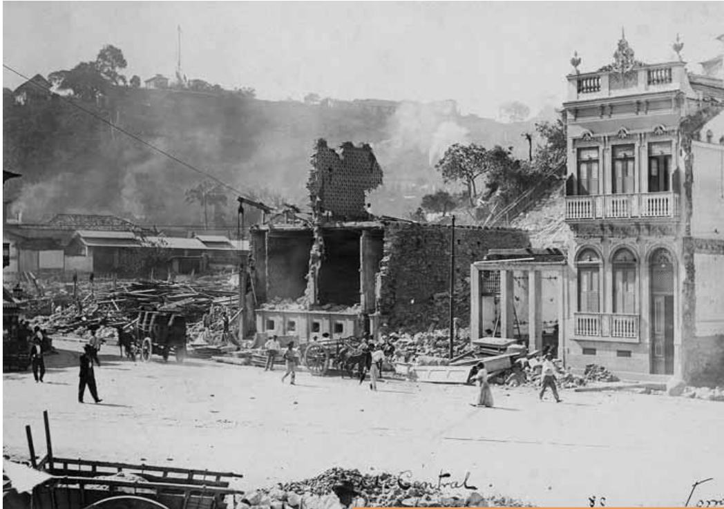
il. 41. Prédios já derrubados ou à espera da destruição, c. 1904-1905.
