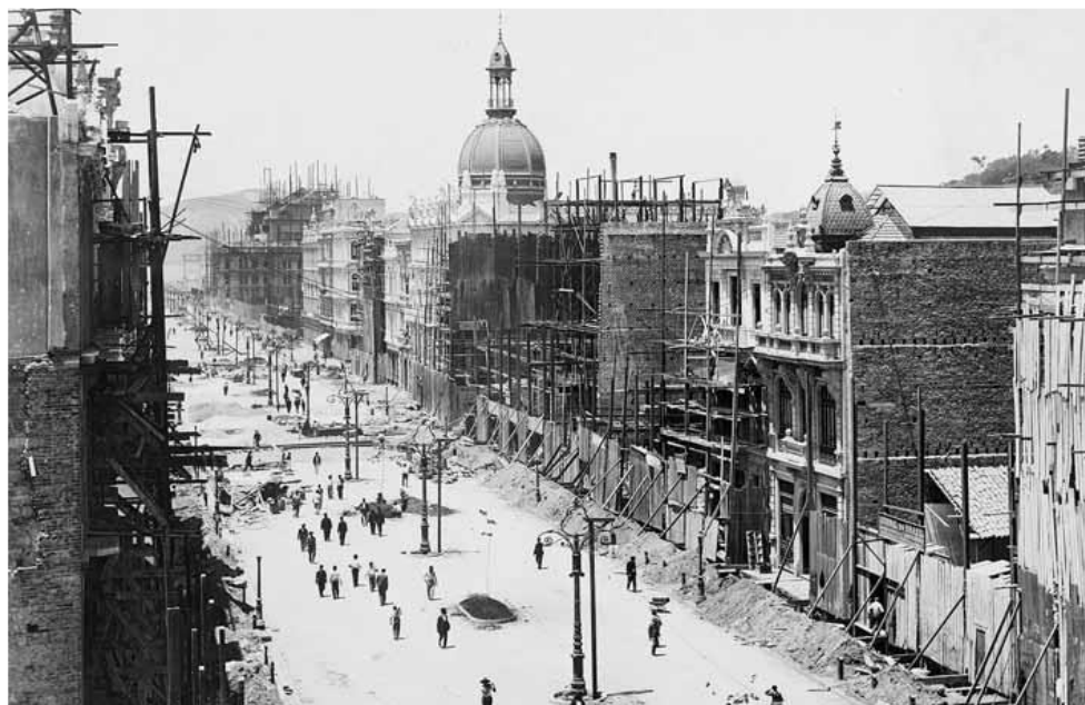
il. 8 Os novos edifícios da Avenida Central em fase de construção, 1905.
