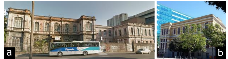
Figura 10. Hospital Francisco de Assis sobre Av. Presidente Vargas y Hospital Santa Casa el Calle Beatriz Larrangoiti. Fuente: Google.maps acceso 08/02/2014 y foto: VIVEROS, 2015
