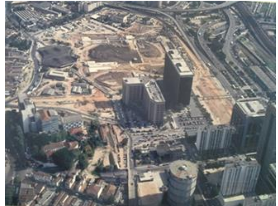
Figura 44. Intervenciones del metro. Fuente: Fotografías aéreas AEROCOLOR 1996
