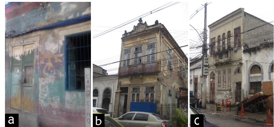
Figura 30. Deterioro que persiste en las edificaciones tradicionales de Cidade Nova. Fotos: VIVEROS, 2013,2014
