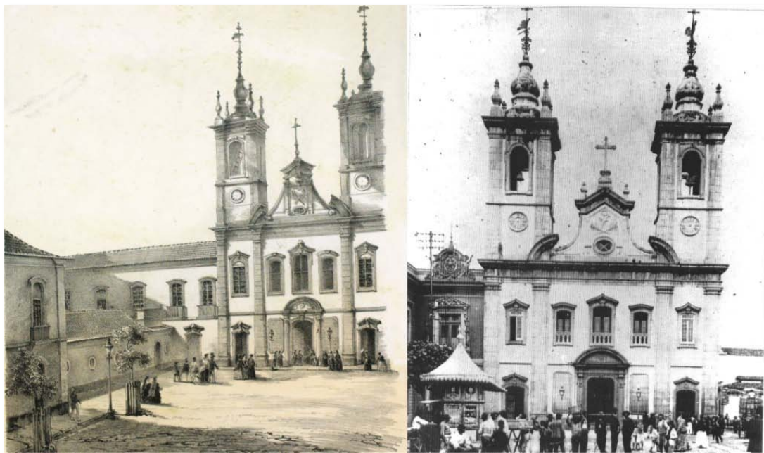
Figura 30 - Igreja de São Joaquim e Colégio Pedro Segundo, antes e depois da reforma de Bethencourt da Silva
