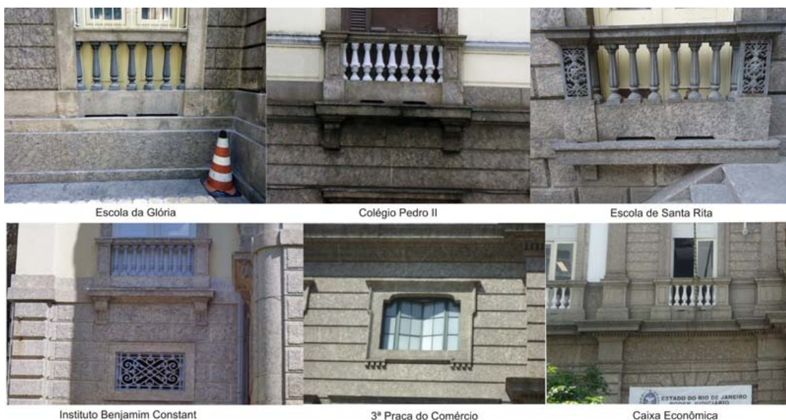
Figura 36 - Detalhe da abertura abaixo do guarda-corpo de diversas obras de Bethencourt da Silva.
