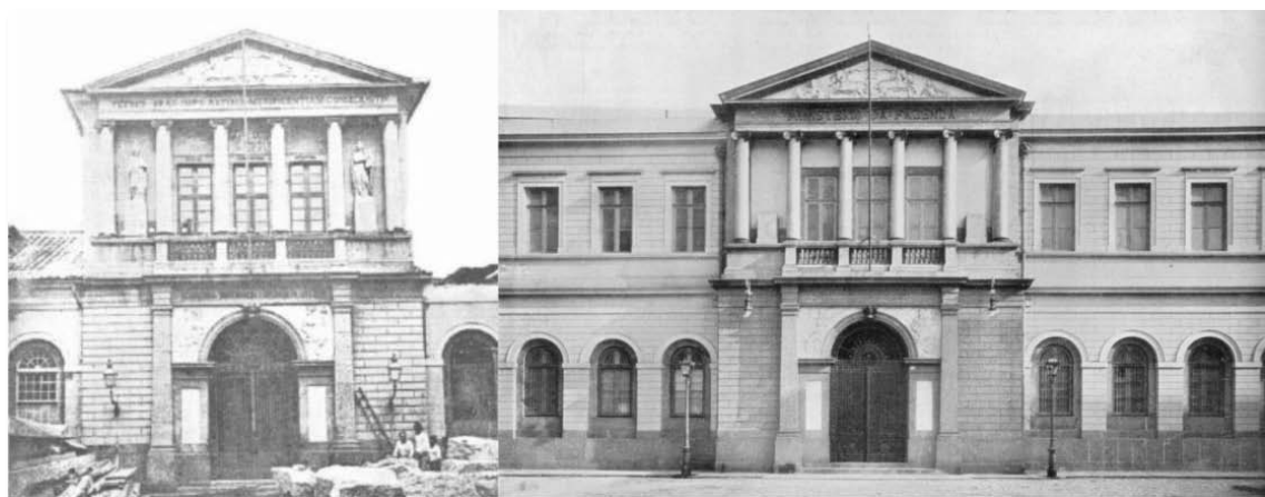
Figura 31 - Escola de Belas Artes antes e depois da reforma de Bethencourt da Silva. Fonte: Fotos de Marc Ferrez
