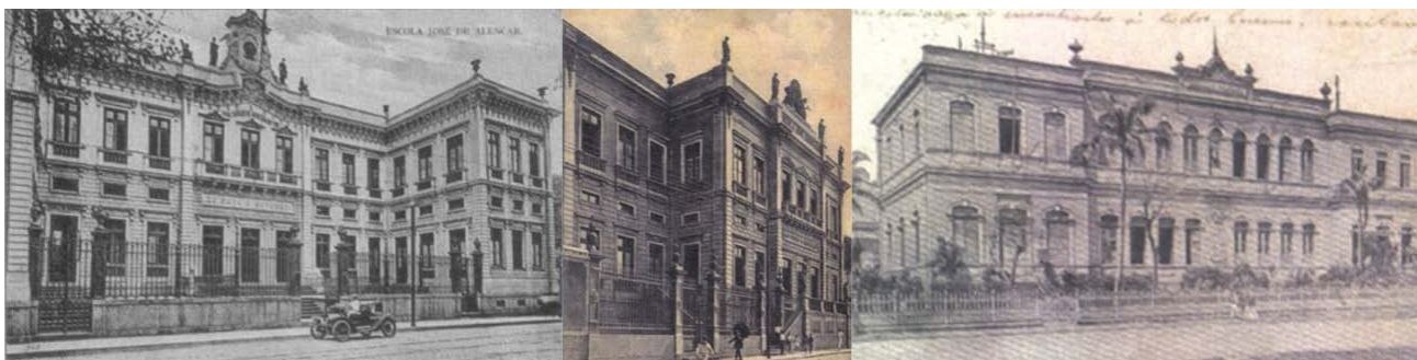
Figura 73 - Escola da Glória, Escola de Santa Rita e Escola Normal.
