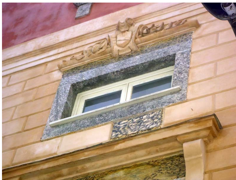
Figura 100 - Detalhe do fingimento de pedra das fachadas laterais da Escola da Glória segundo prospecção da última restauração executada pela Prefeitura do Rio de Janeiro. Fonte: da autora
