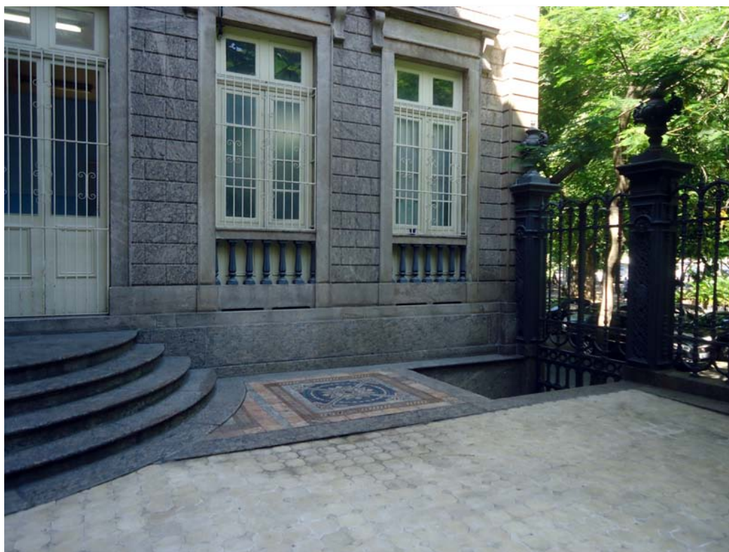
Figura 101 - Detalhe do piso em ladrilho hidráulico, acessos, janelas e gradis. Fonte: da autora
