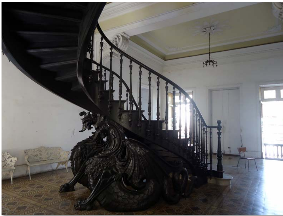
Figura 102 - Escada de madeira localizada na Escola de Santa Rita. Fonte da autora.
