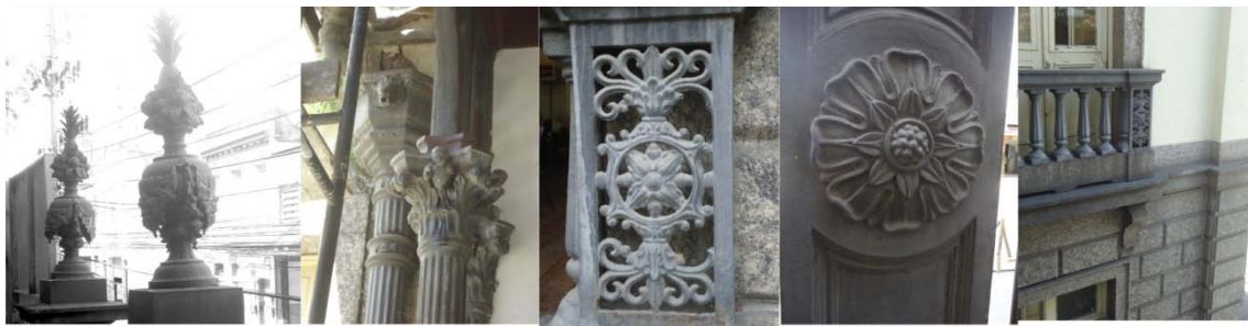
Figura 37 - Detalhes de ornamentos em ferro utilizados por Bethencourt na Escola de Santa Rita
