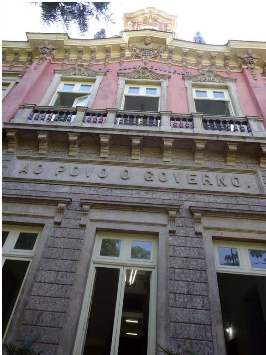
Figura 94 - Detalhe da Fachada da Escola da Glória. Fonte da autora
