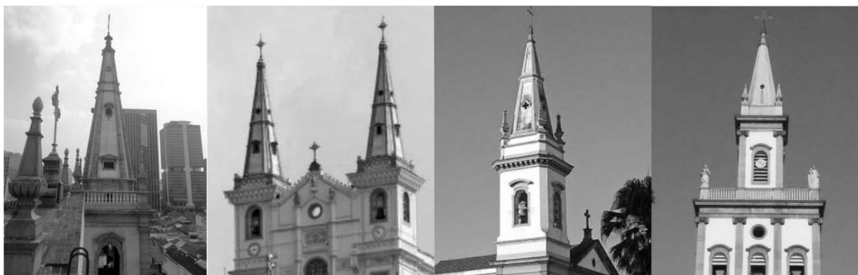
Figura 63 - Da esquerda para direita: Igreja do Santíssimo Sacramento, Igreja de N. S. da Penha, São Gonçalo Garcia e a Matriz de N. S. da Glória.
