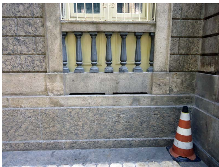
Figura 90- Detalhe da cantaria da Escola da Glória e da abertura sob o guarda corpo com balaustradas de ferro. Fonte: da Autora
