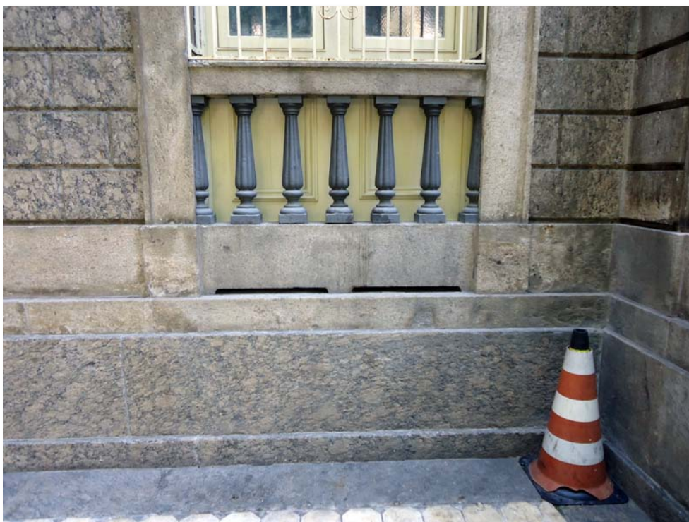
Figura 99 - Detalhe do uso de diferentes granitos e detalhe da abertura na cantaria abaixo do guarda-corpo das janelas. Fonte: da Autora.
