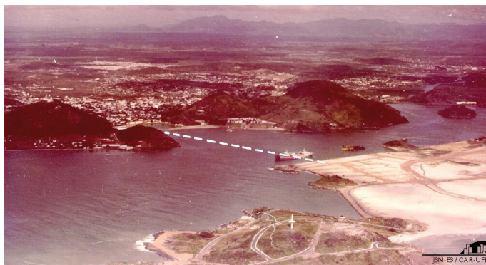
Figura 73. Baía de Vitória em 1976. À direita aterro da Enseada do Suá em andamento. Fonte: Instituto Jones dos Santos Neves em Memória Visual da Baía de Vitória, 1CD.
