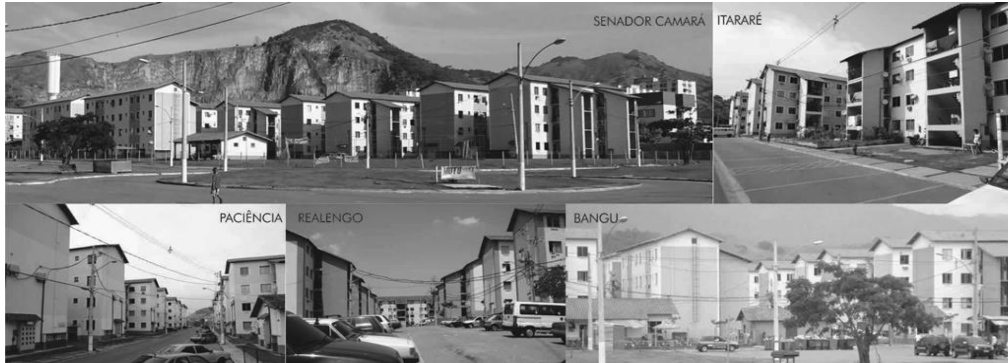
Figura 16: Condomínios habitacionais do PMCMV, faixa de 0-3SM, implantados em diferentes regiões da cidade do Rio de Janeiro. Fonte: Laboratório Habitação e Forma Urbana, 2013.
