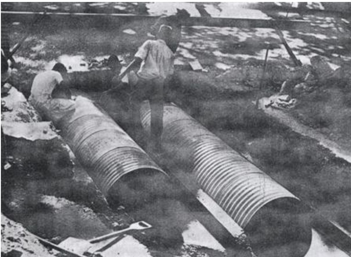
Fig.32 – Foto tirada na ocasião das obras de construção das galerias na Praia de Botafogo em 1940, compressão do macadame.
