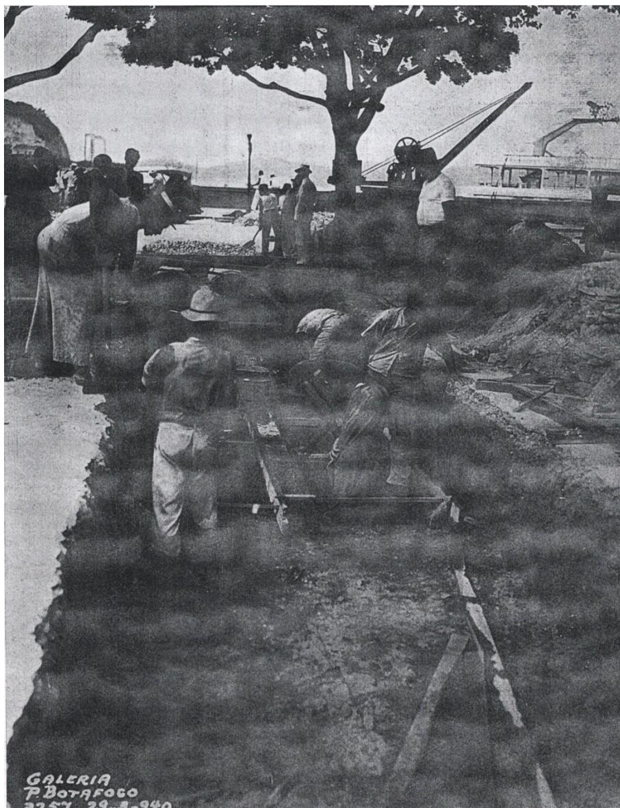
Fig.29 – Foto tirada na ocasião das obras de construção das galerias na Praia de Botafogo em 1940, colocação dos dutos.
