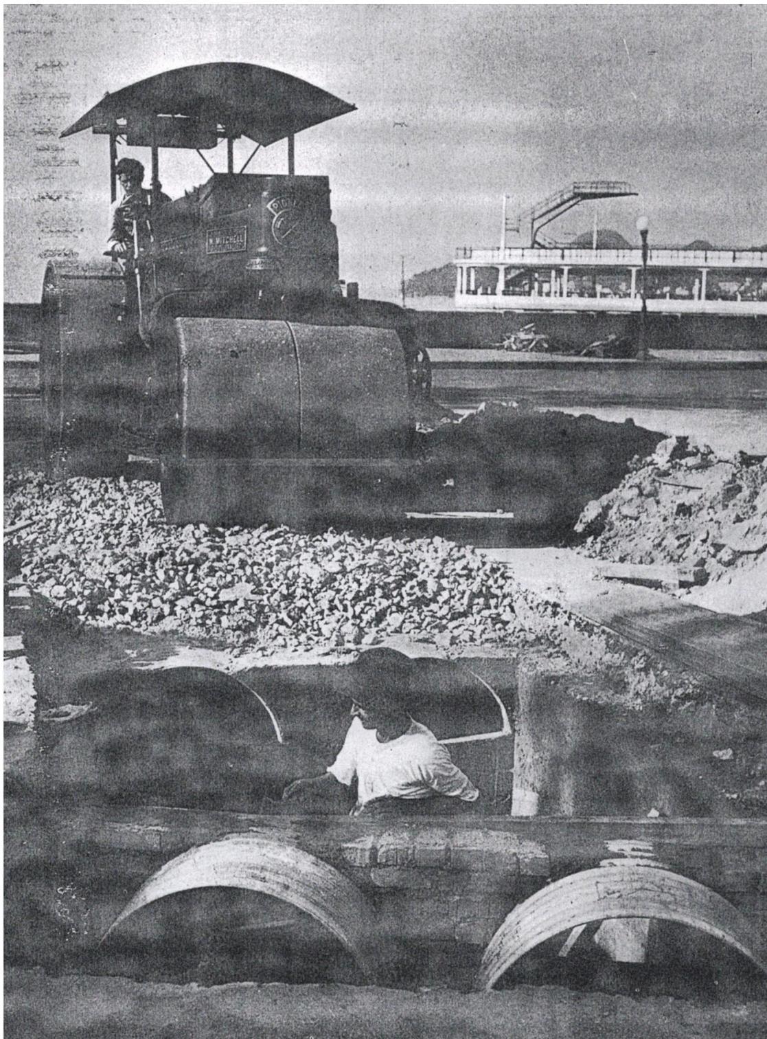
Fig.33 –. Foto tirada na ocasião das obras de construção das galerias na Praia de Botafogo em 1940, dificuldades na travessia sob as linhas de carris da época.
