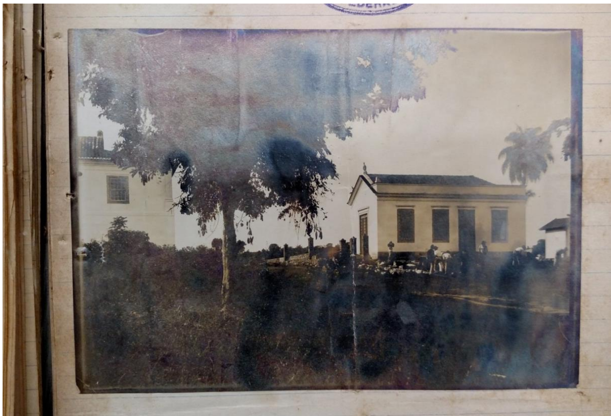
II. 62: Construção do muro entre o necrotério, a esquerda da foto e a Matriz, a direita da foto. 226
